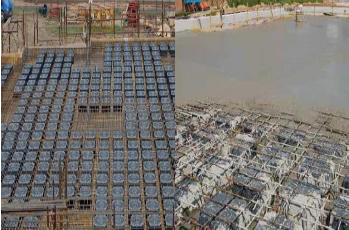
Şekil 3.15. Kör kalıp dizilimi ve beton dökümü
