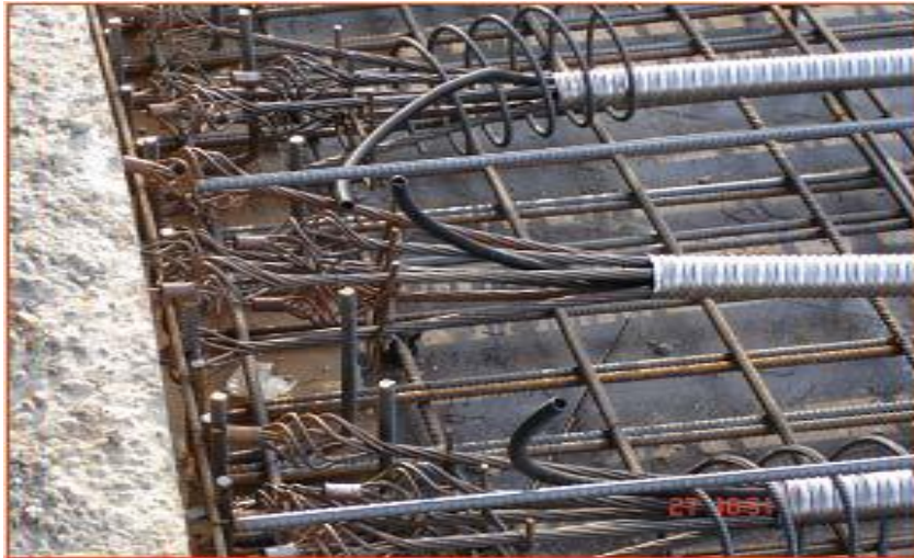
Şekil 3.10. Kör ankraj ile halatların kilitlenmesi
