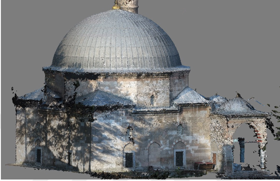
Şekil 5.5 İHA verisinden üretilmiş nokta bulutu, güneydoğu aksonometrik görüntüsü
