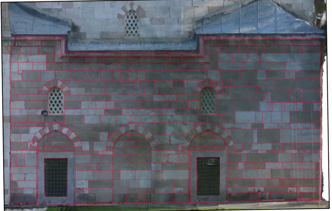
Şekil 6.6 Ortofoto üzerinde gerçekleştirilen rölöve çizimi
