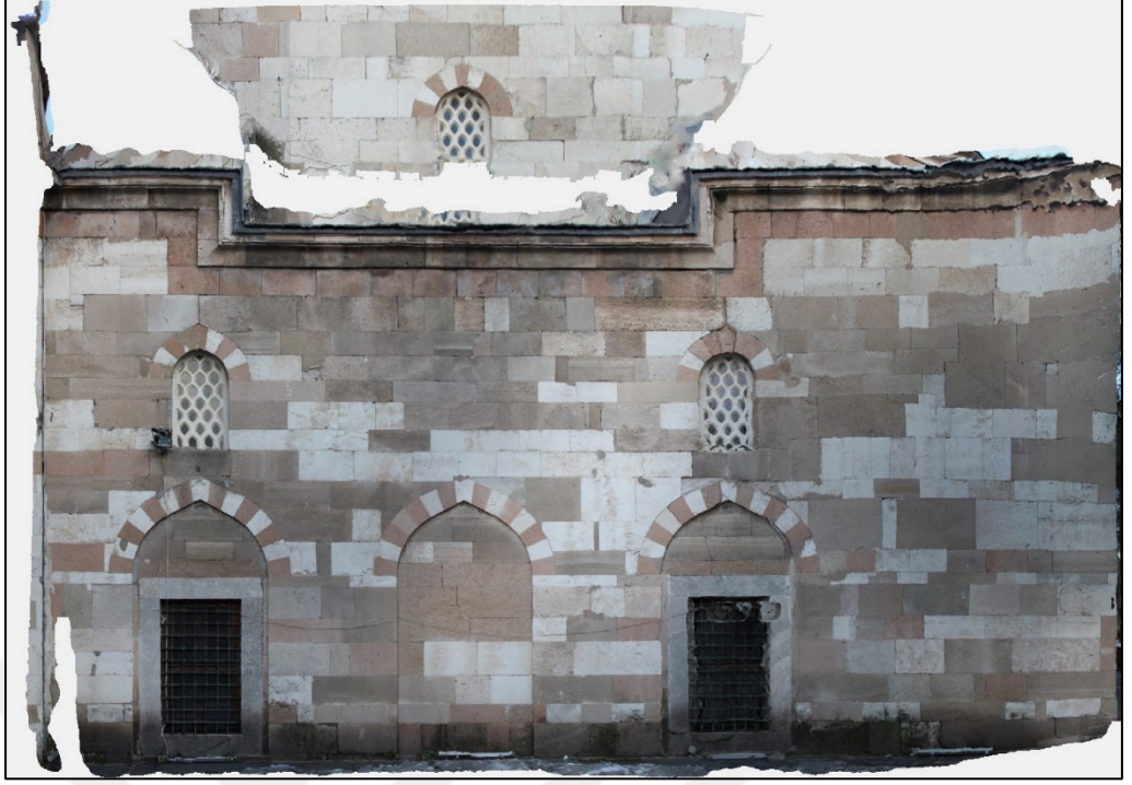
Şekil 6.8 Elle çekilen fotoğraflardan üretilmiş ortofoto
