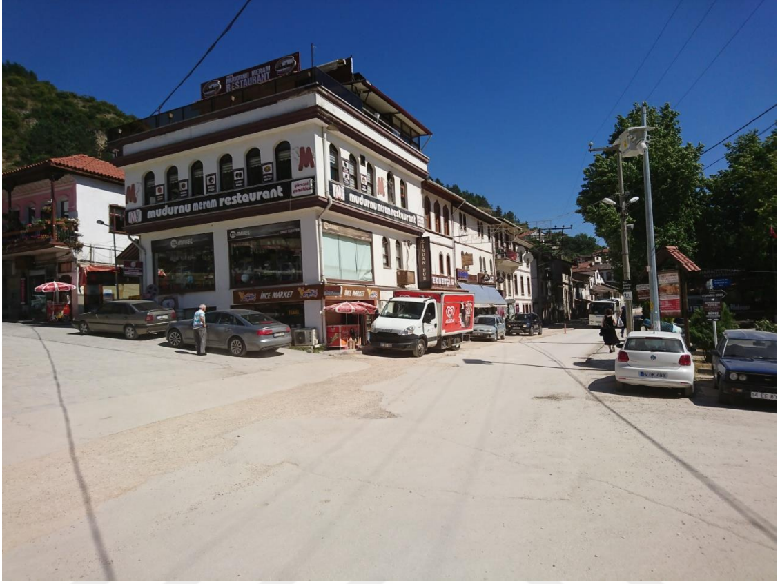
Şekil 4.7. Yıldırım Bayezid Caddesi kuzey cephe fotoğrafı
