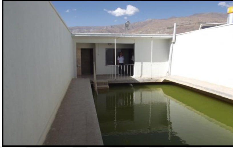
Fotoğraf 36. Kaplıca Odalarından Bir Görünüm.
