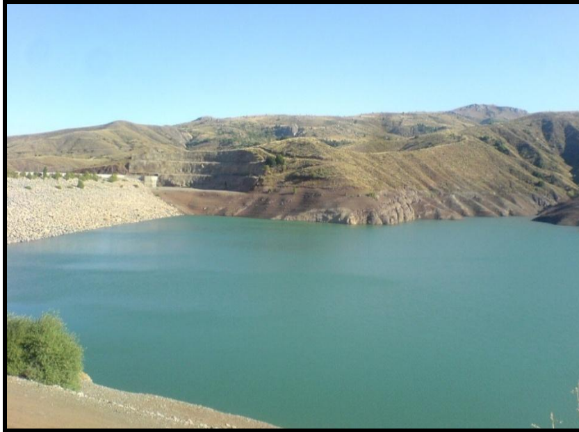
Fotoğraf 42. Göyne Barajından Bir Görünüm.
