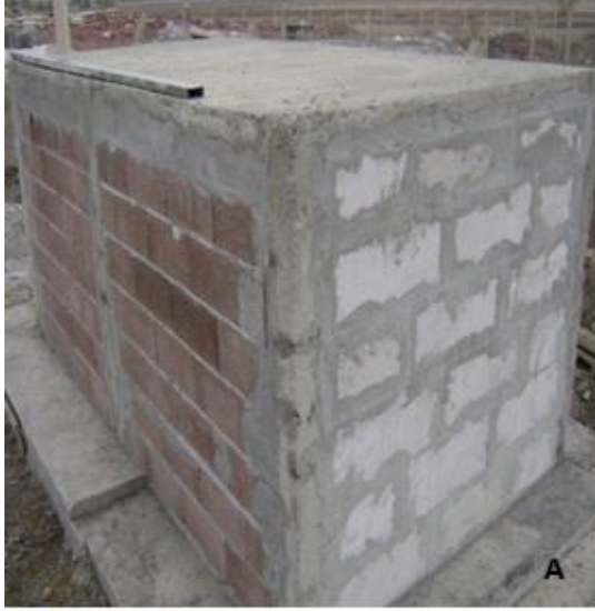
A: Yapının bims örülü doğu cephesi
