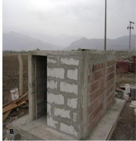
B: Yapının bims örülü batı cephesi
