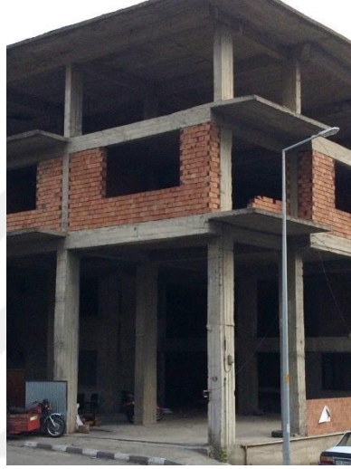
Şekil 2.12. Zemin kat yüksekliği diğer katlardan fazla olan bir betonarme yapı.
