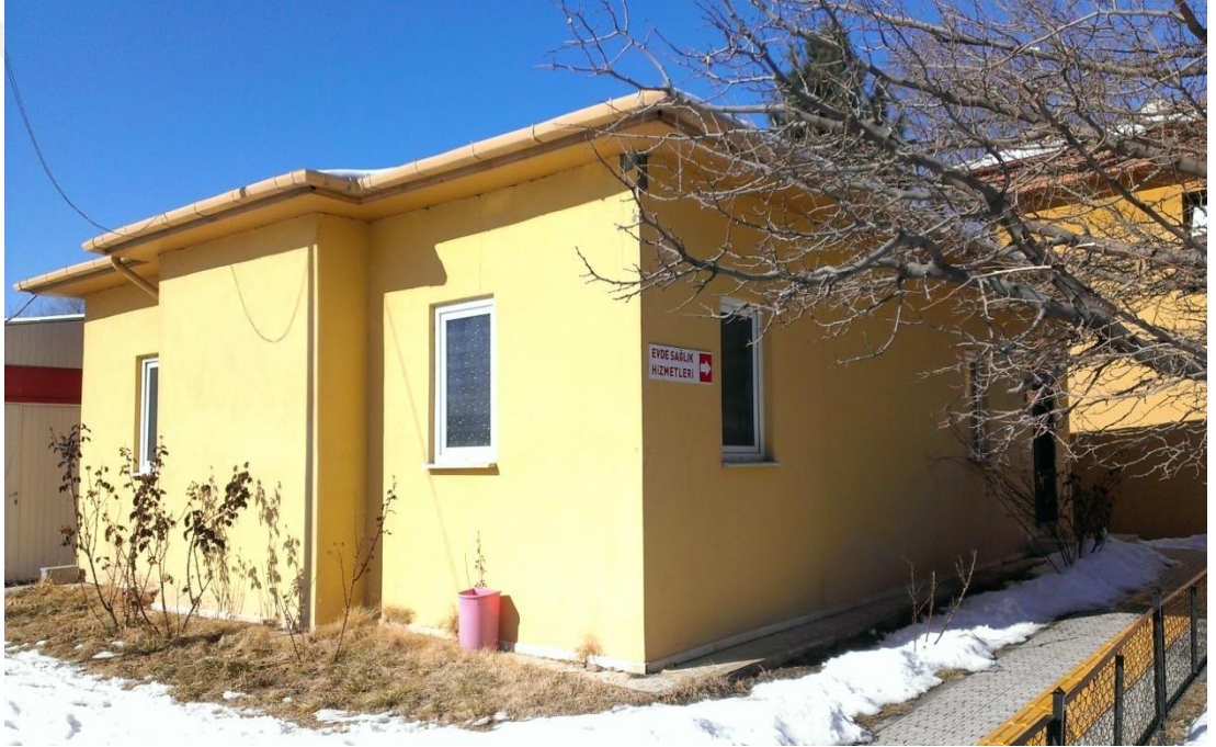
Őekil 3.1. Isıtma yapılan binanın gˆney-doęu cephesinin gˆrˆnˆmˆ
