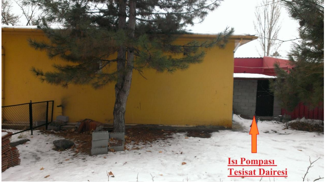
Şekil 3.2. Isıtma yapılan binanın kuzey cephesinin görünümü
