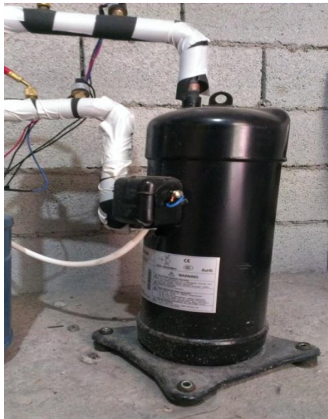
Şekil 3.5. 4 Hp gücünde scroll kompresör
