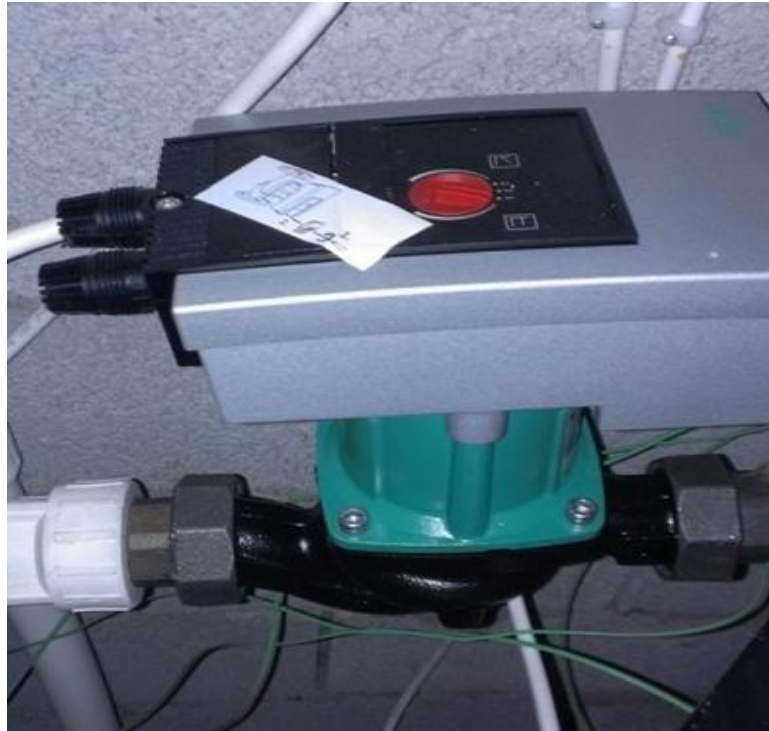
Şekil 3.11. Fan-coil hattında kullanılan sirkülasyon pompası
