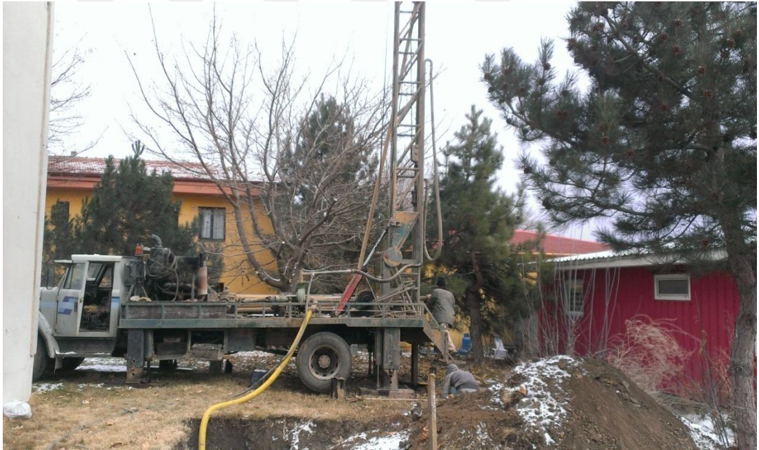
Şekil 3.8. Emiş ve enjeksiyon kuyularının sondaj işlemi
