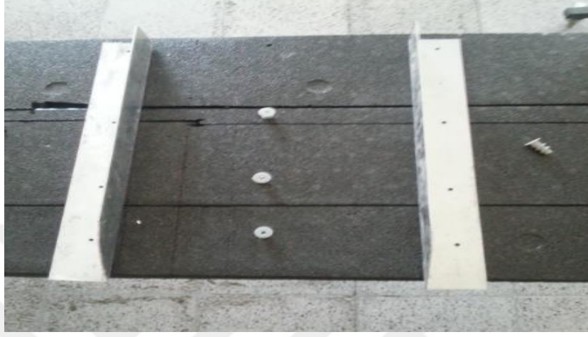
Şekil 3.36. Orta kanada dübel montesi
