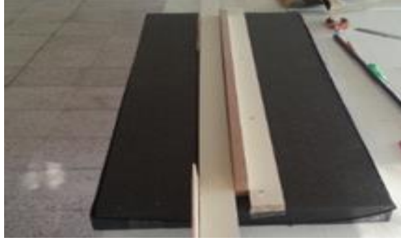
Şekil 3.22. Karbon çubuklar için kanal açımı
