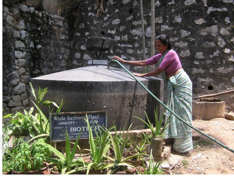
Şekil 2.1. Hindistan'da işletilen bir biyogaz sistemi (İnternet, 2016a)
