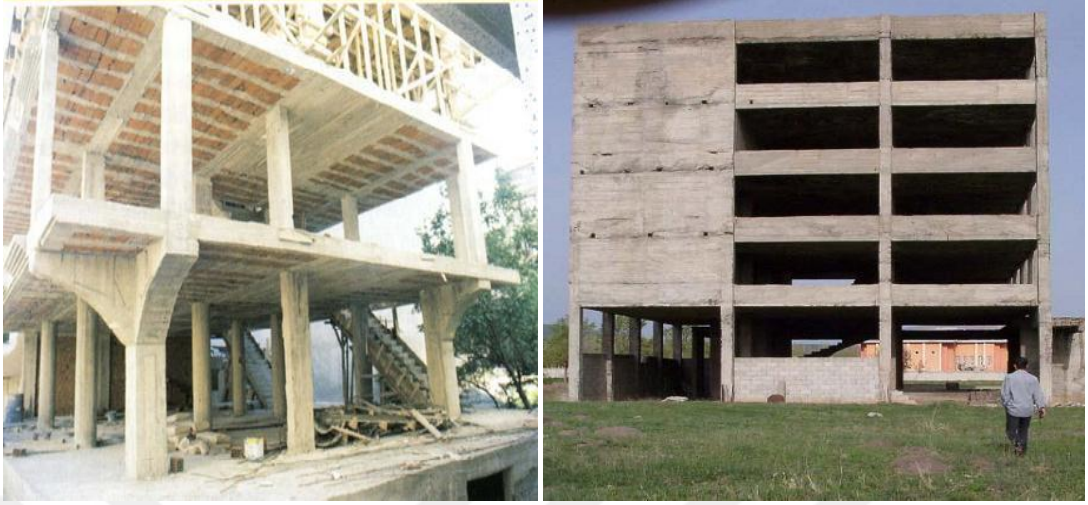
Şekil 2.11. Taşıyıcı sistem düşey elemanların süreksizliği durumu (Anonim, 2013)
