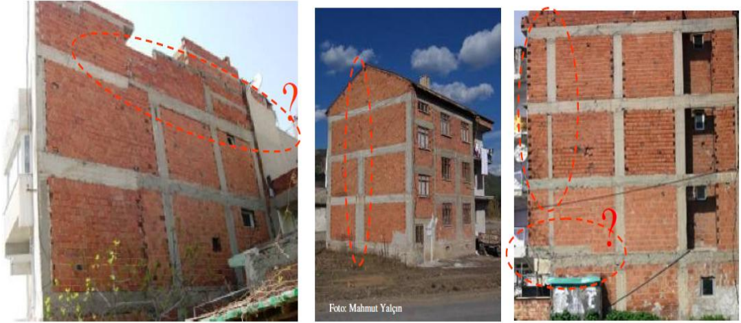
Şekil 2.12. Taşıyıcı sistem düşey elemanların süreksizliği durumu (Topçu, 2011)
