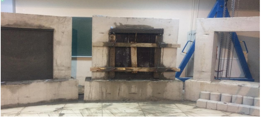
Şekil 4.18. Dolgu duvarların yerinde dökme zayıf betonlarının dökülmesi
