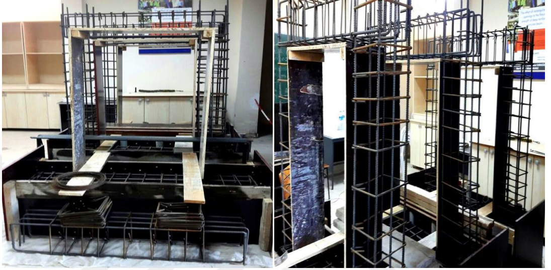
Şekil 4.9. Temel, kolon ve kiriş donatı işleri
