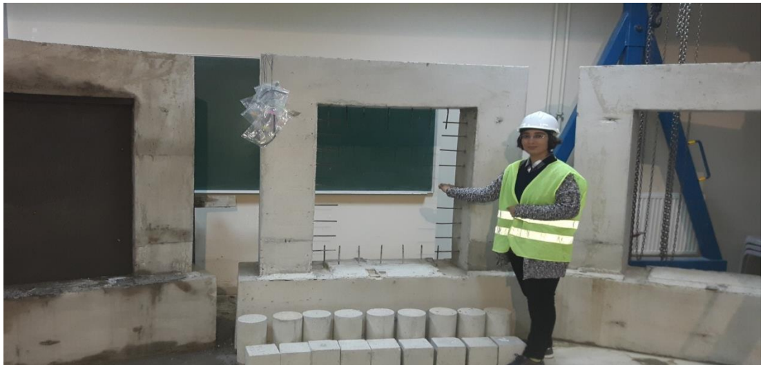
Şekil 4.17. Ankraj çubuklu çerçevenin dolgu duvar betonu dökülmeden öncesine ait resim
