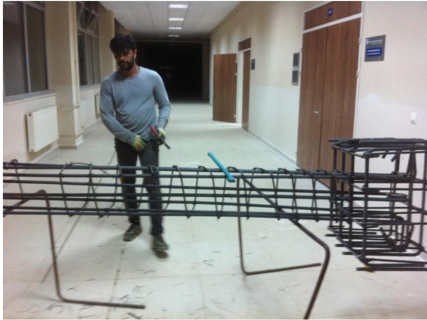
Şekil 3.19. Çelik donatının sarmal şekilde uygulanması
