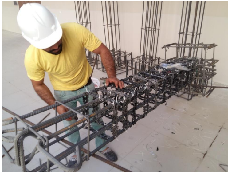
Şekil 3.23. Geogrid malzemenin kapalı etriye řeklinde sarım yapılması
