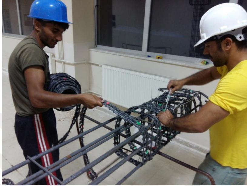
Şekil 3.24 Sarmal etriye uygulaması
