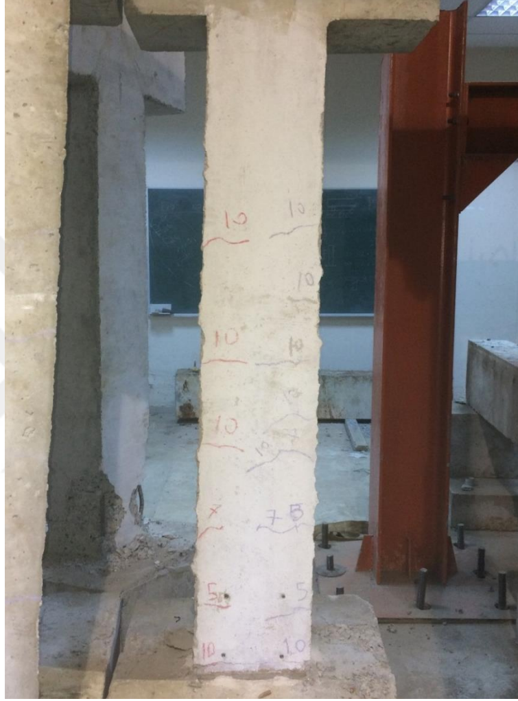
Şekil 4.15. F1 numunesi çatlak gelişimim
