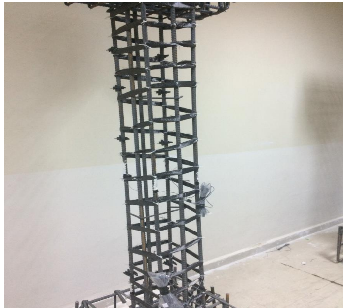
Şekil 3.21. CFRP'nin sarmal şekilde uygulanması
