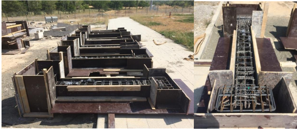
Şekil 3.1. Beton dökümü için hazırlanan kalıplar
