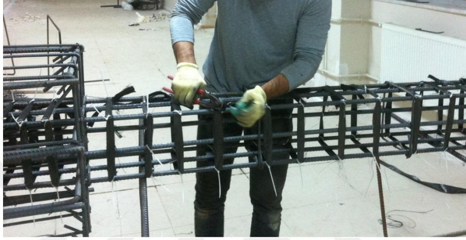
Şekil 3.20. CFRP'nin geleneksel kapalı etriye olarak kullanılması
