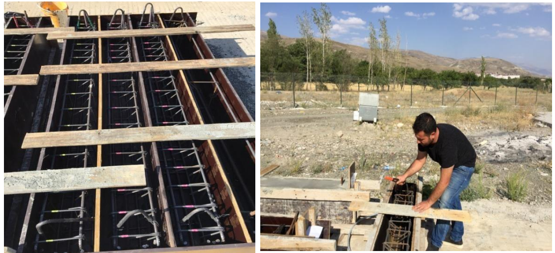
Şekil 3.8. Beton dökümünden önce kalıplara alınan betonarme kafesleri ve güçlendirme işlemleri.
