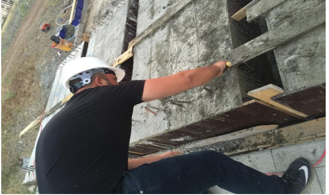
Şekil 3.12. Beton döküm işleminden sonra beton yüzeylerinin düzeltilmesi
