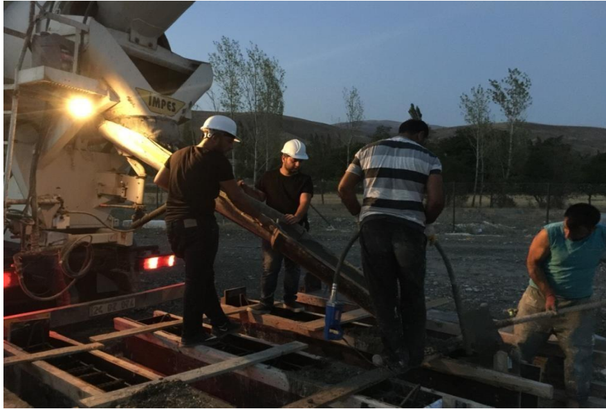
Şekil 3.11. Beton döküm işlemi sırasında vibratör işlemi
