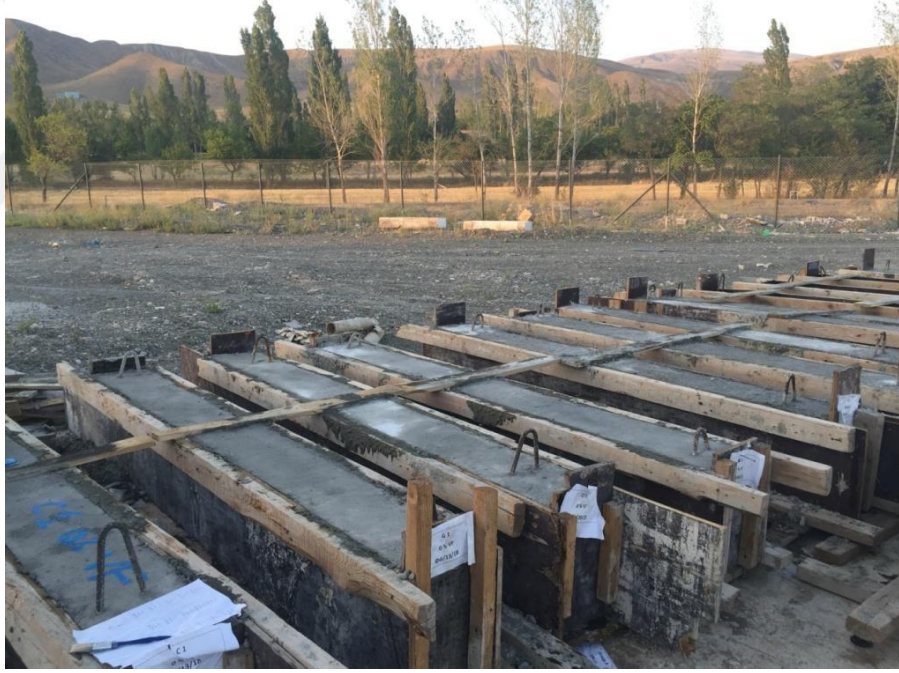
Şekil 3.14. Deneye tabi tutulacak betonarme kirişleri
