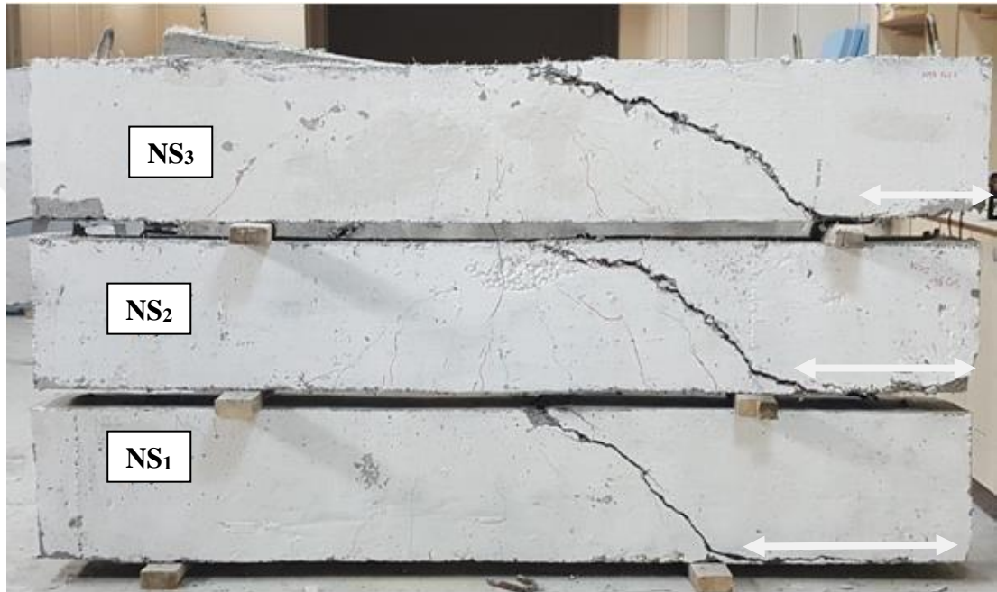
Şekil 4.2. NS grubu betonarme kirişleri için çatlak desenleri; (NS 1 ) = %0; (NS 2 ) = %0,5; (NS 3 ) = %1,5 plastik fiber katkıdır.
