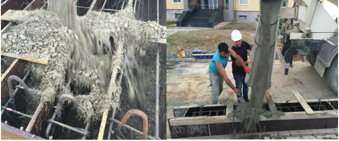
Şekil 3.10. Hazırlanan kirişlerin beton döküm işlemi
