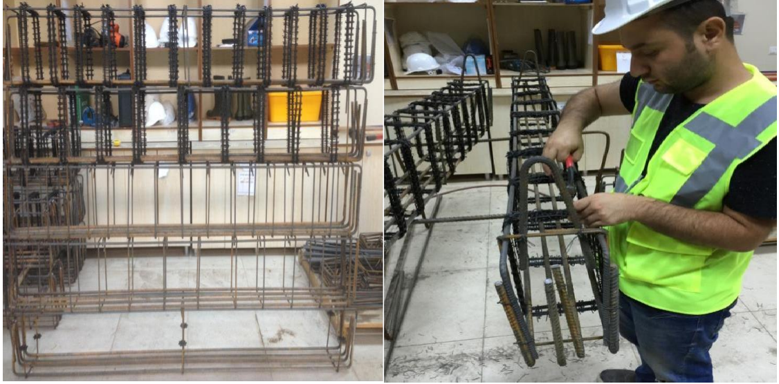
Şekil 3.7. Deneysel çalışmalar için hazırlanan betonarme kirişlerinin demir-donatı işlemlerinin yapım aşaması.
