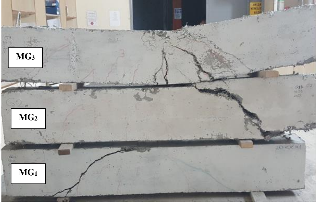
Şekil 4.10. MG betonarme kirişleri için çatlak desenleri; ( MG_1 ) = %0; ( MG_2 ) = %0,5; ( MG_3 ) = %1,5 plastik fiber katkıdır.
