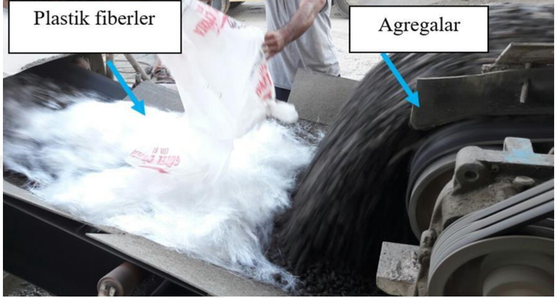
Őekil 3.9. Beton santraline gtrlen plastik fiberlerin belirlenen oranlarda betona katılma iřlemi.
