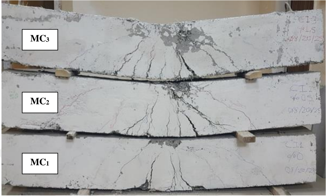
Şekil 4.8. MC betonarme kirişleri için çatlak desenleri; (MC 1 ) = %0; (MC 2 ) = %0,5; (MC 3 ) = %1,5 plastik fiber katkıdır.
