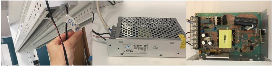
Şekil 4.4 Armatürlerin beslemesi ve güç kaynağı
