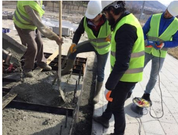
Şekil 4.12. Hazırlanan kalıp ve donatılara beton dökümü
