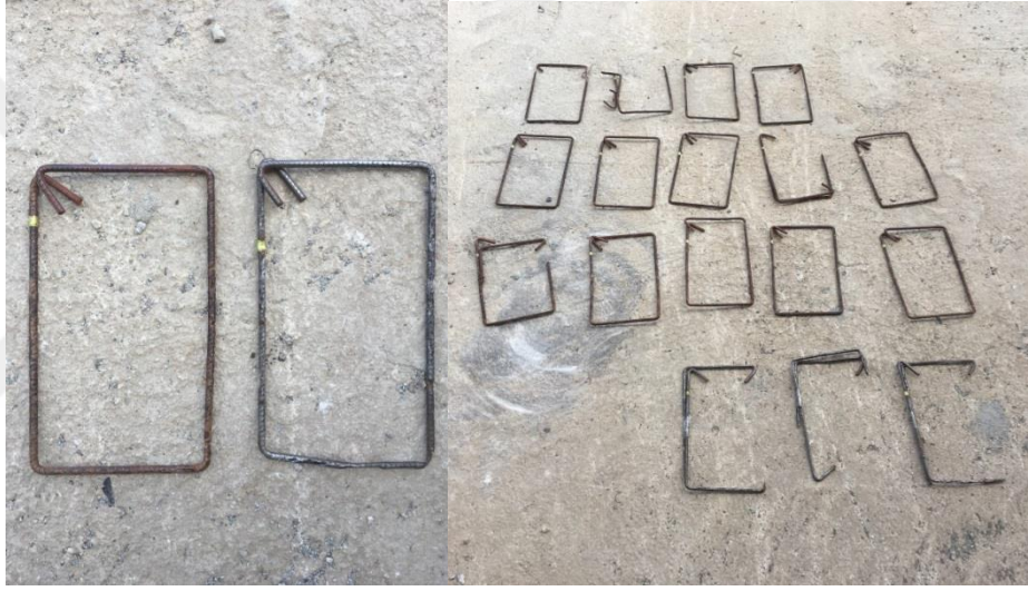
Şekil 4.26. Betonarme kiriş içerisinde çıkarılıp temizlenen çelik etriye donatıları
