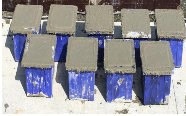
Şekil 4.13. Dökülen betondan numune alımı
