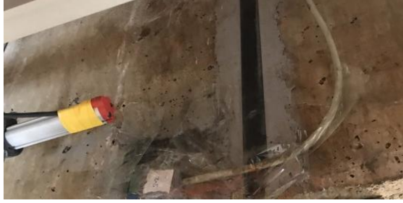
Şekil 4.37. Gerilim pulu betonarme kiriş üzerindeki görseli
