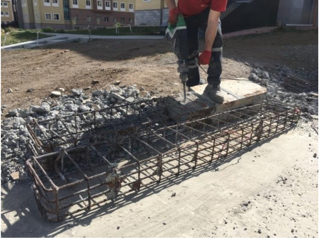
Şekil 4.24. Betonarme kirişlerin hilti ile kırılarak çelik kafes sisteminin çıkarılması
