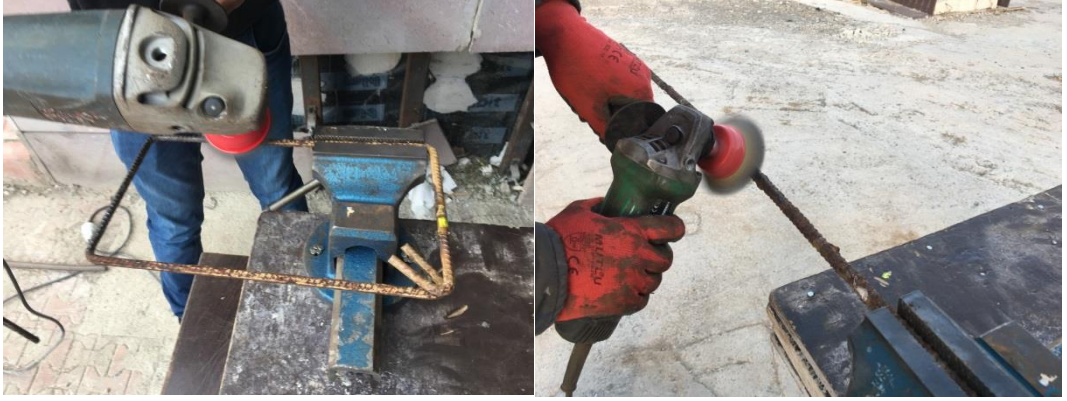
Şekil 4.25. Betonarme kiriş içerisinde çıkarılıp mekanik temizleme yapılan donatılar
