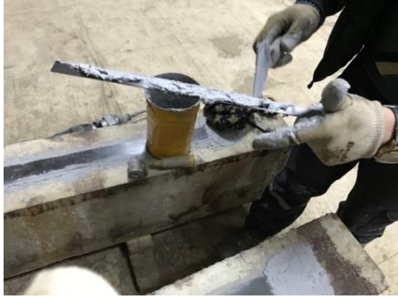
Şekil 4.22. FRP malzemesinin sikadur 30 ile kirişe yapıştırılması
