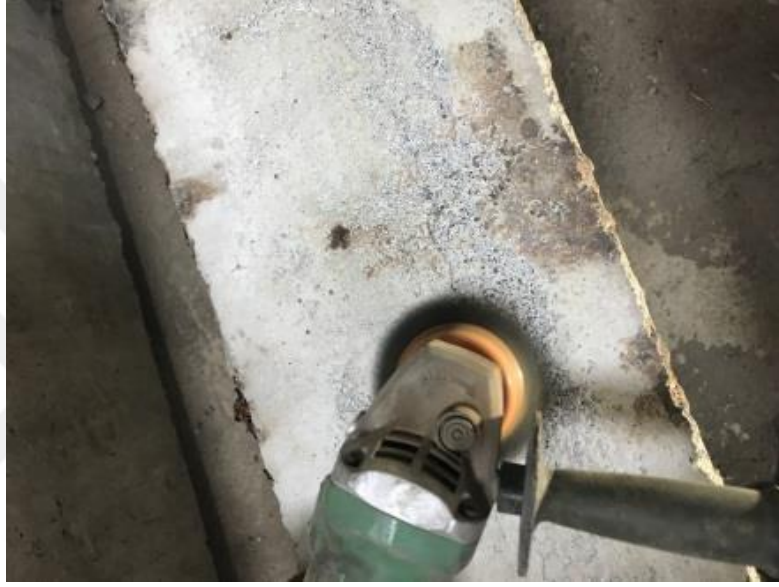
Şekil 4.21. FRP malzemesi yapılmadan betonarme kirişin yüzey temizliği
