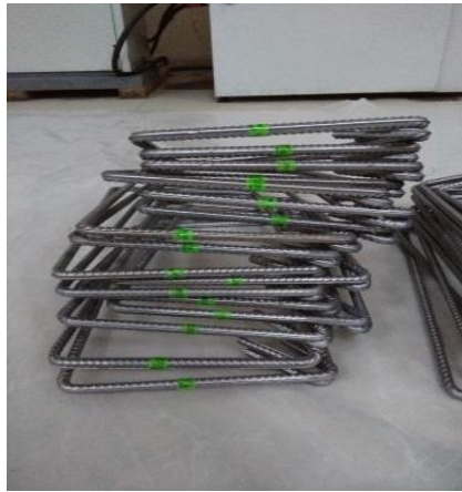
Şekil 4.7. Kirişler için tartılıp gruplandırılan ve etiketlenen etriyeler
