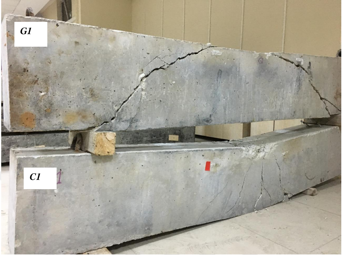
Şekil 5.15. G1 ve C1 Kırım Sonrası Çatlak Desenleri
