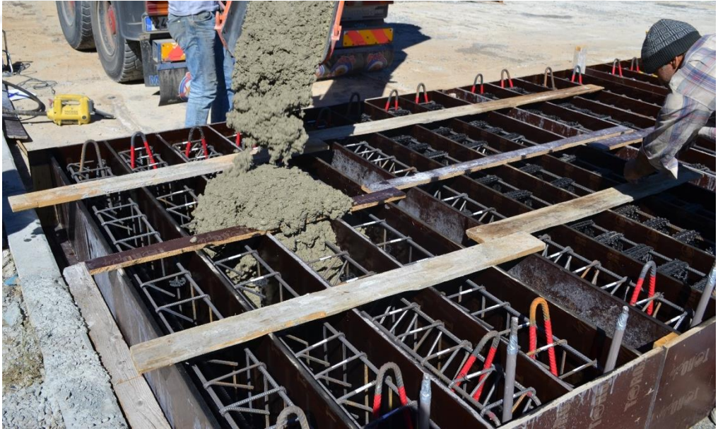
Şekil 4.9. Betonarme Kirişlerin Beton Dökümü
