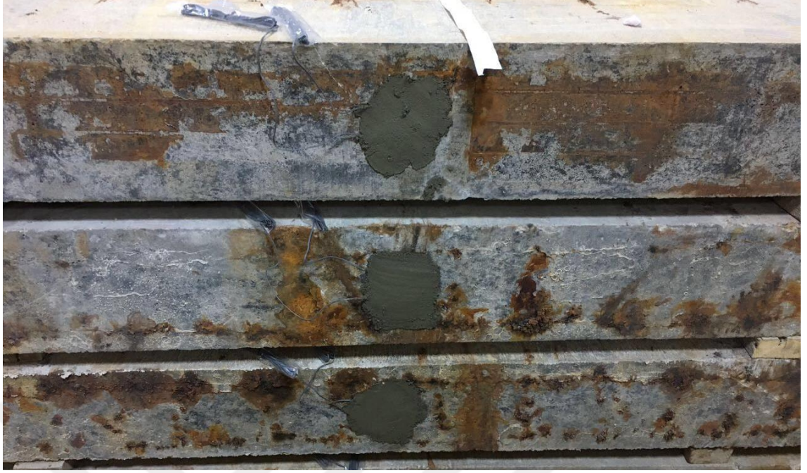
Şekil 4.15. Yerleştirilen Gerinim Ölçerlerin Tamir Harcı İle Kapatılması
