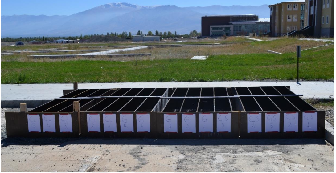
Şekil 4.8. Betonarme Kirişler İçin Hazırlanan Kalıplar
