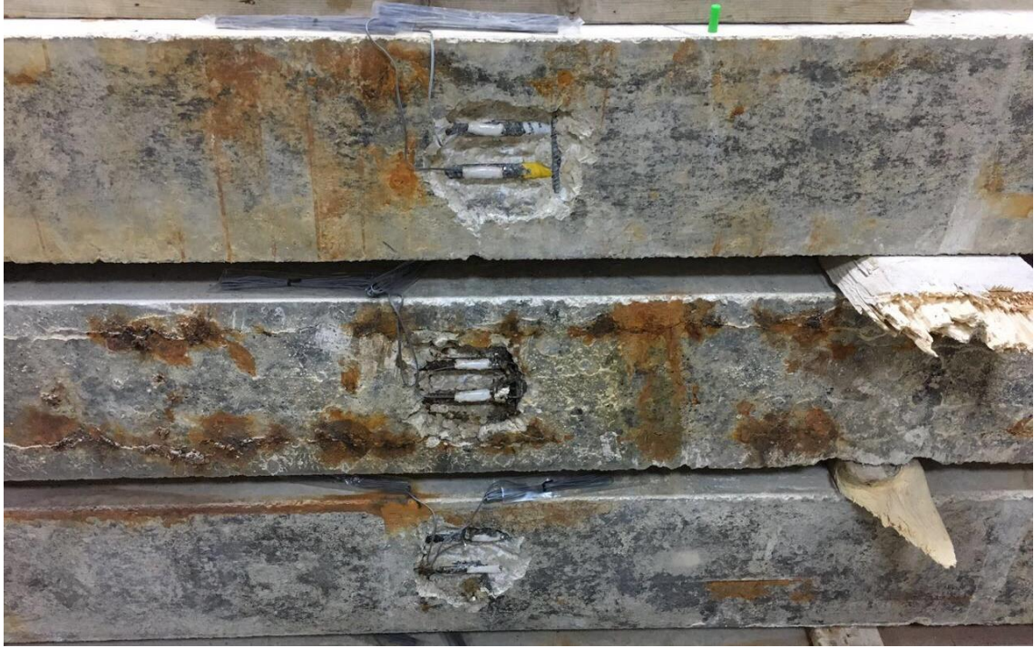
Şekil 4.14. Gerinim Ölçerlerin Yerleştirilmesi
