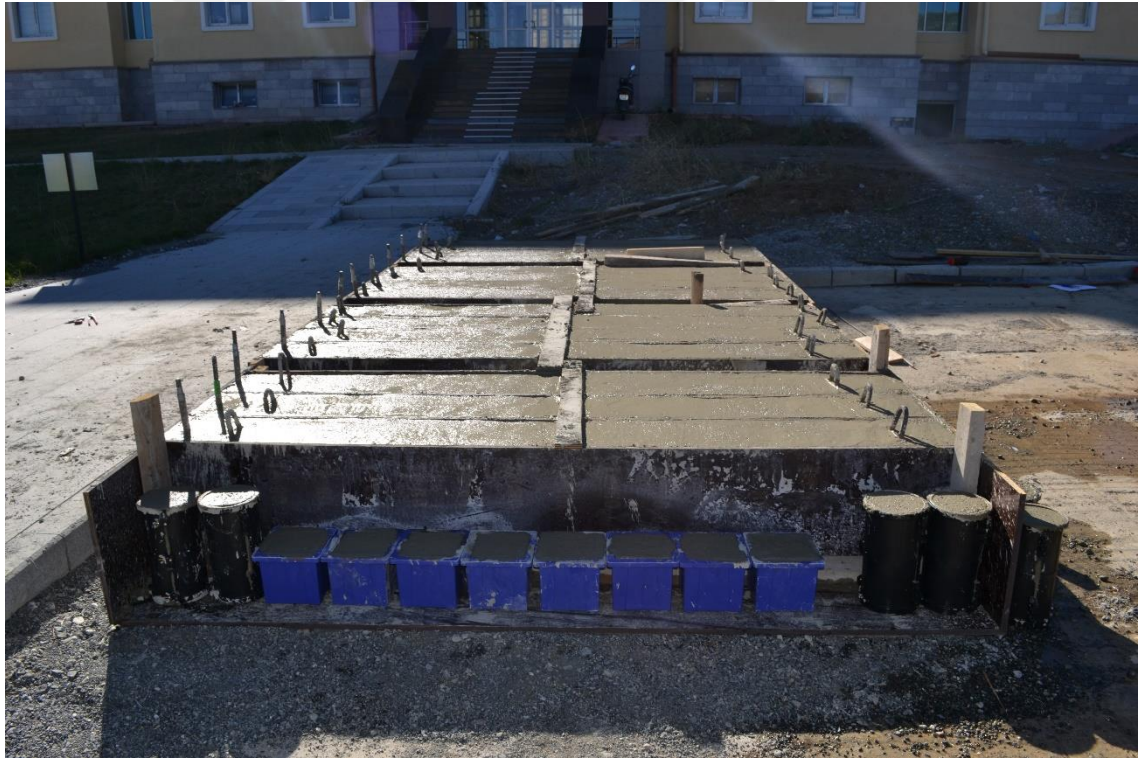
Şekil 4.11. Beton Prizi Ve Numunelerin Alımı
