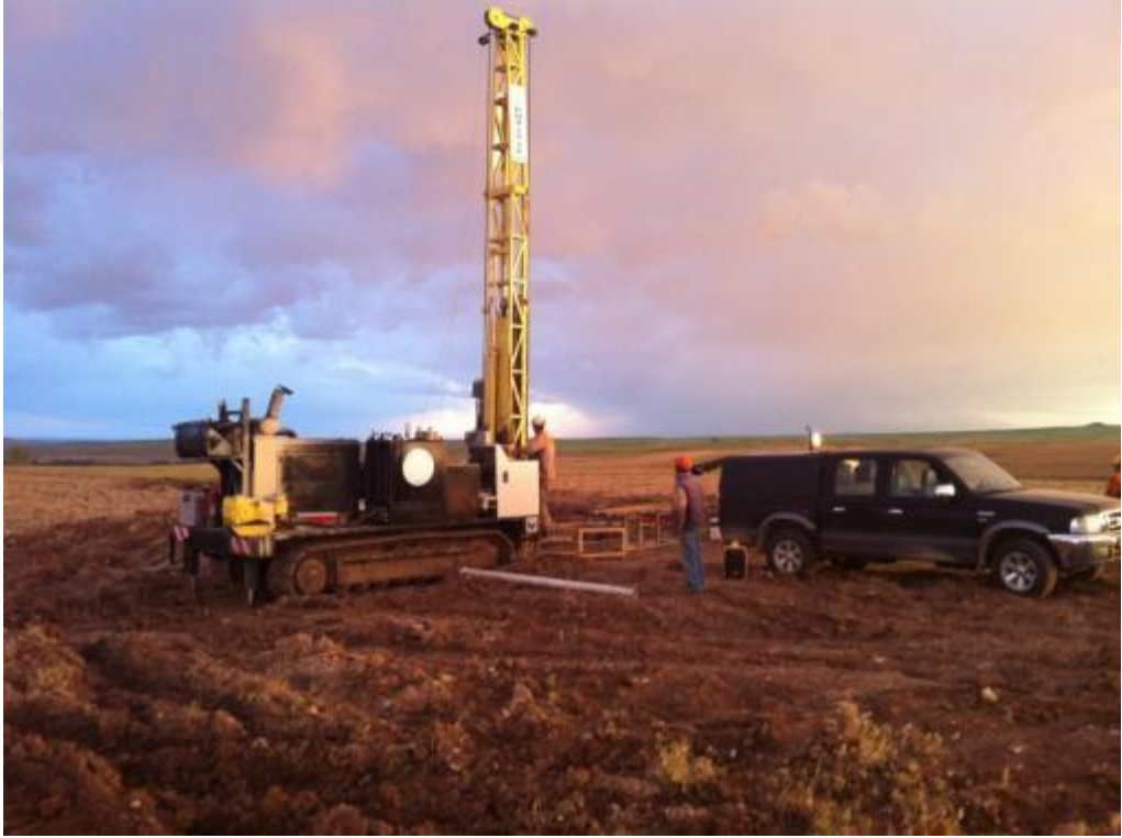
Şekil 1.3: Sondaj çalışması ile karot alımından bir görünüm.
