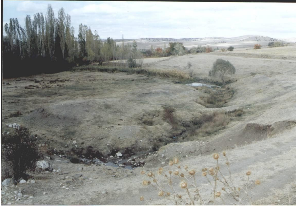
Resim 64: Gölpınar Hitit Barajı'nın Sediman Malzeme İle Dolmuş Görünümü
