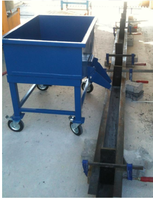
řekil 2.7: UYPLB'un hazırlanması ve kiriř kalıplarına yerleřtirilmesi
