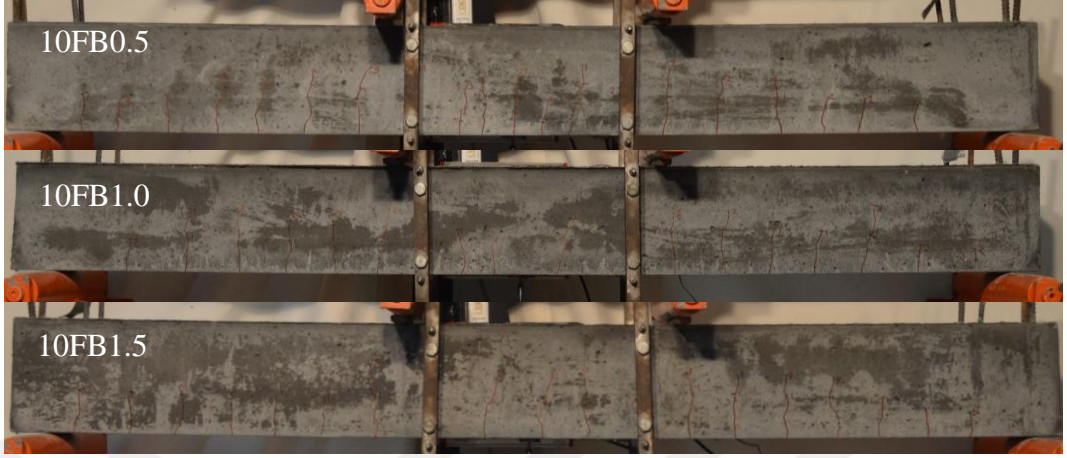
Şekil 3.19: 2 \phi 10 donatılı bazalt lifli kirişlerin L/250 yerdeğiřtirmesi için çatlak dağılımları
