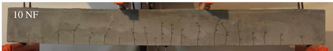
Şekil 3.6: 2 \phi 10 donatılı lifsiz kirişlerin L/250 yerdeğiştirmesi için çatlak dağılımları
