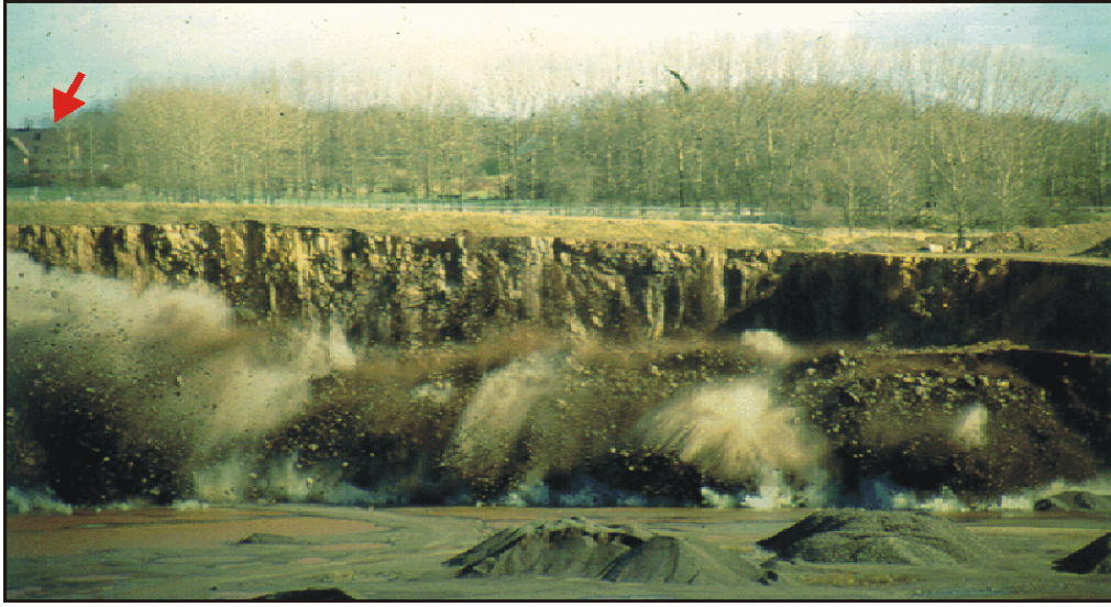
Şekil 2.6 Patlatma sonrası kaya fırlaması
