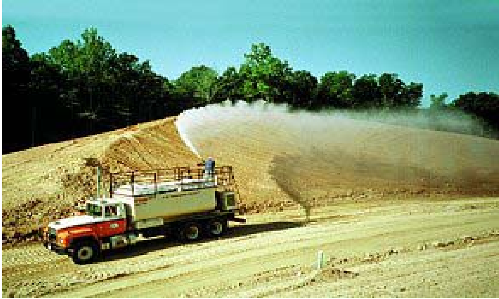
Şekil 2.8 Toz oluşumunun azaltılması için patlatma öncesi sulama işlemi
