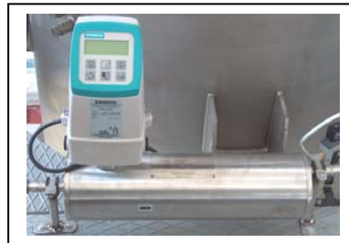
Şekil 4.9. SIEMENS SITRANS F C MASSFLO MASS 2100 kütleli debi ölçer.
