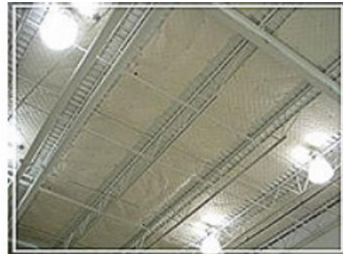
Şekil 6.1 Hacimlerin tavanlarına asılan dikey ve yatay sönümleyiciler
