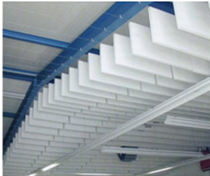
Şekil 6.1 Hacimlerin tavanlarına asılan dikey ve yatay sönümleyiciler
