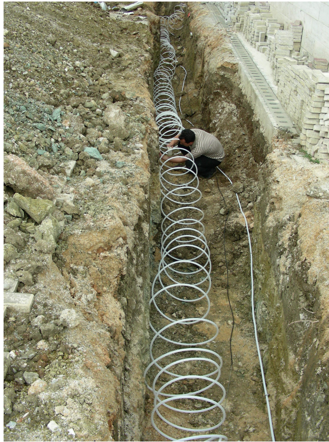
Őekil 5.1. 1 m Derinliđinde Toprađa Serilen Boruların Üstten Çekilmiş Fotođrafı.
