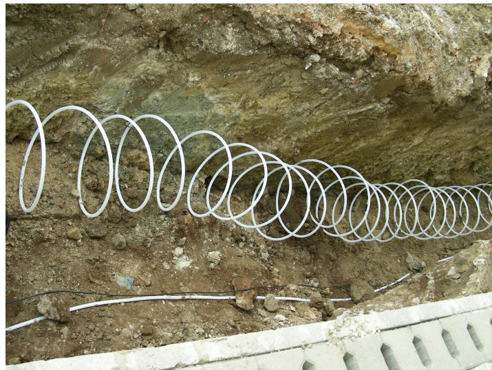
Şekil 5.3. Topraęa Gömülen Pt-100 Isıl Çift Probenun Görünümü
