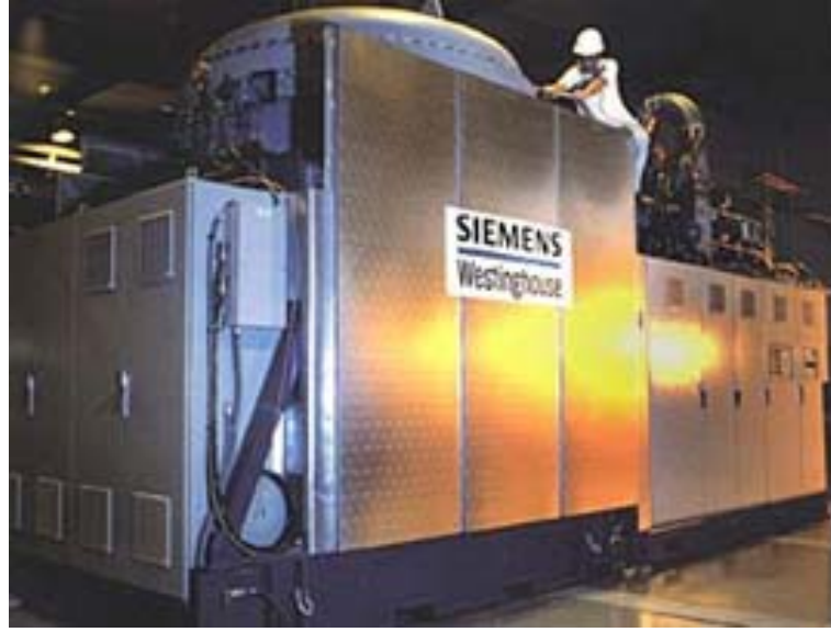
Şekil 2.6 Gaz Türbinli, Yakıt Hücreli Kojenerasyon Sistemi (250 kW) [16].
