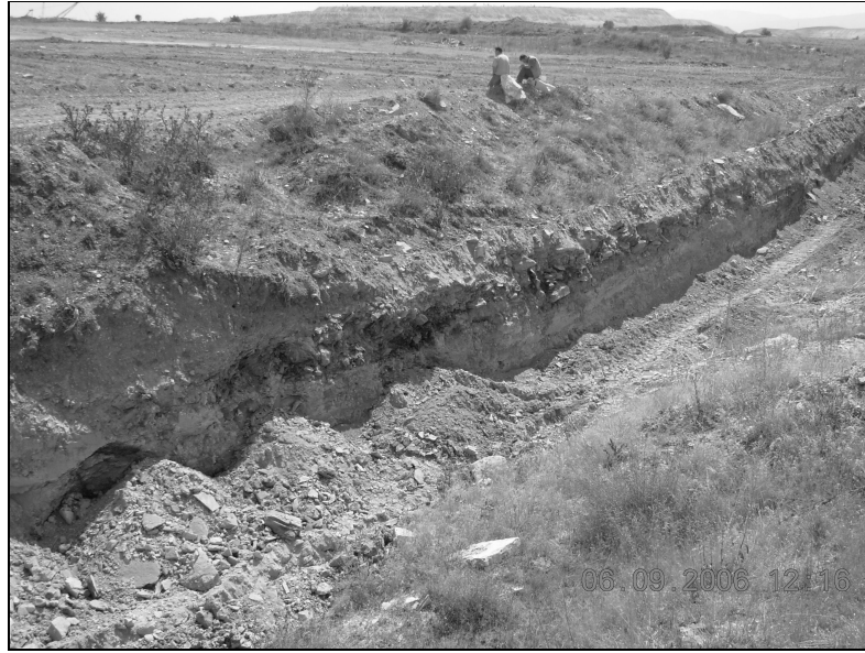
Şekil 4.8 Patlatma bölgesi ile ölçüm noktası arasına açılan hendek
