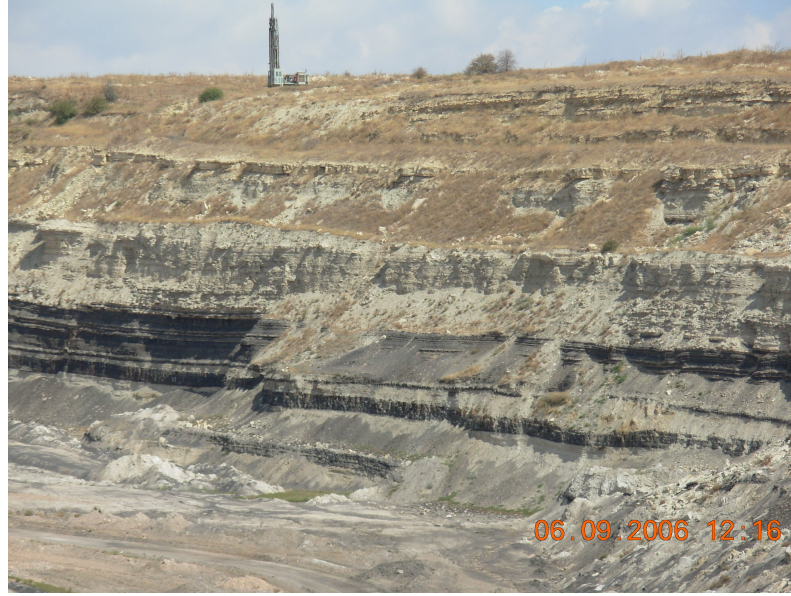
Şekil 4.2 Çalışmanın yapıldığı dragline panosu
