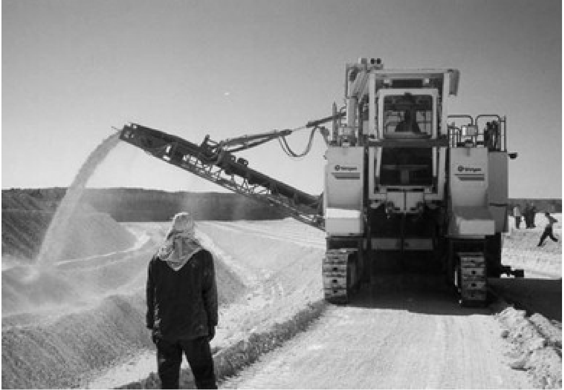
Şekil 3.4. Alttan Tamburlu Sürekli Yüzey Kazıcı Uygulaması [25]
