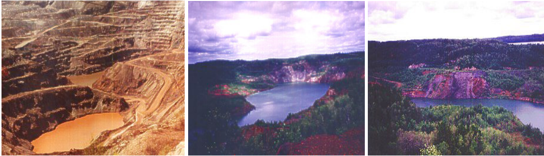
Şekil 4.14. Step Rock Demir Madeni – Ontario Canada, Açık ocağı madencilik çalışmaları ve ıslah sonrası hali. Nihai ocak çukurunun göl olarak dizayını.
