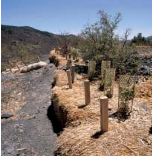
Şekil 4.12. Önceden kömür madeni alanı ile kaplanmış olan bu dik duvarlı arazinin yanları başarılı bir şekilde reklame edilmiş ve stabil hale getirilmiştir. Kazıkların dikilmesi (çelik) su akışını azaltmakta ve tepe etrafında büyüyen bitkiler için uzun süreli bir çevre yaratmaktadır. (Sugarite Kanyonu Kömür Madeni Yeniden Kazanım Projesi-New Mexico)
