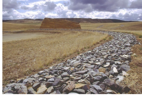
Şekil 4. 10. Drenaj kanalında bir riprap uygulaması (Boyer Madeni, ABD)
