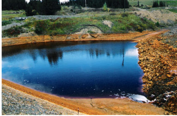
Şekil 5.20. AMD toplama gölü-Equity Silver'a ait Red Chris Madeni (pH=2) Gölün suyu Todayin koluna akabilirdi ama göl, bir adet set ile ayrıldı ve Stikine nehrinin Klappon koluna dökülmeye başladı.
