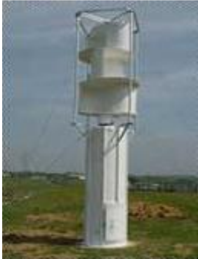
Şekil 3.3 Savonius tipi rüzgâr türbini [37]
