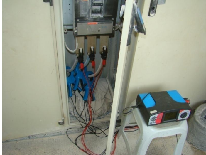
Şekil 3.22. Enerji tüketimini ölçen güç analizatörü
