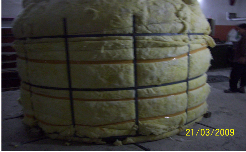
Şekil 9.12 Biyogaz reaktörü izolasyon çalışması ve kafes sistemi.
