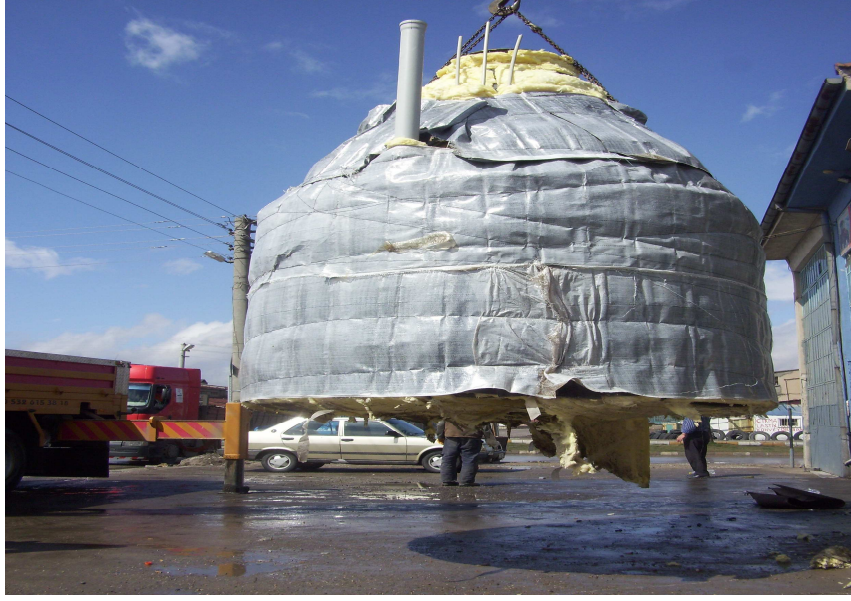
Şekil 9.11 Biyogaz reaktörü izolasyon çalışması.
