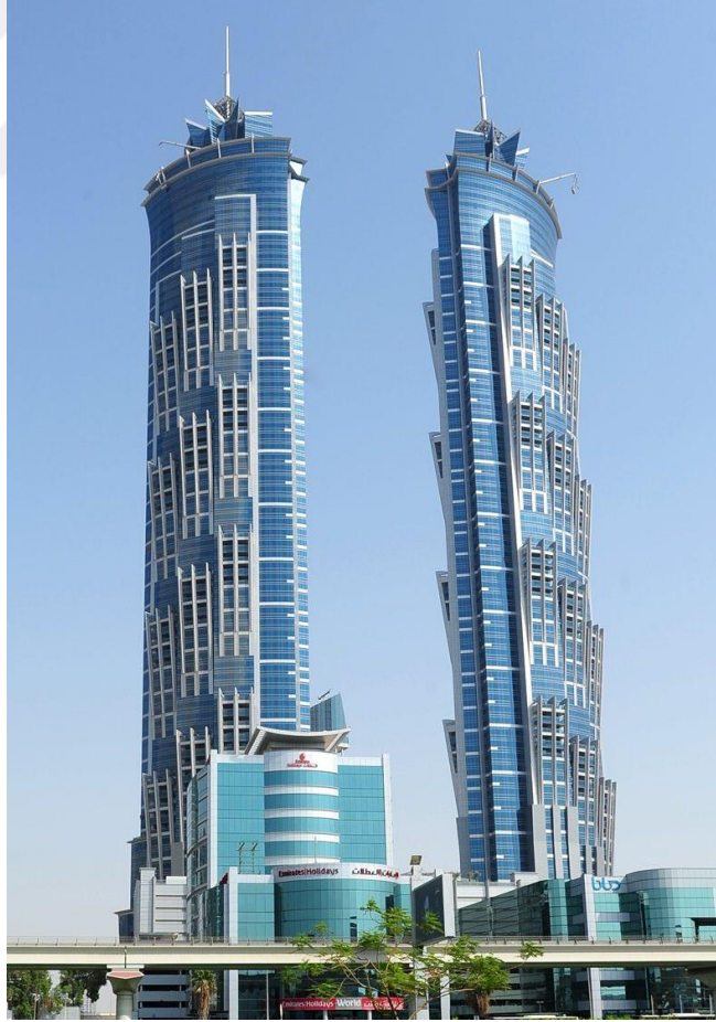
Şekil 4.7. JW Marriott Otel (BAE) Termal Yalıtım Kaplaması (URL-16).
