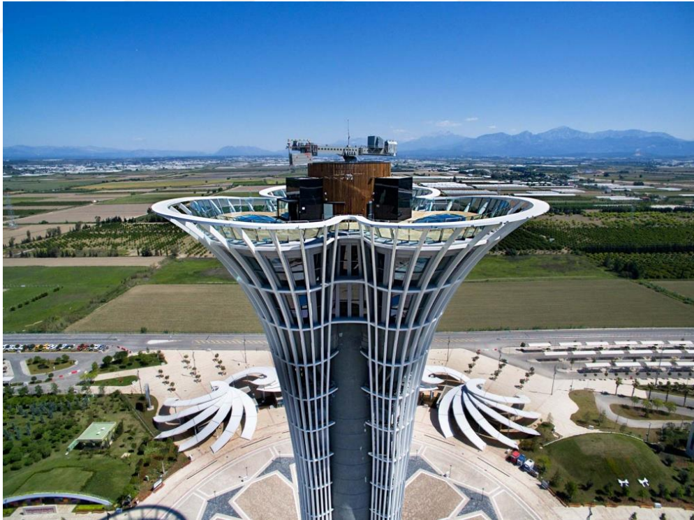
Şekil 4.19. Expo 2016 Antalya Kulesi Alüminyum Kompozit Panel Kaplaması (URL-26).
