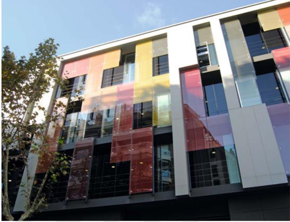
Şekil 4.18. İspanyol Enerji Şirketi Binası Alüminyum Kompozit Panel Kaplaması (URL-25).
