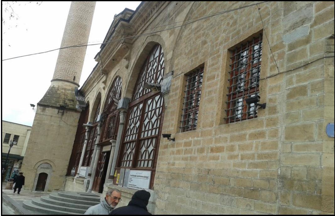
Şekil 2.4. Kütahya ulu cami dış görünüşü.
