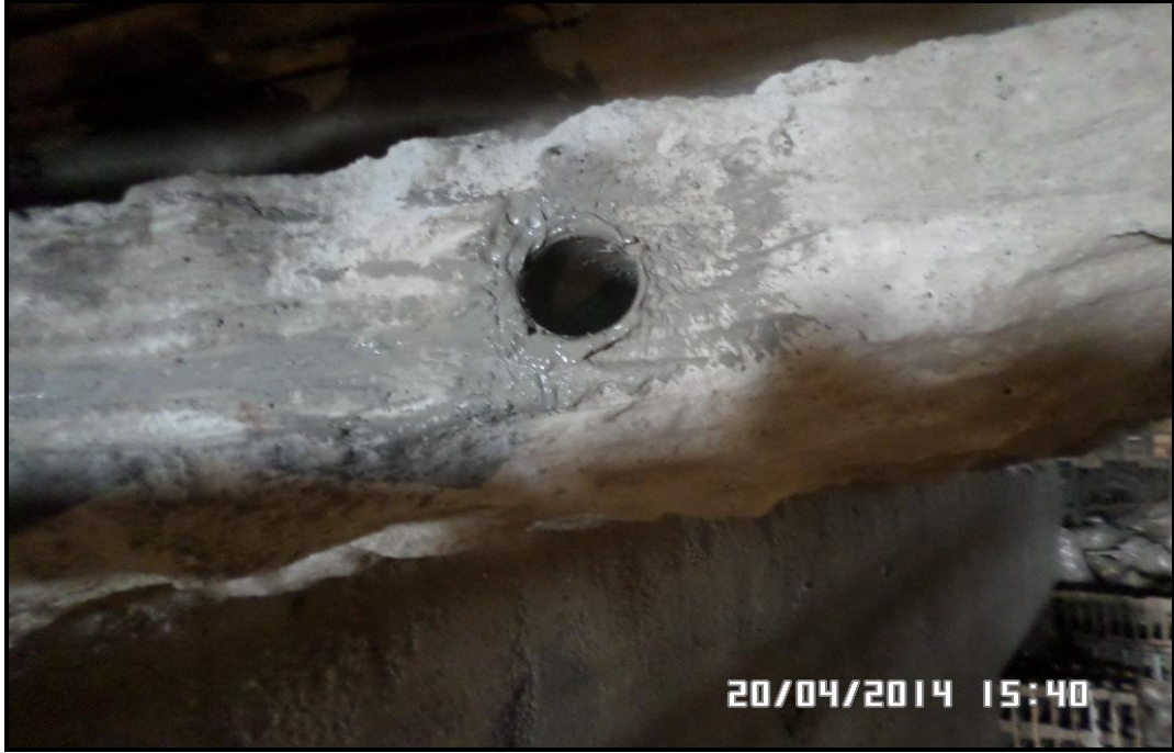
Şekil 4.2. Karot alındıktan sonra karot yeri görünümü.
