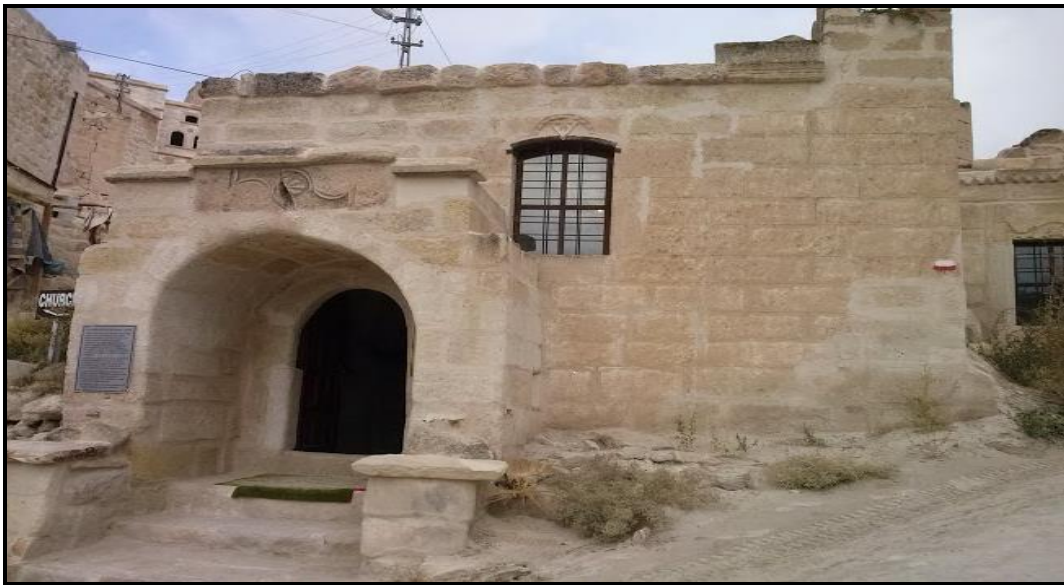
Şekil 2.3. Göreme’de tüfün yapı taşı olarak kullanılması ile yapı örneği.
