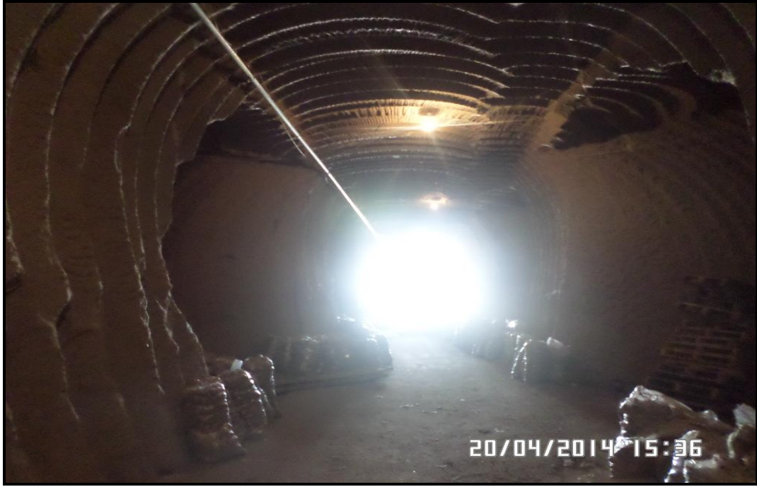
Şekil 2.10. Kütahya soğuk hava depoları iç görünümü.
