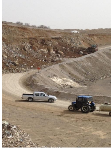
Şekil 5.30. Patlatma sonrası yığın temizlenme işlemi.
