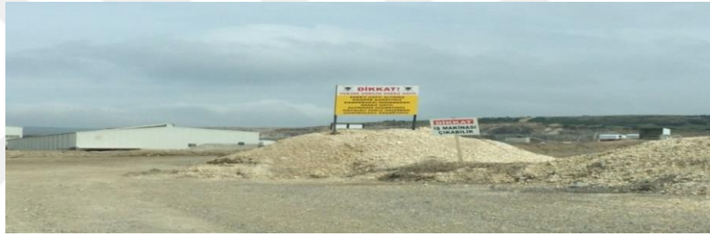
Şekil 5.13. Elektrik ikaz tabelası.
