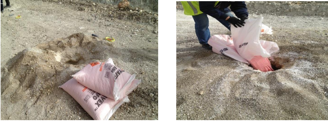
Şekil 5.24. Deliklerde patlatma operasyonunda kullanılacak patlayıcı malzemeler.
