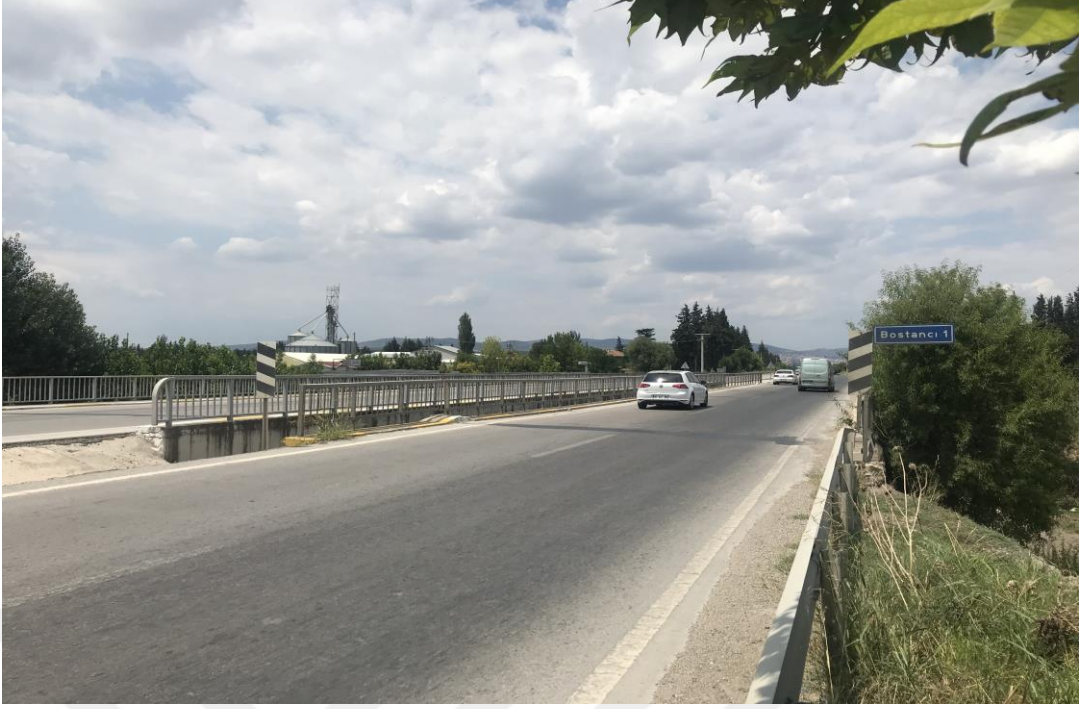
Şekil 4.3: Güzergâh üzerinde bulunan köprülerden Bostancı 1 köprüsü
