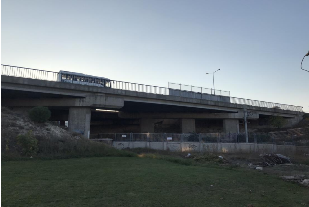
Şekil 5.1: Mevcut demiryolu hattının güzergâhtan ayrıldığı sigorta köprüsü
