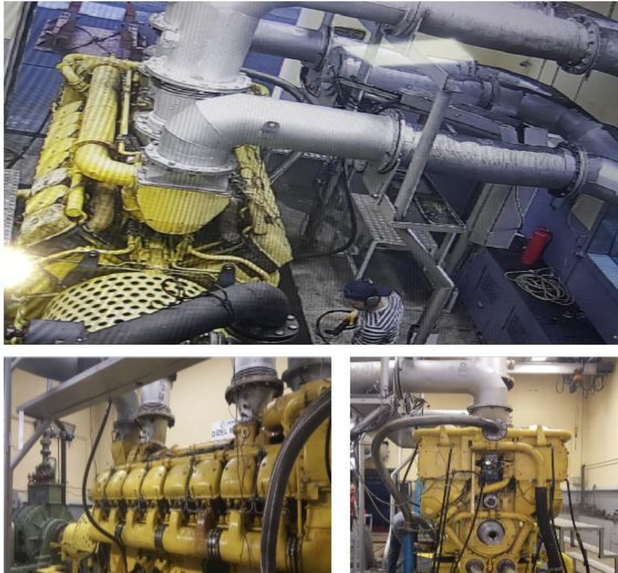
Şekil 7.16 Test motorunun test ünitesinde bağlantı yapılmış hali
