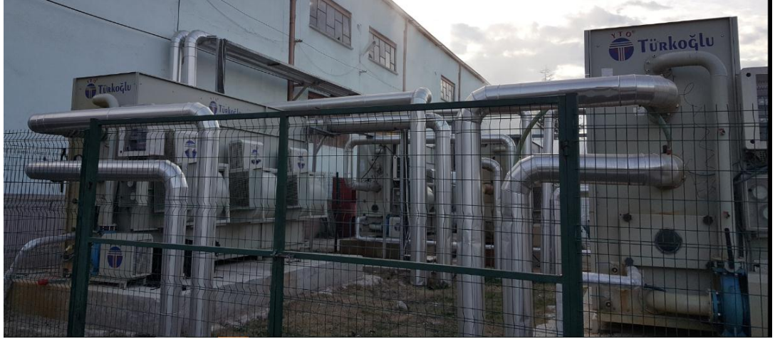
Şekil 7.13. Motor test ünitesi soğutma sistemi.
