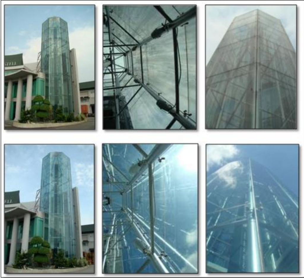
Şekil 2.21: Fotokatalik TiO 2 cam kaplama uygulaması öncesi ve sonrasında cephe görünümü (url-9).
