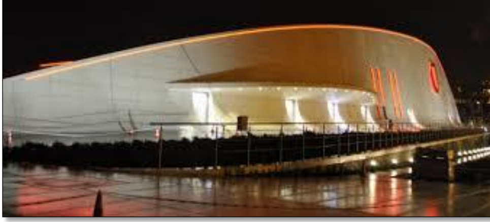
Şekil 2.16: Cam elyaf tavkviyeli fibro T beton (kendi kendini temizleyen beton) ile üretilmiş yapı
