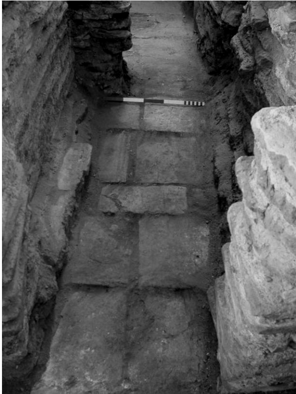
58b: Hypocaust içerisindeki ısı dolaşımını sağlayan kanal.
