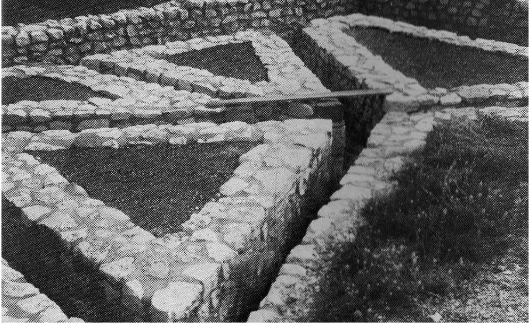
Res. 4. 18. Hypocaust sisteminde paye dikmelere alternatif olarak kullanılmış değişik bir hypocaust ısıtma sistemi. Aquincum (Brödner1983)
