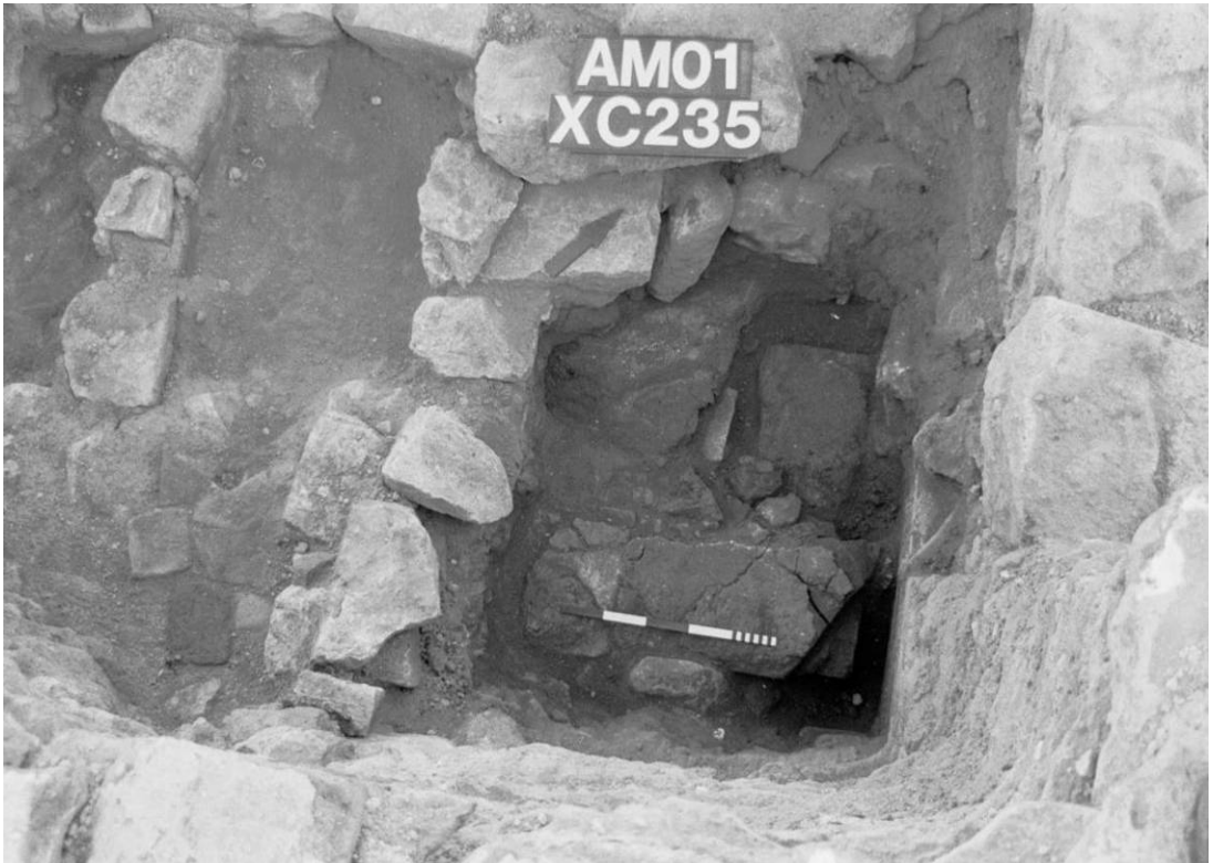
50b: Tepidarium kısmının tahrip edilmiş zeminini
