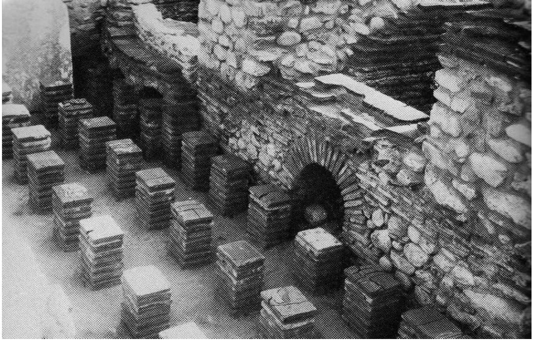
Res. 4. 16. Hamamların ısıtılmalarını sağlayan hypocaust sistemi. Heraclea.(Brödner, 1983)
