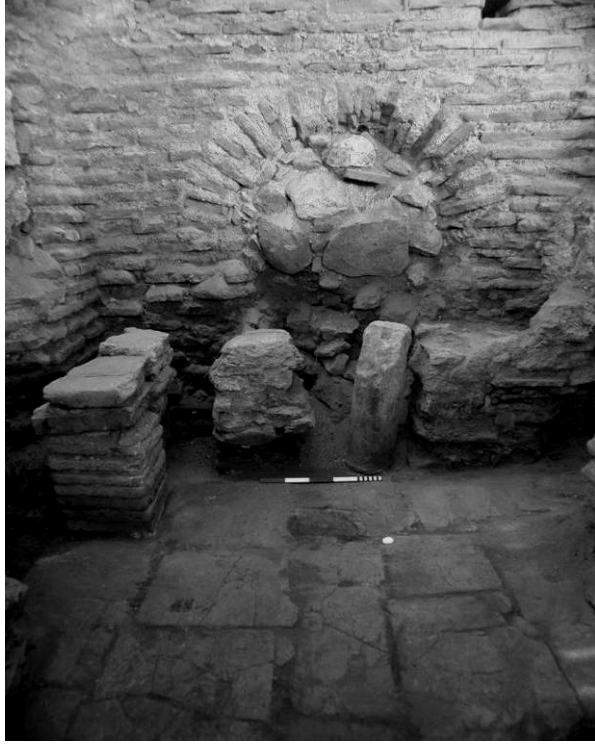
58a: Hypocaust'un ısı kontrolünün sağlandığı furnace kısmı.
