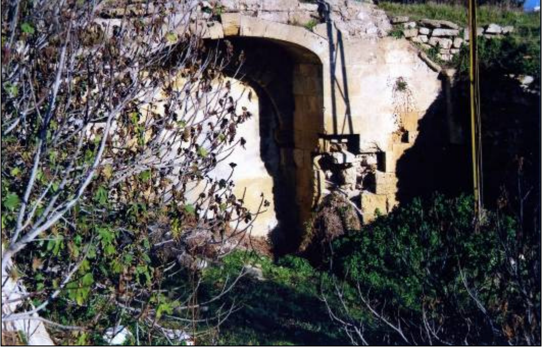
Resim 208 : 19.yy.'da Onarımlar Sırasında Eklenen Kapının İç Tarafı
