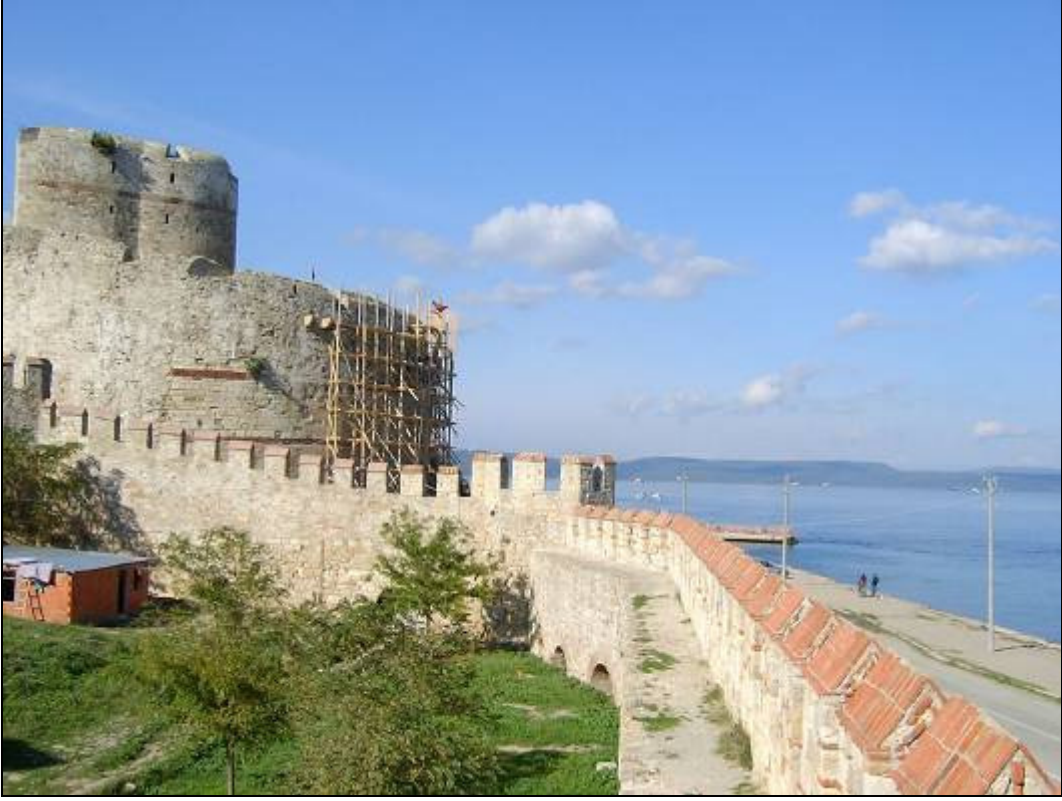
Resim 62 : Kilitbahir Kalesinde Yapılan Restorasyon alıřmaları
