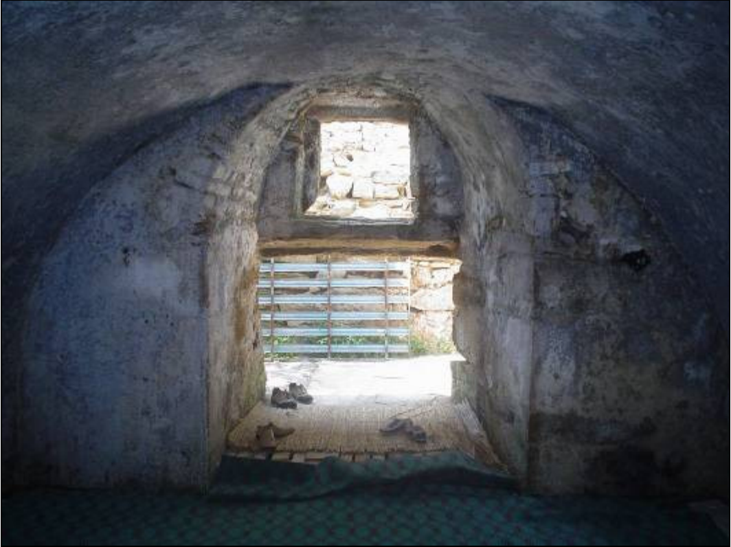
Resim 251 : Kışla Binası Giriş
