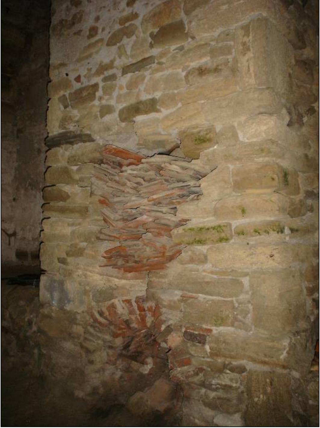
Resim 166 : Kışla Binası İçindeki Şömine
