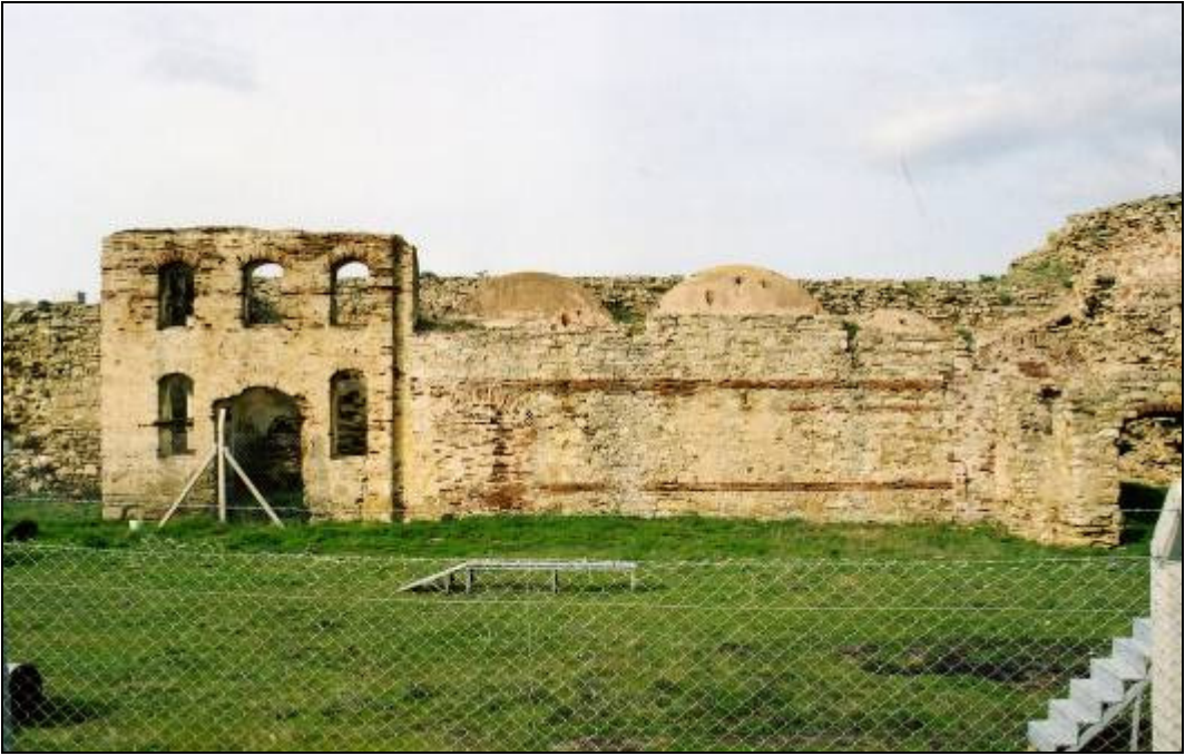
Resim 145 : 19.yy.'da Yapıldığı Düşünülen Küçük Hamam
