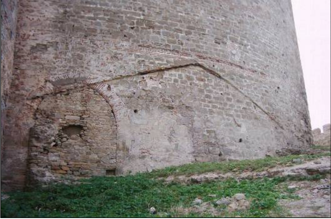
Resim 74 : İç Kale İle Dış Sur Arasına Yapılmış Olan Binanın İzlerinin Görüldüğü İç Kale Suru ve Sonradan Kapatıldığı Anlaşılan Kapı
