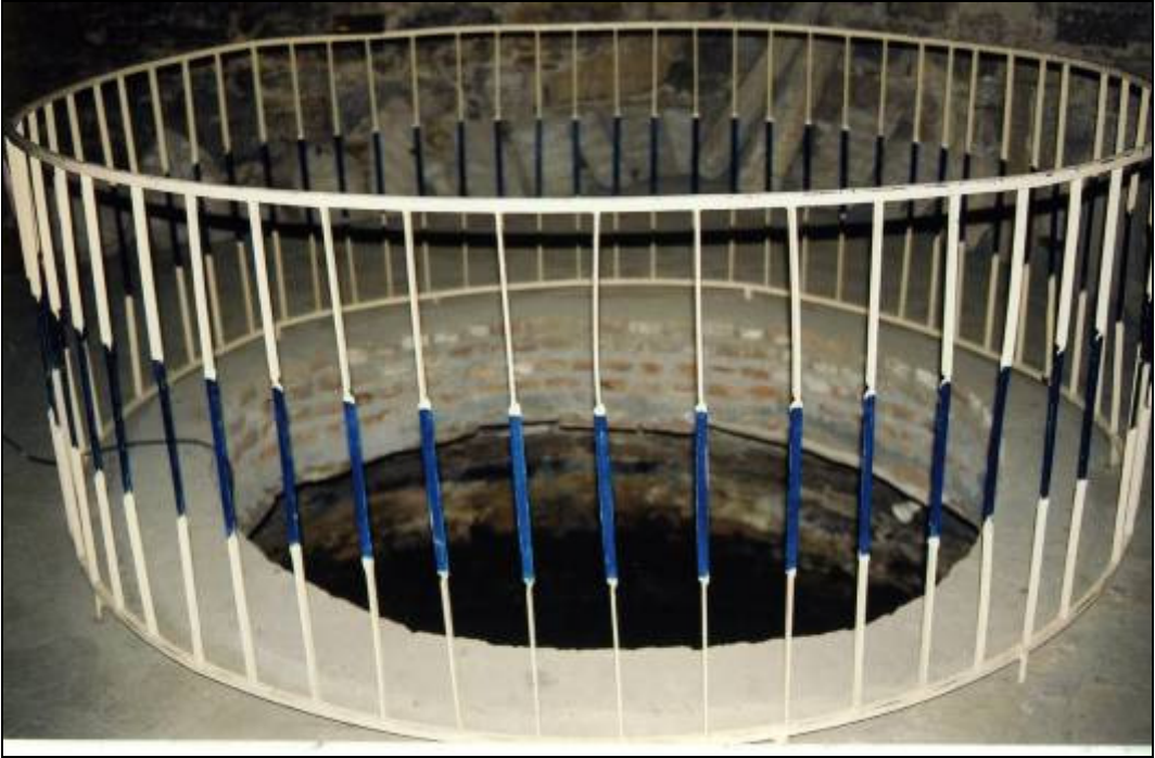
Resim 18 : Kulenin Zemin Katında Yer Alan Sarnıç yada Kuyu
