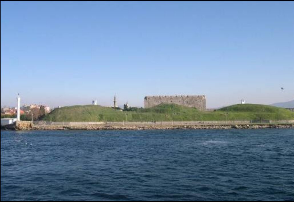
Resim 105 : Kale-i Sultaniyenin 19.yy.'da Yıkılarak Tabyaya Çevrilmiş Olan Dış Sur Duvarları
