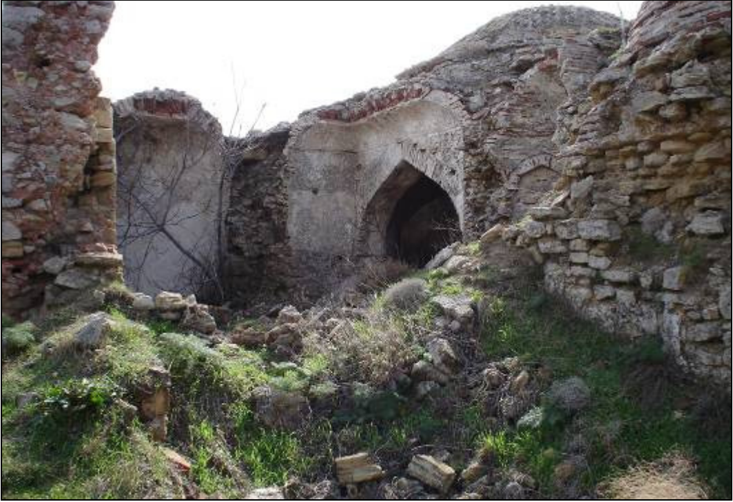
Resim 163 : Sultan Hamamı (Çifte Hamam) Giriş Bölümü
