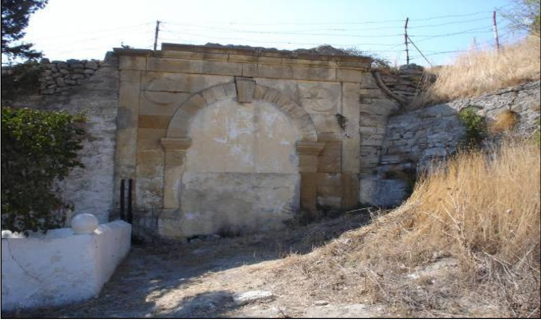
Resim 206 : 19.yy.'da Onarımlar Sırasında Eklenen Kapı
