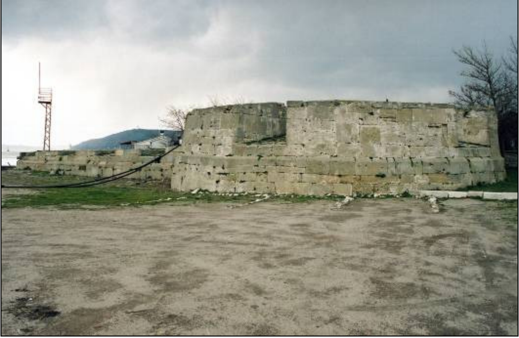
Resim 220 : Dış Surun Dairesel Burcu
