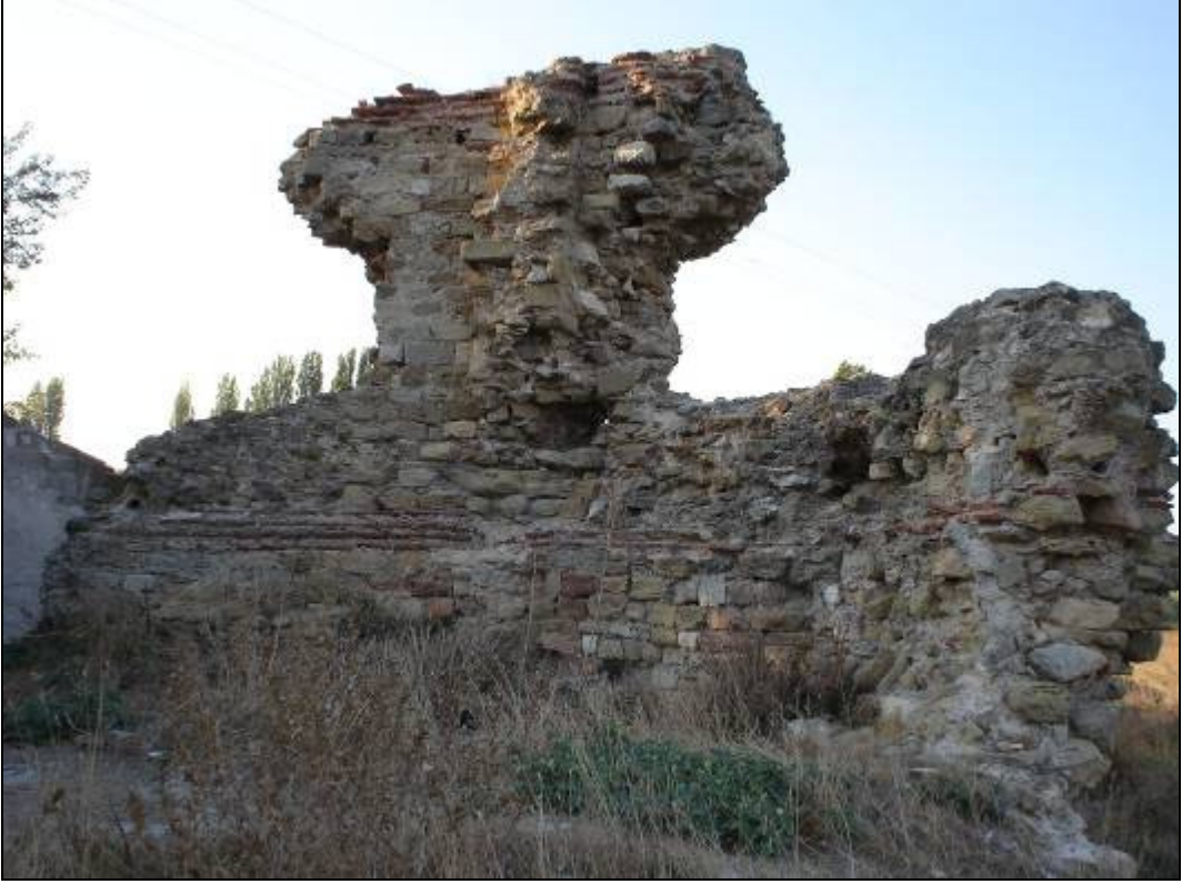
Resim 34 : Kule'nin İinden Almaşık Duvar Tekniđini Gsteren Detay
