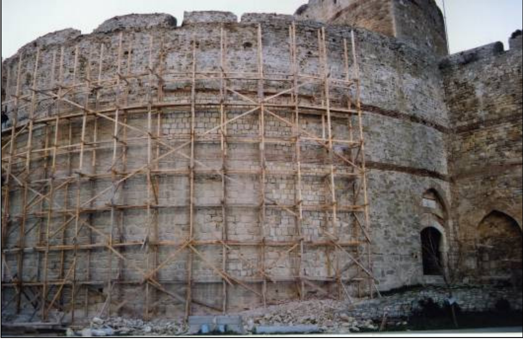
Resim 60 : Kilitbahir Kalesinde Yapılan Restorasyon alıřmaları
