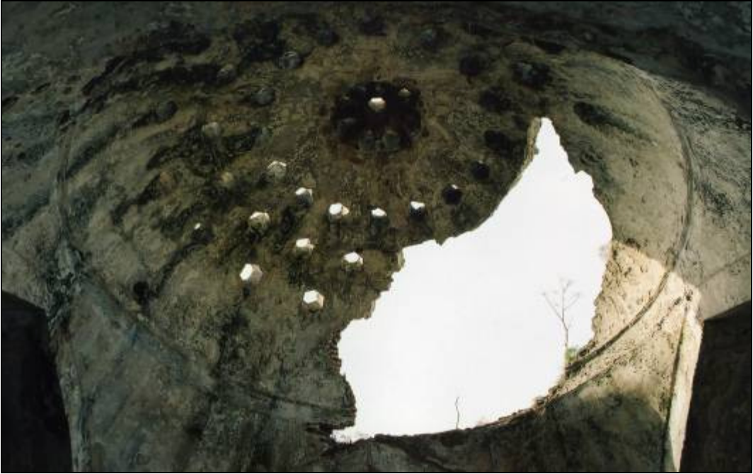
Resim 165 : Hamamın Merkezi Örtü Sistemi
