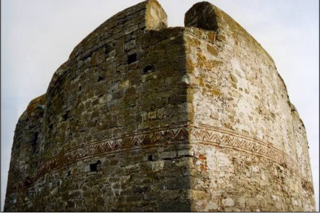
Resim 84 : Ana Kule Üzerinde Zikzak Motifli Tuğla Hatı
