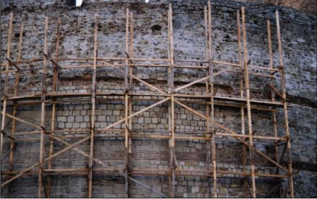
Resim 61 : Kilitbahir Kalesinde Yapılan Restorasyon alıřmaları
