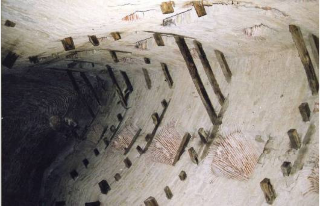
Resim 87 : Ana Kule İçindeki Ahşap Katları Destekleyen Ahşap Hatıllar
