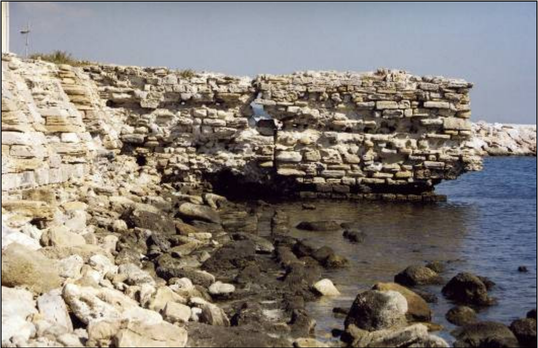
Resim 209 : Su Setinin Duvarlarının Yerleştirildiği Yuvalar
