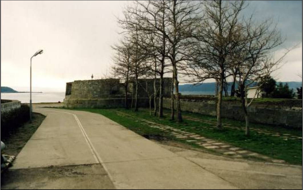
Resim 219 : Dış Surun Dairesel Burcu
