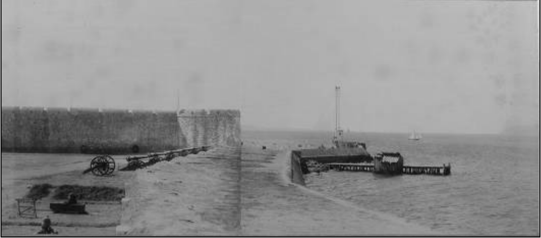
Resim 107 : Kale-i Sultaniyenin Denize Bakan Surlarının Yıkılmadan Önceki Hali (Cevat İnce'den)
