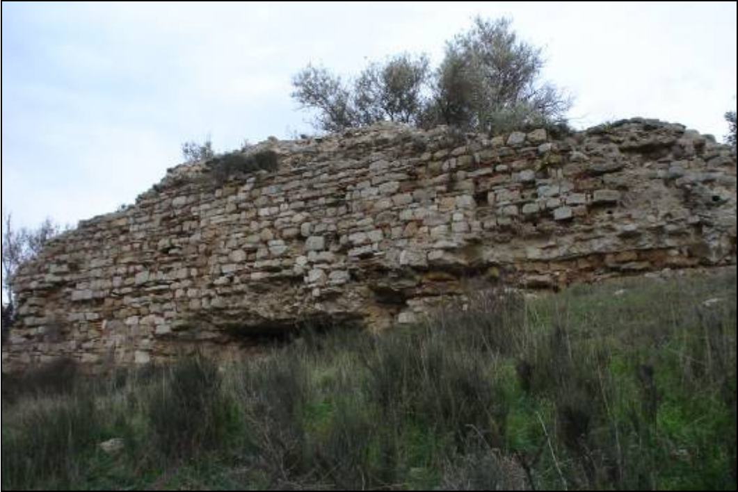
Resim 27 : Almaşık Tekniğiyle Sur Duvarları
