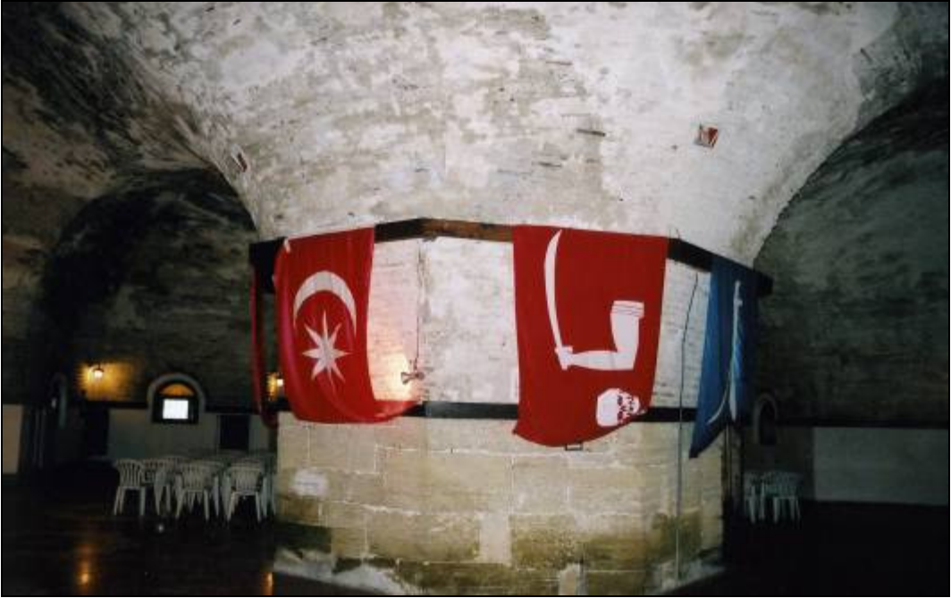
Resim 229 : Ana Kule İçinde Örtü Sitemini Taşıyan Sekizgen Ayak
