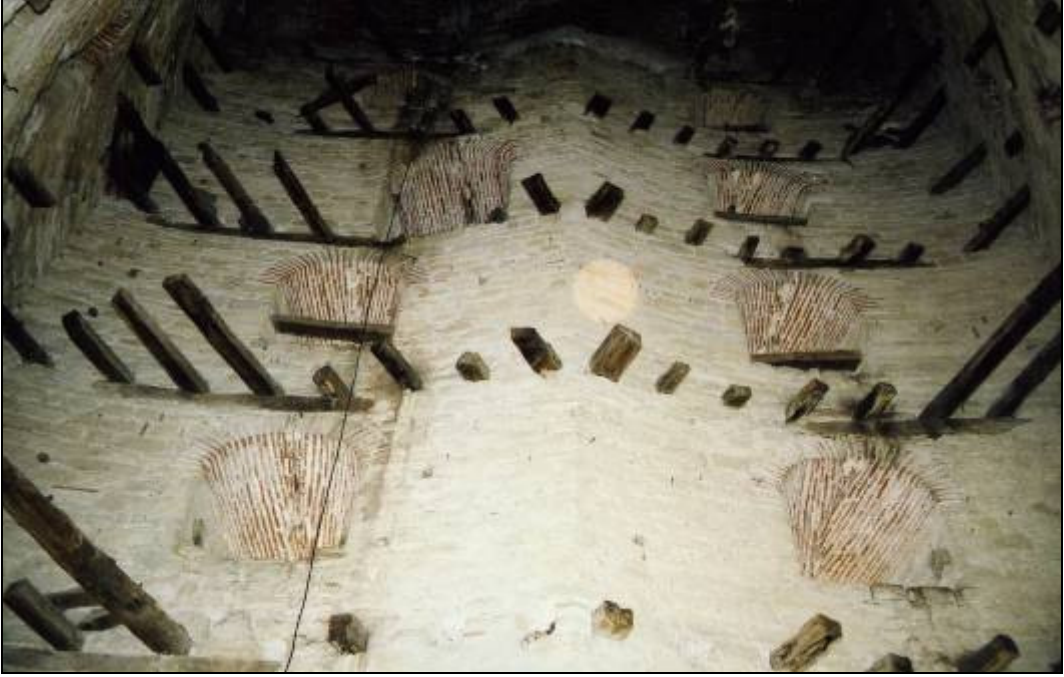
Resim 86 : Ana Kule İçindeki Ahşap Katları Destekleyen Ahşap Hatıllar
