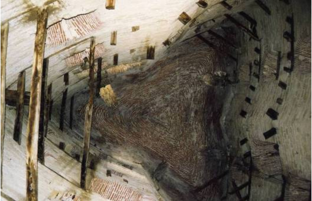
Resim 85 : Ana Kule İçindeki Ahşap Katları Destekleyen Ahşap Hatıllar
