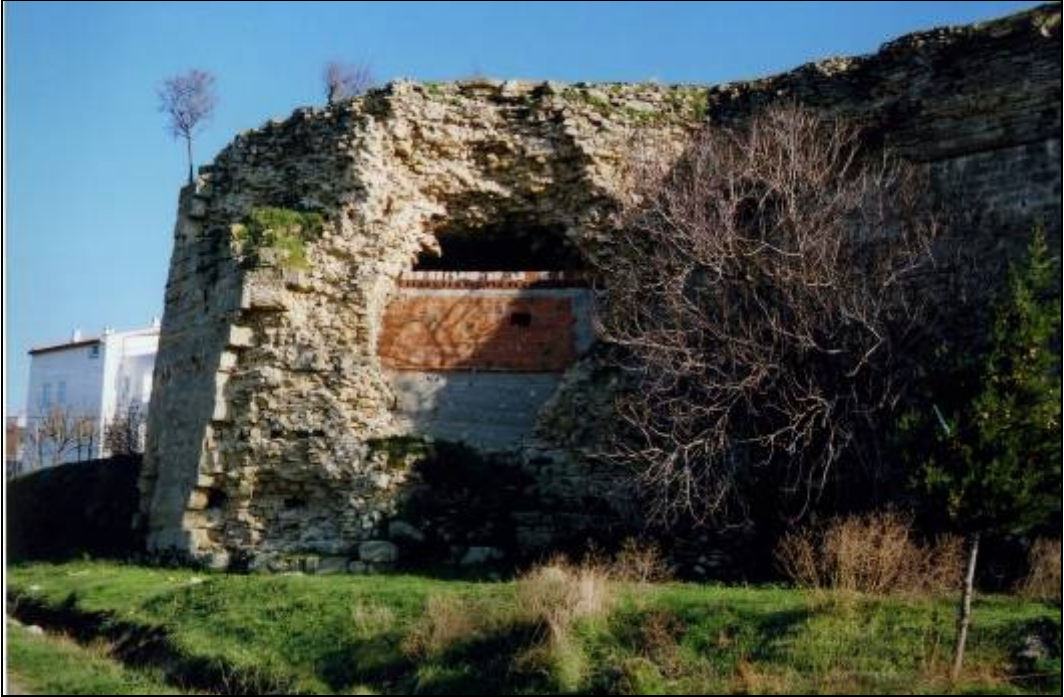
Resim 199 : Yıkılmış Olan Köşe Kulesinin Günümüz Onarımı
