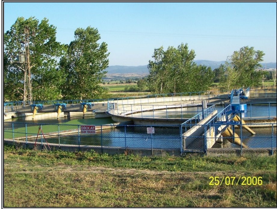
Şekil 57: Gümüşçay’da bulunan DEMKO Salça Fabrikası’na ait atık su arıtma bölümü
