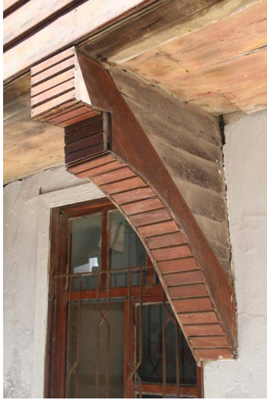
Resim 140: Katalog No:21 Çıkma Taşıyıcı Destek Görünüşü (2006 – F.Oral)
