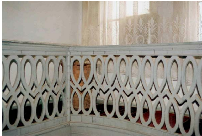
Resim 36: Katalog No:1 Merdiven Görünüşü (2002 – H.Baloğlu Arş.)
