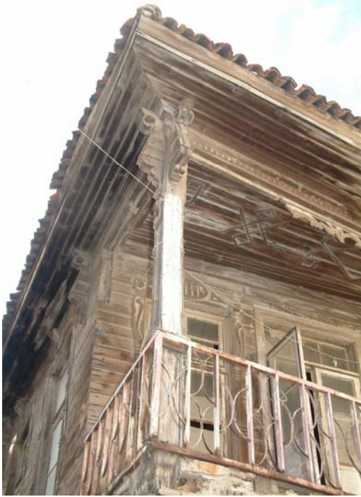
Resim 510: Katalog No:105 Balkon Saçak Görünüşü (2005- Gelibolu Belediyesi Arşivi)
