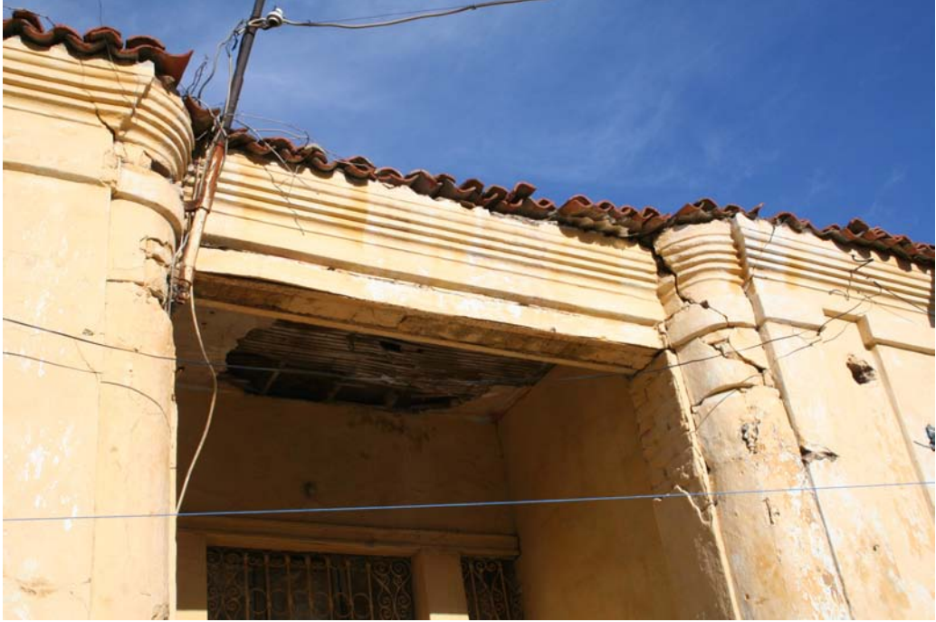
Resim 263: Katalog No:41 Çatı Silmesi Görünüşü (2005 – F. Oral)
