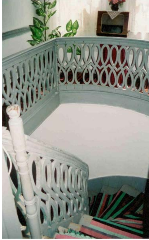
Resim 35: Katalog No:1 Merdiven Görünüşü (2002 – H.Baloğlu Arş.)
