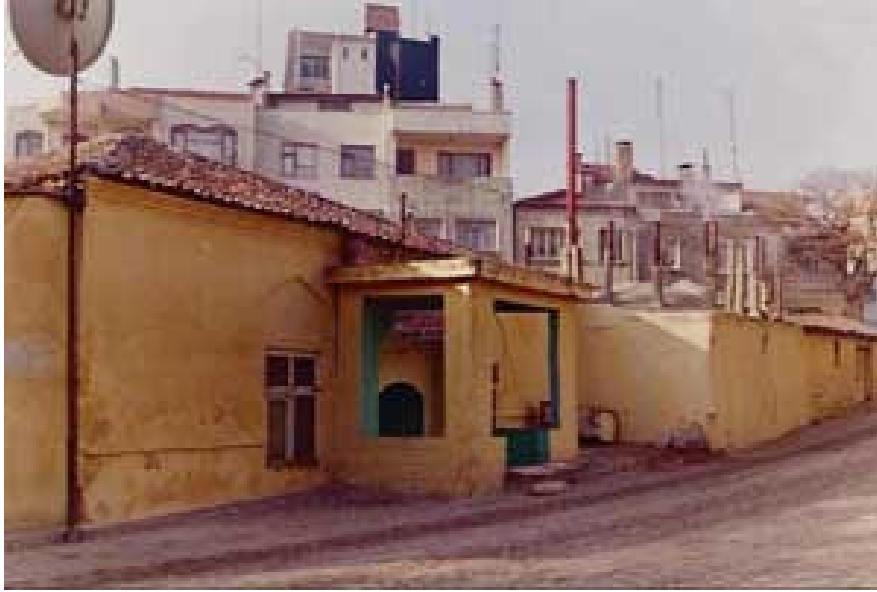
Resim 30: Pazar Hamamı Görünüşü
