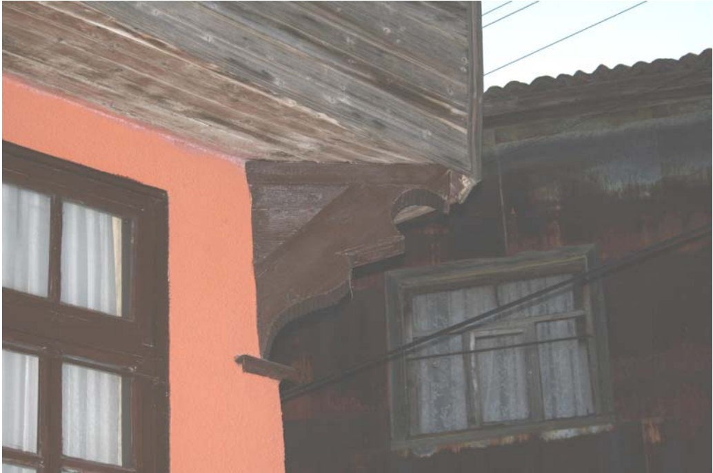
Resim 692: Katalog No:139 Ahşap Taşıyıcı Görünüşü (2005- F.Oral)
