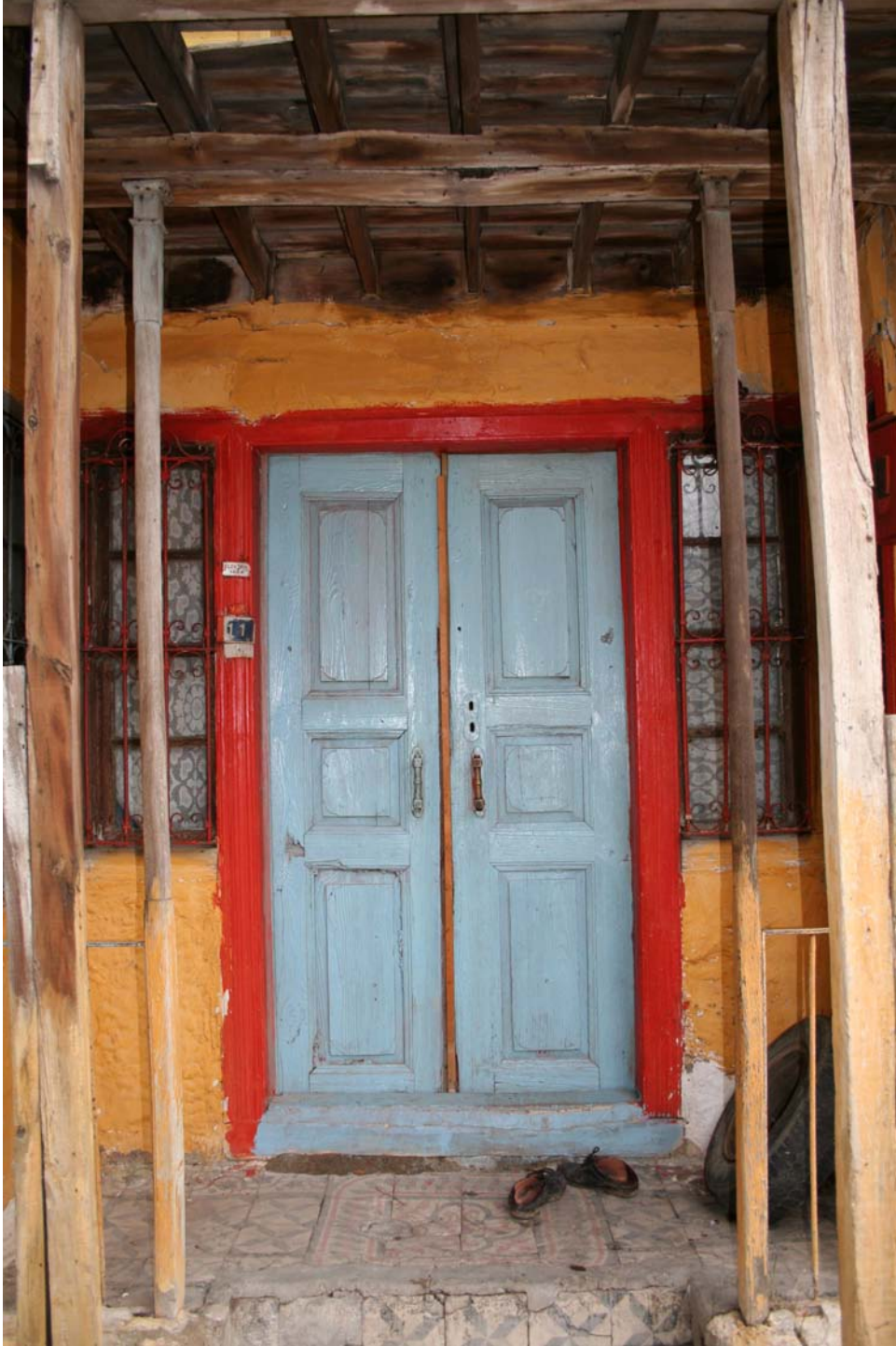
Resim 297: Katalog No:47 Giriş Nişine Yerleştirilen Ahşap Taşıyıcı Görünüşü (2004 – F.Oral)
