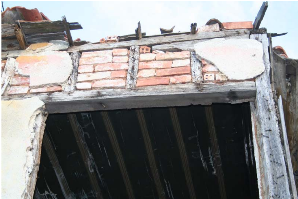
Resim 127: Katalog No:14 Sol Yan Cephesinden GörünüŖü (2005 – F.Oral)
