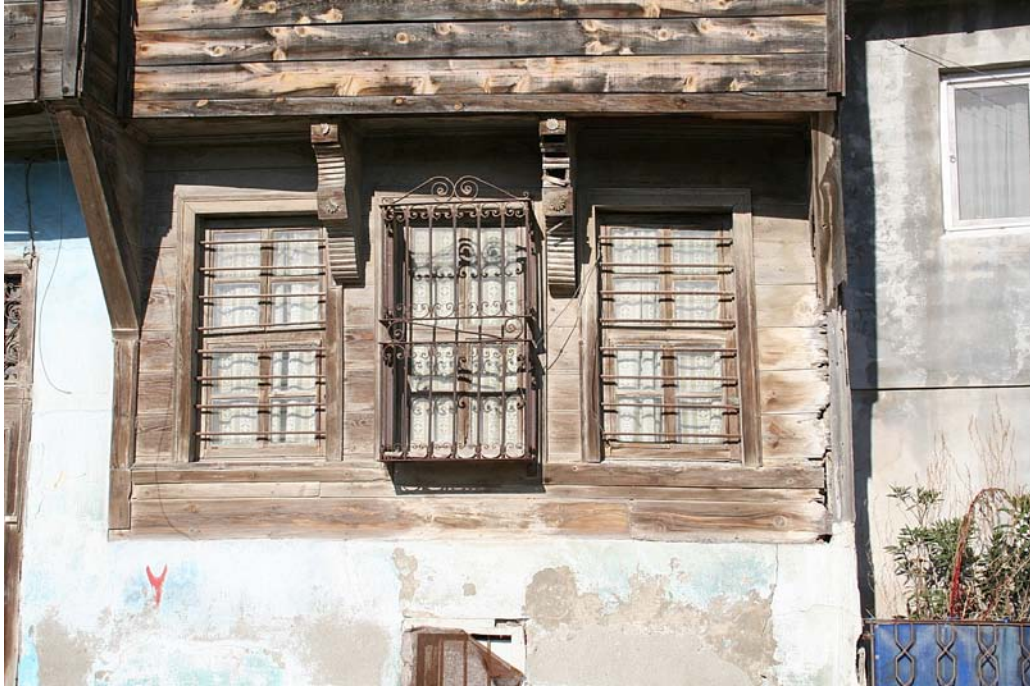
Resim 112: Katalog No:13 Konsol Çıkma Detay Görünüşü (2005 – F.Oral)
