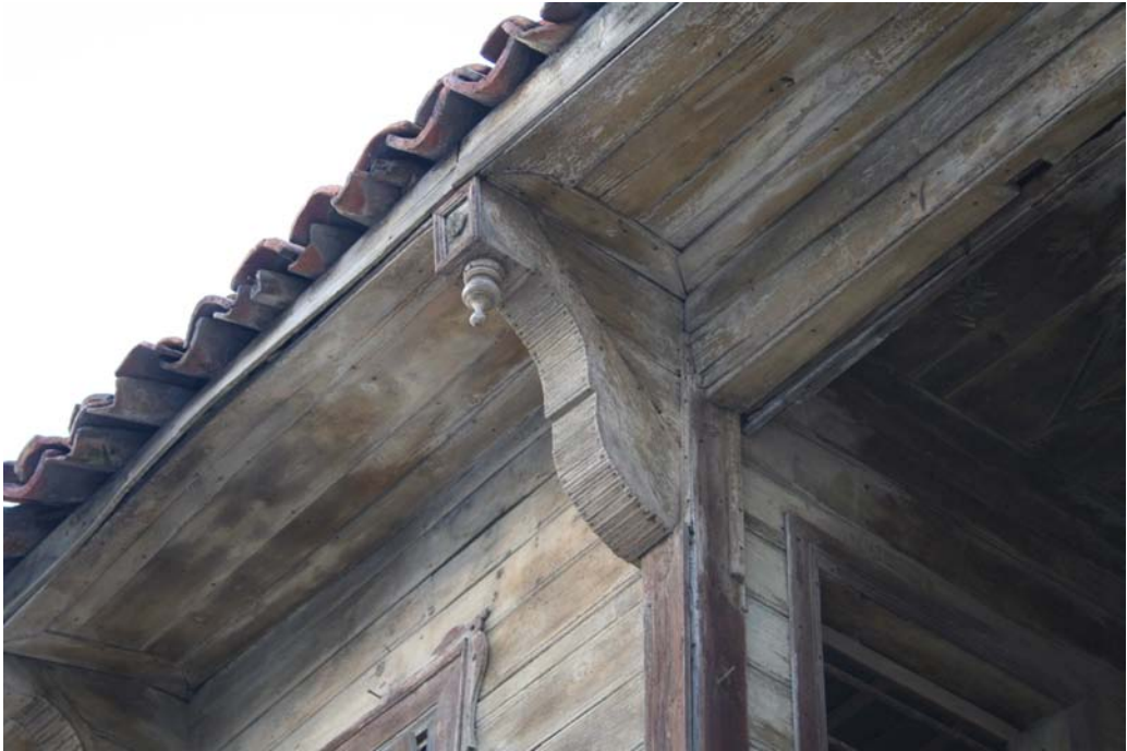
Resim 119: Katalog No:14 Saçak Konsol Detay Görünüü (2005 – F.Oral)
