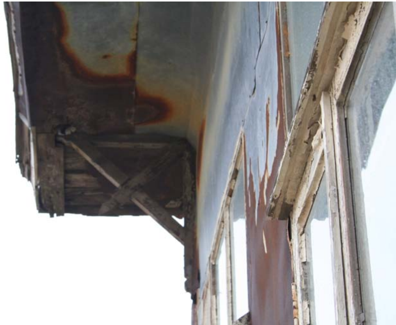
Resim 625: Katalog No:128 Saçak Ahşap Taşıyıcı Görünüşü ( 2005 – F.Oral)
