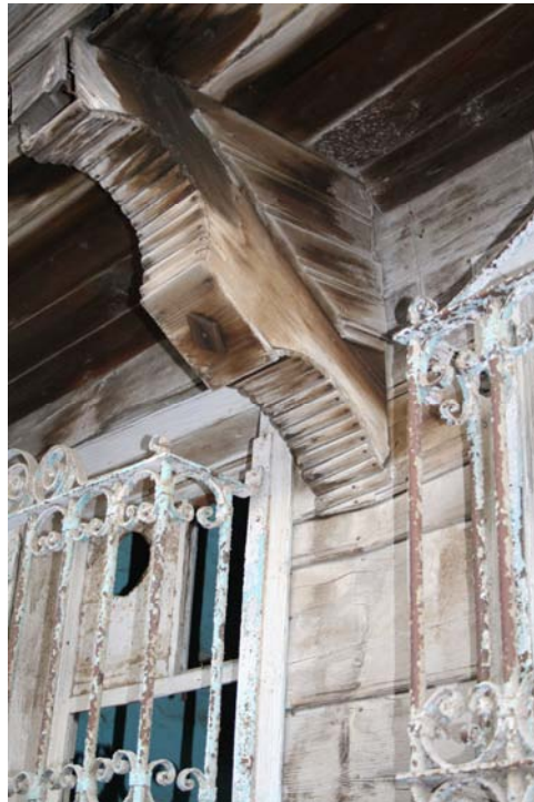
Resim 647: Katalog No:132 Ahŧap Taŧıyıcı Görünüŧü (2005- F.Oral)
