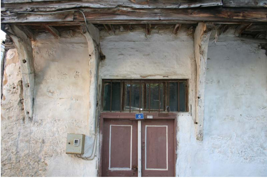
Resim 666: Katalog No:135 Ahşap Taşıyıcı Görünüşü (2005- F.Oral)
