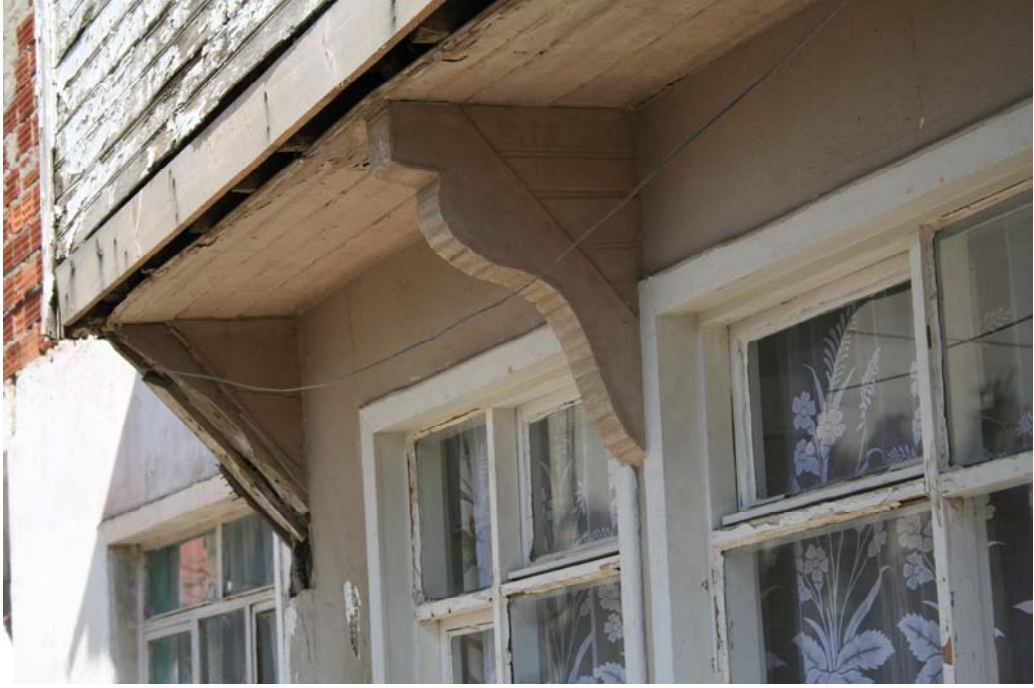
Resim 492: Katalog No:99 Ahşap Taşıyıcı Görünüşü (2006 – F.Oral)
