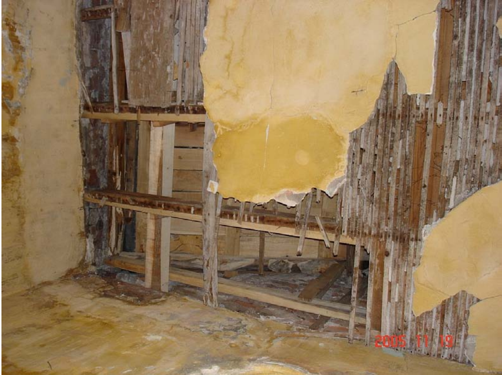
Resim 560: Katalog No:113 Birinci Kat Bölme Duvarı Görünüşü (2005- F.Oral)
