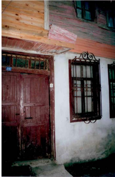
Resim 709: Katalog No:141 Giriş Kapısı ve Zemin Kat Pencere Görünüşü (2006- F.Oral)
