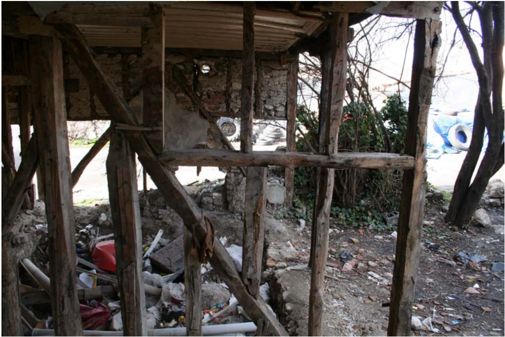
Resim 272: Katalog No:44 Bölme Duvarları Taşıyıcı Sistem Görünüşü (2006 – F. Oral)
