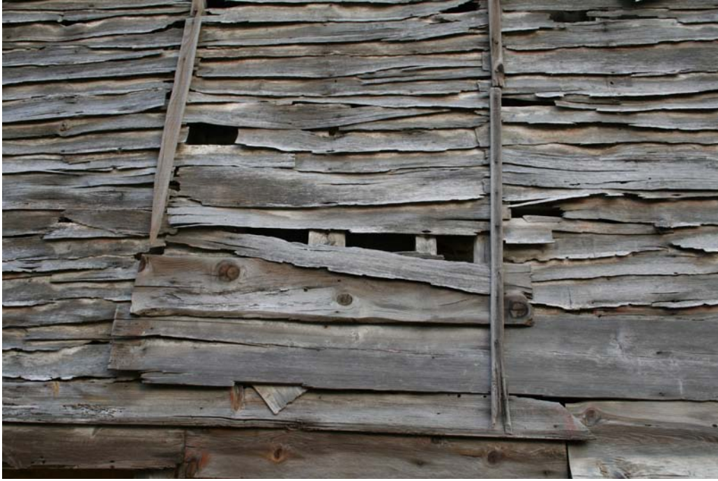
Resim 596: Katalog No:123 Arka Cephe Ahşap Kaplama Görünüşü (2005- F.Oral)
