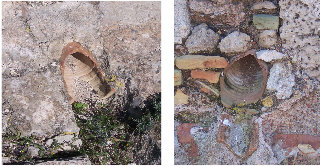
Resim.63 Salamis Antik Kenti, pişmiş toprak borular, Gazimagusa, Kıbrıs
