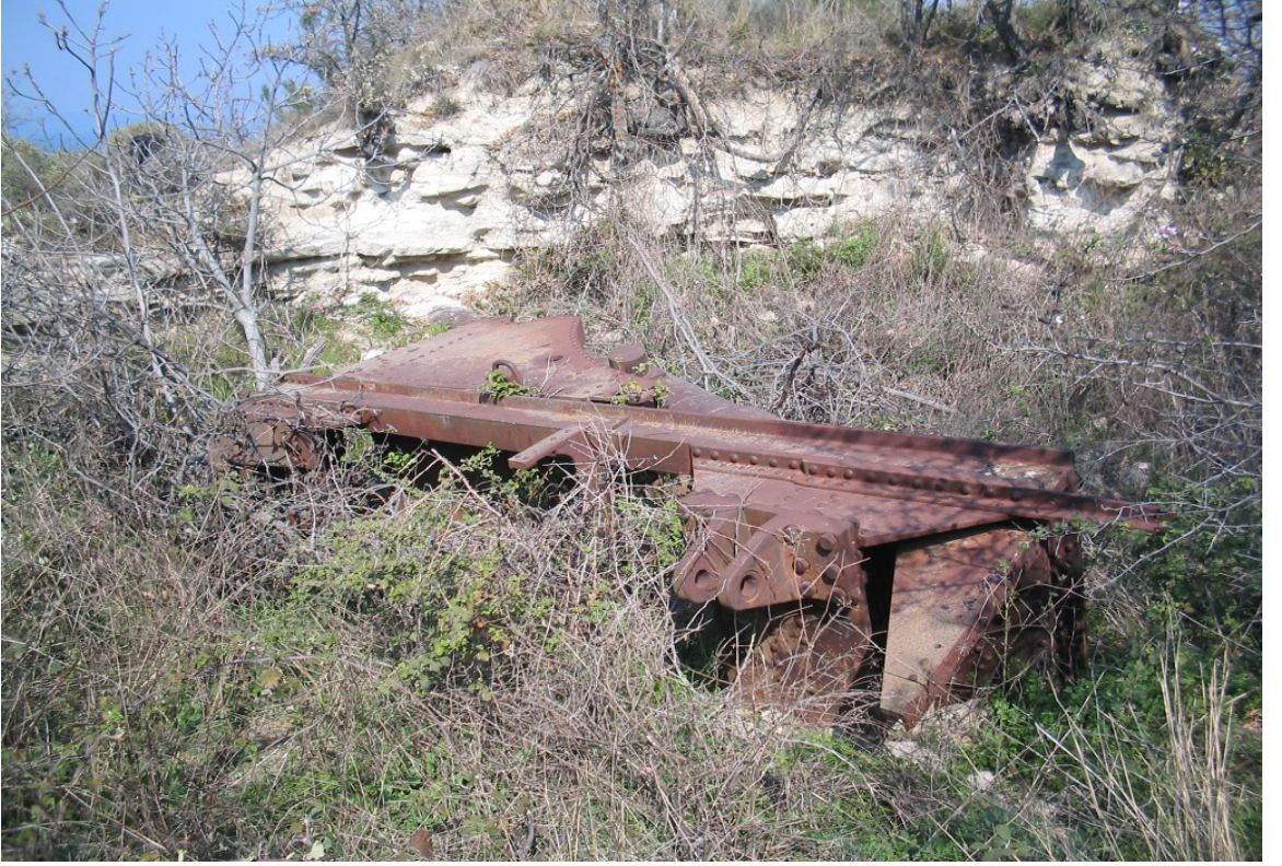
Resim 19: Erenköy Tabyası'na ait başka bir top kundağı ve yıkık surlar.
