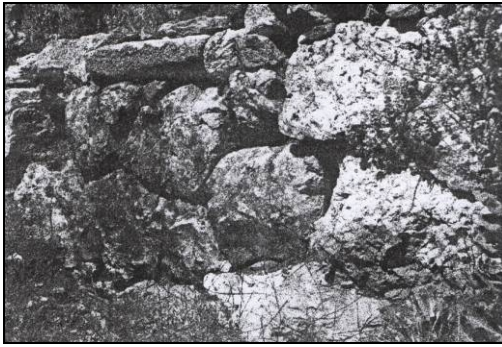
Resim 93: Eklektik Duvar Tekniği.
