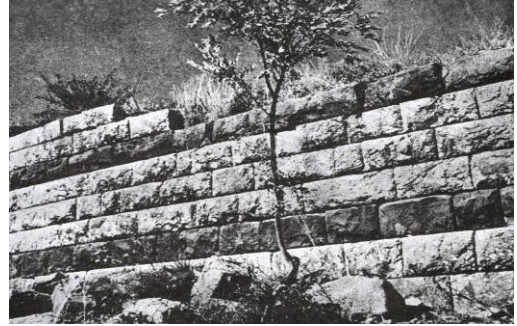
Resim 24: Erithrai Kalker Savunma Duvarlarında Trakhit Kuşaklar.
