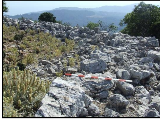
Resim 84: İç Savunma Duvarı
