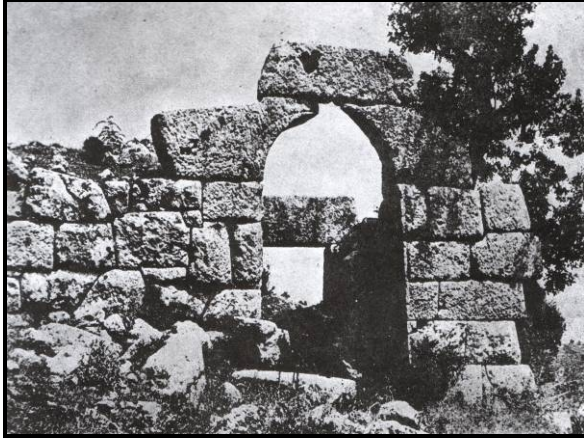
Resim 55: Palaio-Manina. Yalancı Kemer
