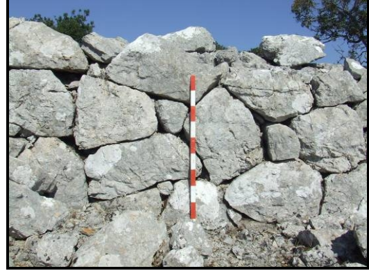
Resim 78: Polygonal Duvar Örgüsü
