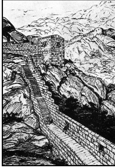
Resim 43: Latmos Eteğindeki Herakleia. Savunma Duvarları ve Seyirdim Yeri.
