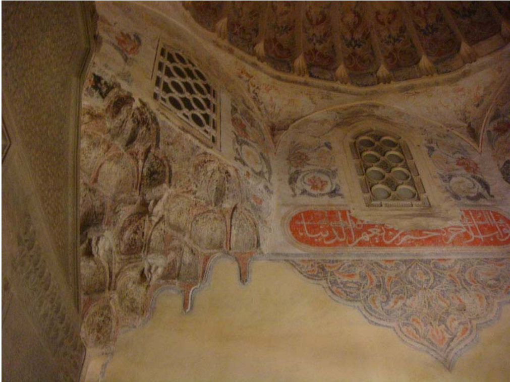
Resim 16: Bursa Yeşil Cami, güney batı köşe odasının kubbe geçiş öğelerindeki kalem işlerinden görünüş
