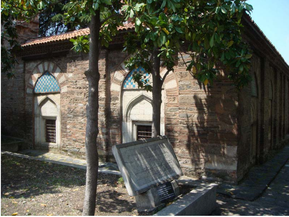
Resim 71: Bursa Yeşil Medrese, doğu arka cephesinden görünüş.
