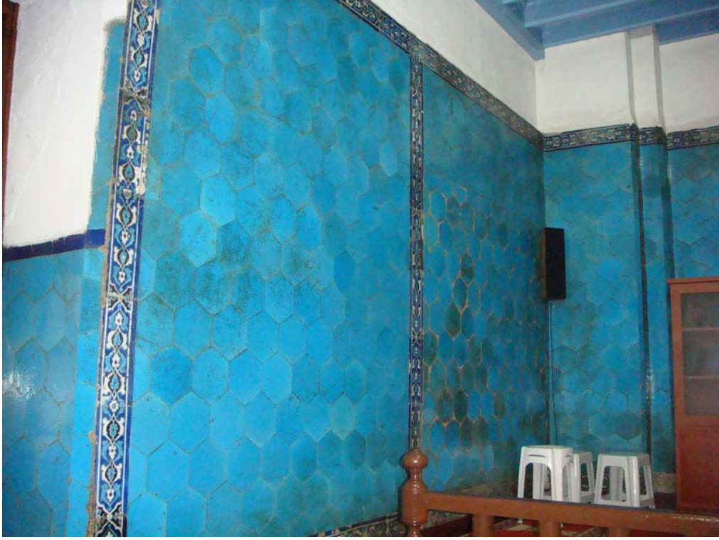
Resim 120: Bursa Muradiye Camii, iç duvar çini kaplamasından görünüş.
