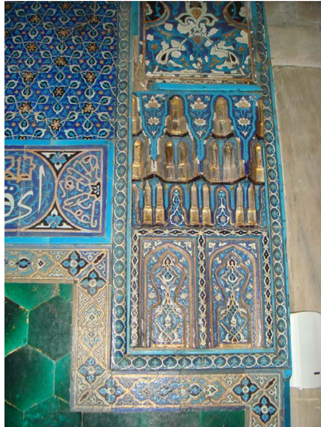
Resim 26: Bursa Yeşil Camii, doğu müezzin mahfilinden görünüş.
