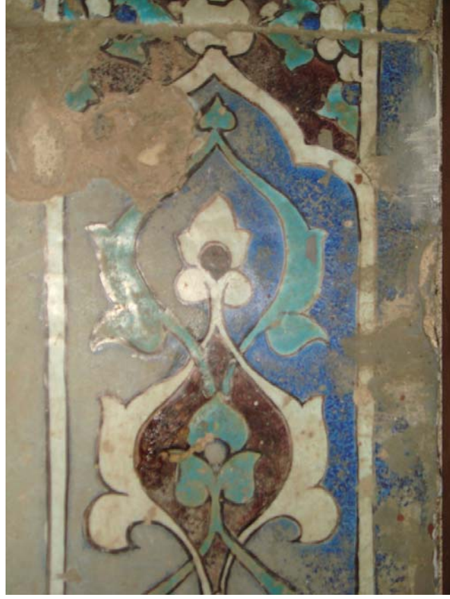
Resim 128: Bursa Muradiye Camii, minberin yanındaki duvar çini kaplamasının bordür çinilerinden detay.
