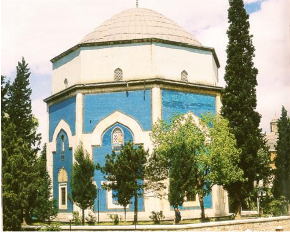
Resim95: Bursa Yeşil Türbe, dış görünüş.
