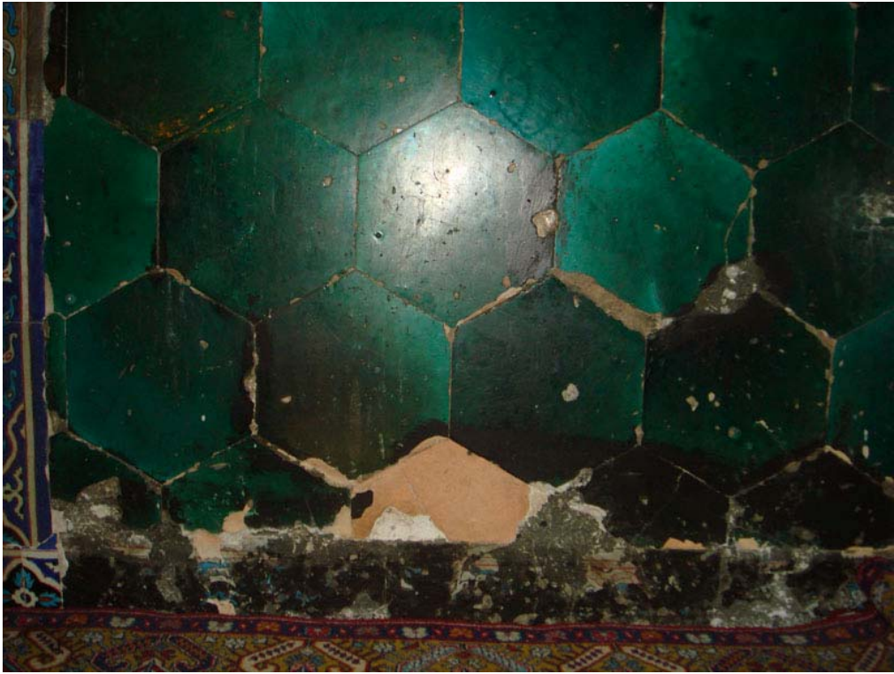
Resim 28: Bursa Yeşil Camii, doğu müezzini mahfili tek renk sırlı çini kaplı duvarından detay.
