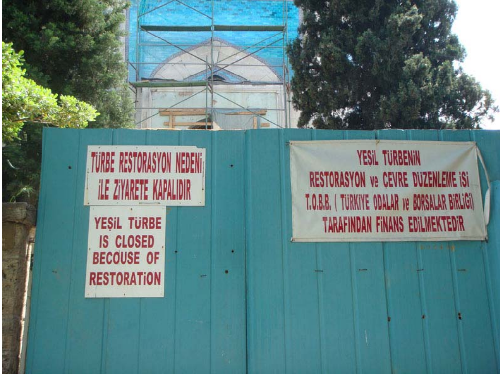
Resim96: Bursa Yeşil Türbe, restorasyon çalışmasından görünüş.
