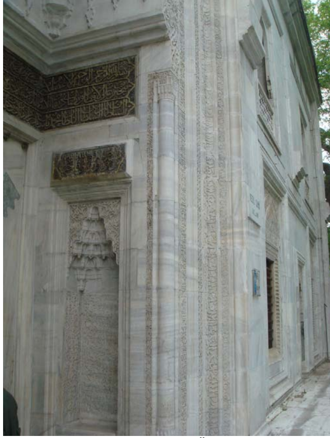
Resim 3: Bursa Yeşil Cami, Ön cepheden detay.
