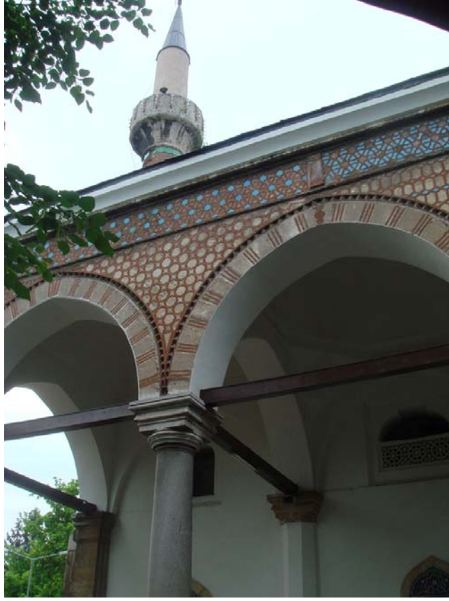
Resim 104: Bursa Muradiye Camii, dış cepheden görünüş.
