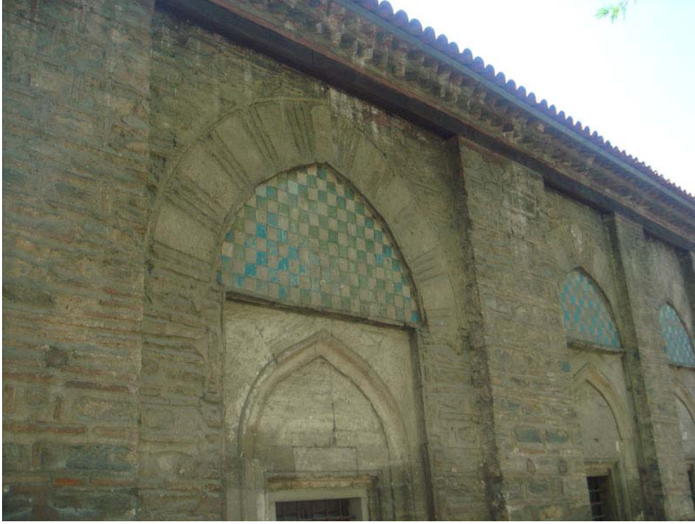
Resim 73: Bursa Yeşil Medrese, doğu yan cephesinden detay.
