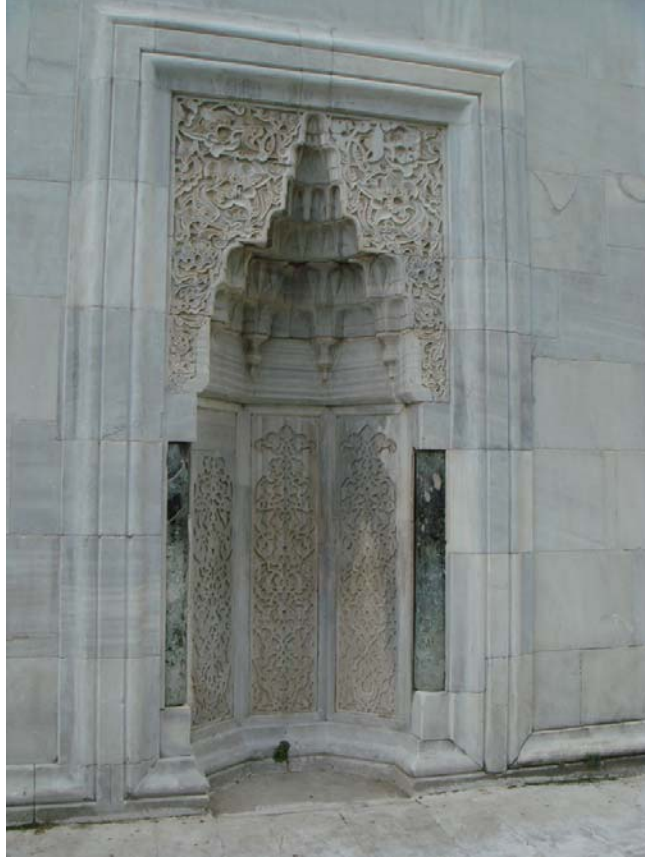
Resim 7: Bursa Yeşil Cami, giriş cephesinde mihraptan görünüş.
