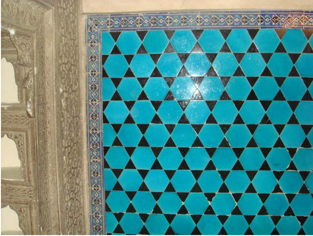
Resim 48: Bursa yeşil Camii, ibadet mekanına kapı ile bağlanan tabhane duvarlarından detay.
