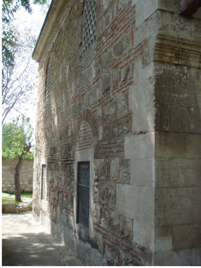
Resim 184: Edirne Şah Melek Camii, doğu yan cepheden görünüş.
