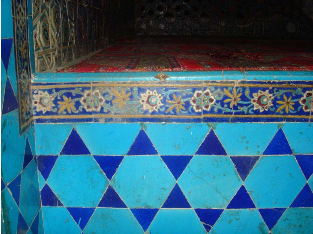
Resim 58: Bursa Yeşil Camii, hünkar mahfil basamak duvarındaki çinilerden detay.
