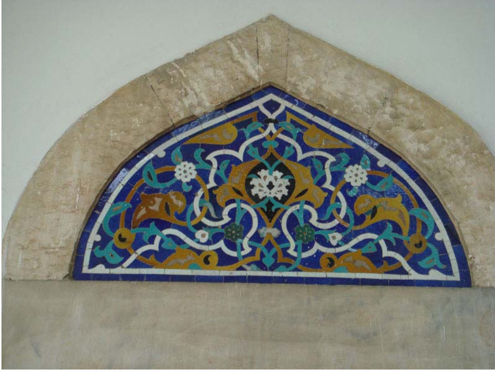
Resim 108: Bursa Muradiye Camii, son cemaat yerine bakan pencere alınlıklarından görünüş.
