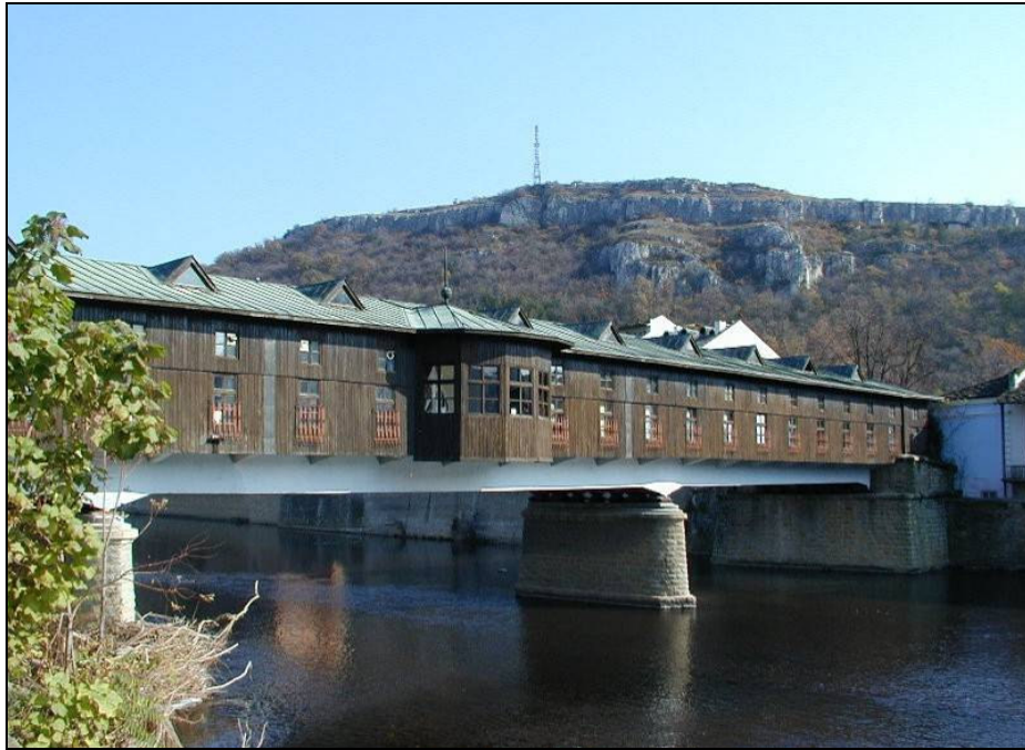
Foto.163: Bulgaristan Lofça Lovech Köprüsü
