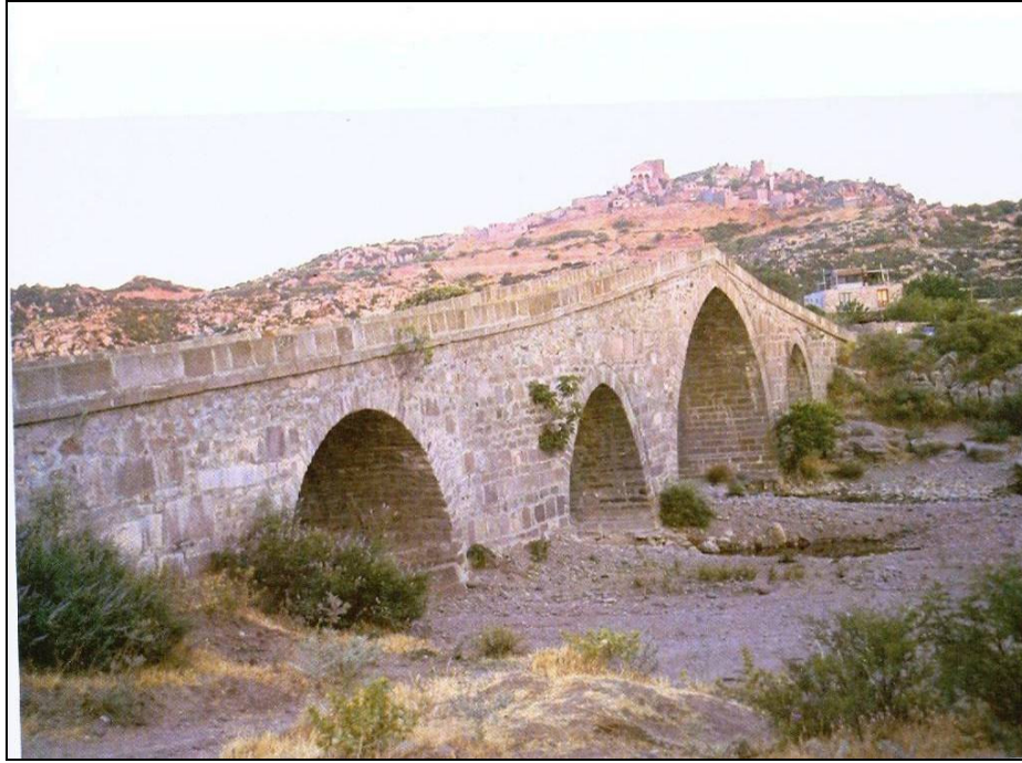
Foto.77: Behramkale Köprüsü Şehir Tarafına Bakış.
