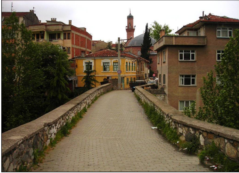
Foto.173: Boyacıkulluđu Köprüsü tabliye kısmı.
