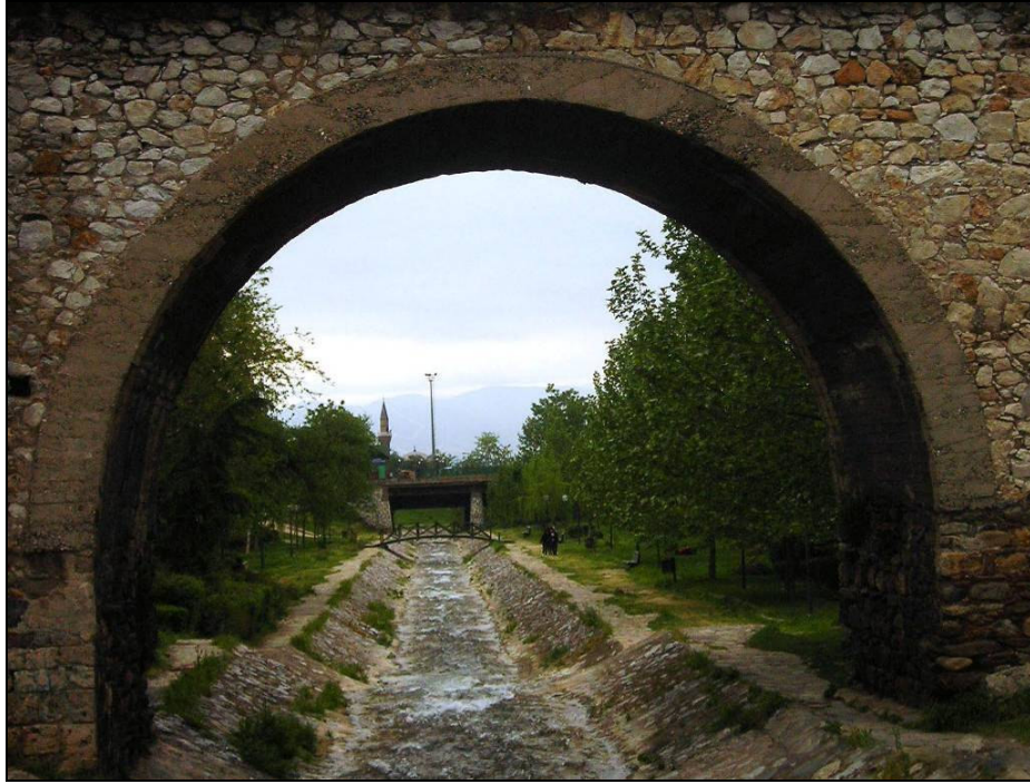
Foto.175: Boyacıkulluğu Köprüsü memba tarafı kemer açıklığı.
