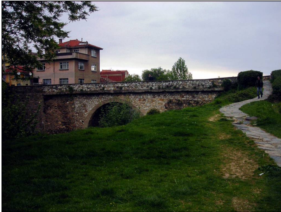
Foto.174: Boyacıkulluđu Köprüsü yanından uzanan yol.
