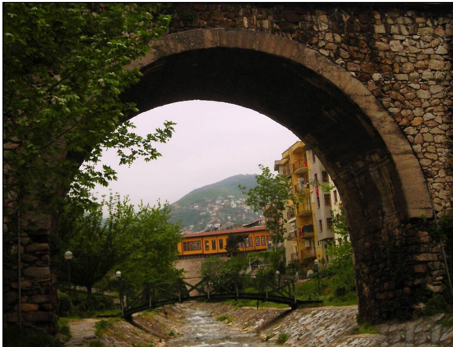
Foto.176: Boyacıkulluğu Köprüsü mansap tarafı kemer açıklığı.
