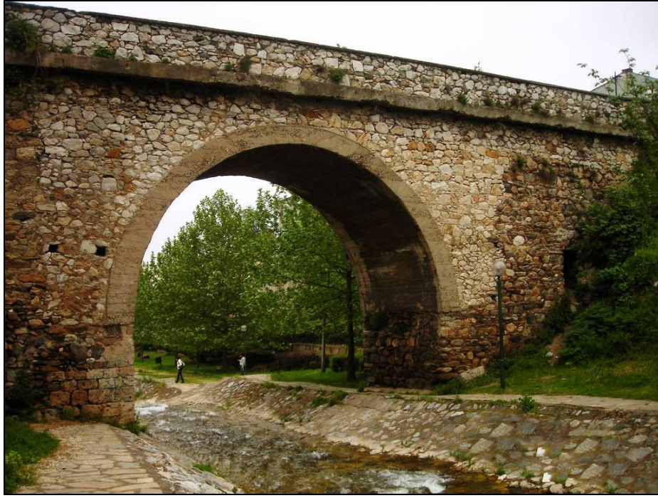
Foto.168: Boyacıkuşu Köprüsü kemer açıklığı ve tabliye.
