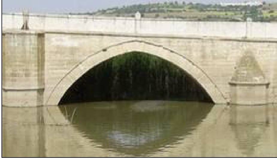
Foto.194: Fatih Sultan Mehmet Köprüsü ana göz detayı.
