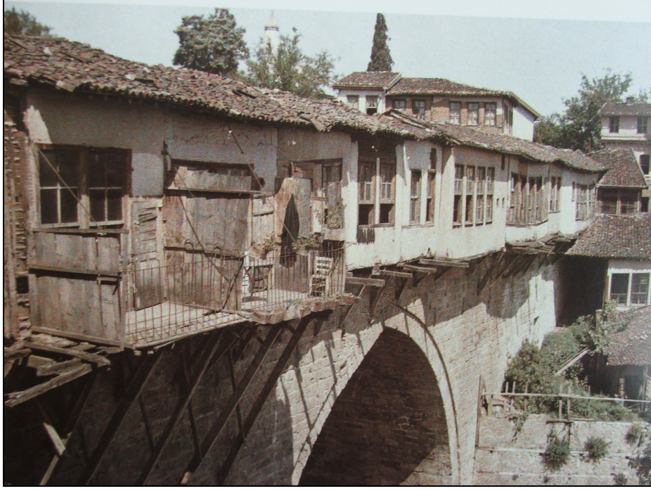
Foto.34: 1855 depreminden sonra köprü üstüne yapılmış olan ahşap binalar (Dostođlu 2001: 240).
