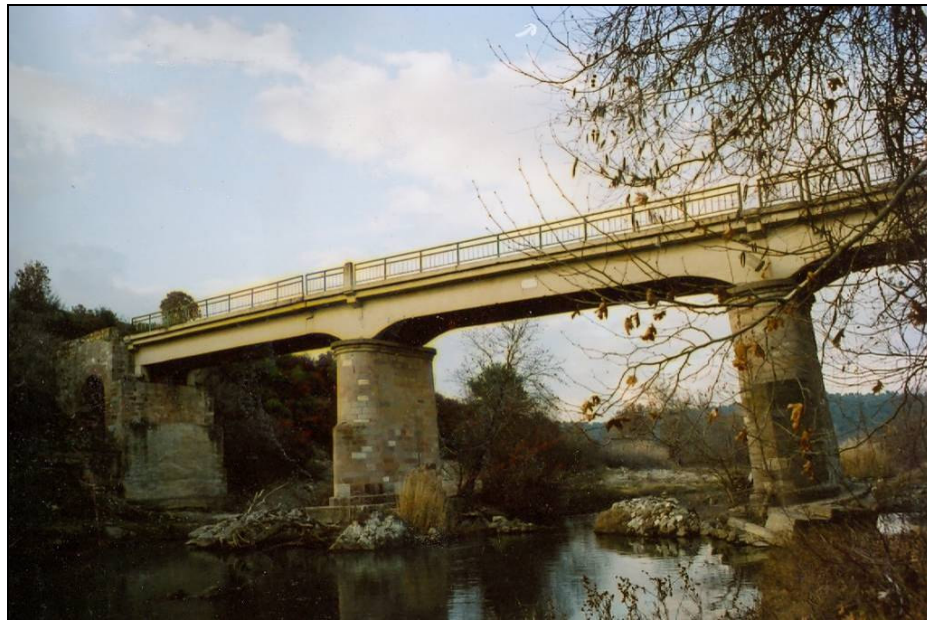
Foto.80: Asilhan Bey Köprüsü Genel Görünüü.
