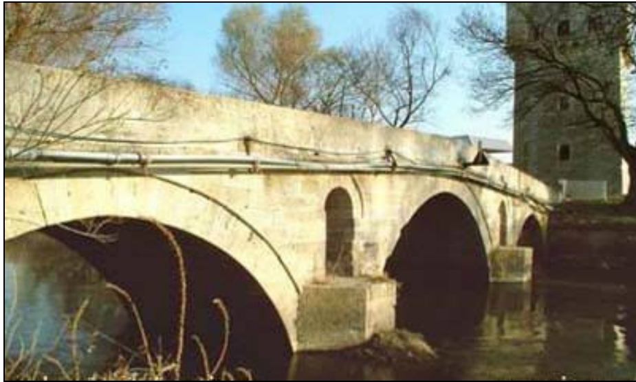
Foto.189: Fatih Sultan Mehmet Köprüsü tahliye gözü ve selyaranlar.
