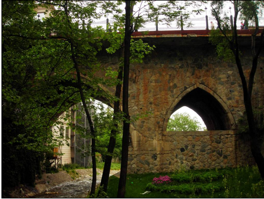
Foto.137: Setbaşı Köprüsü mansap tarafı.
