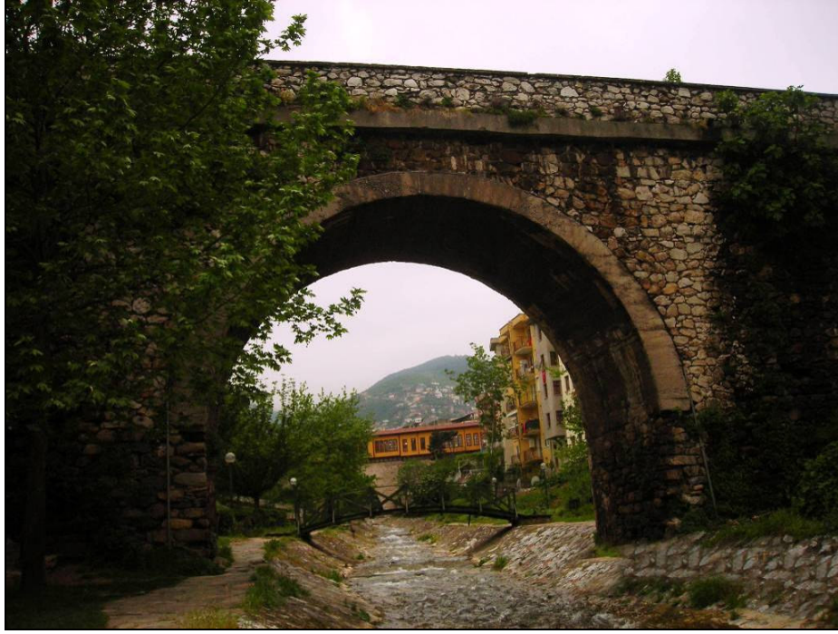
Foto.171: Boyacıkkulluğu Köprüsü mansap cephesi.
