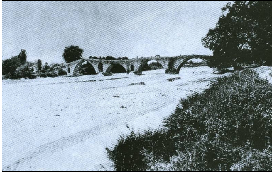
Foto.210: Narda Faik Paşa Köprüsü genel görünüş. (Çulpan'dan).
