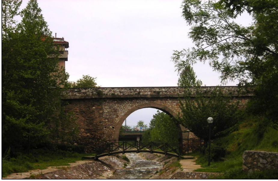
Foto.166: Boyacılluğu Köprüsü Genel Görünüŧ.
