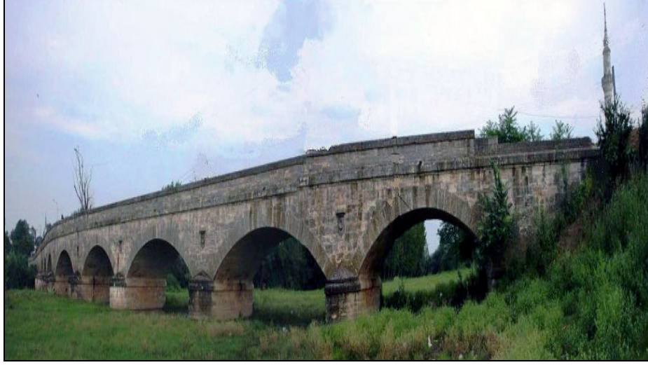
Foto.57: Gazi Mihal Köprüsü Ayaklar ve Kemerler.
