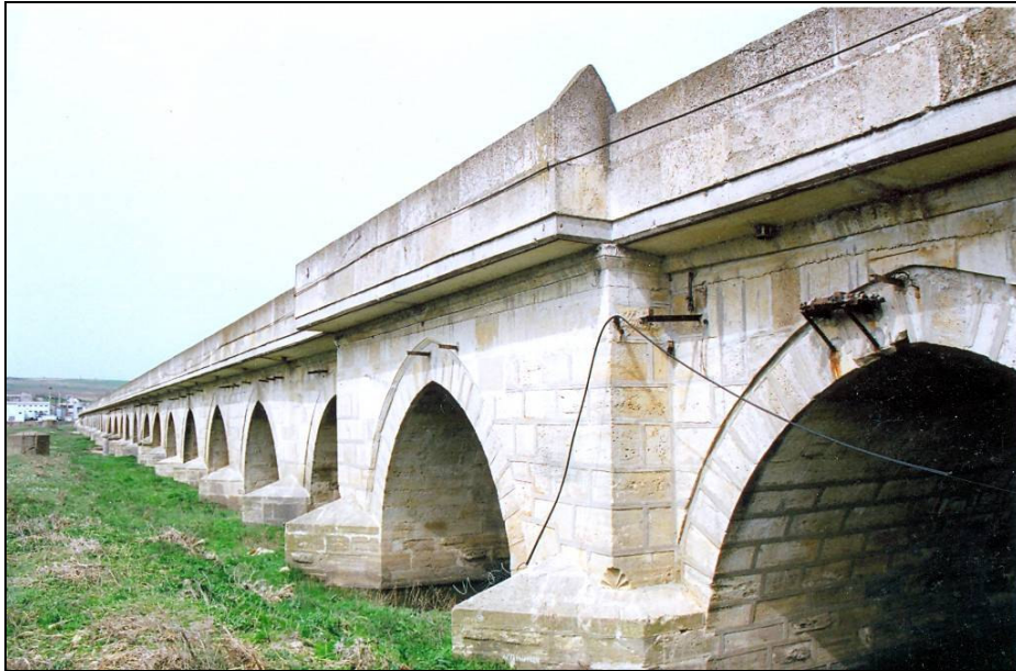
Foto.92: Uzunköprü üzerinde bulunan balkon.
