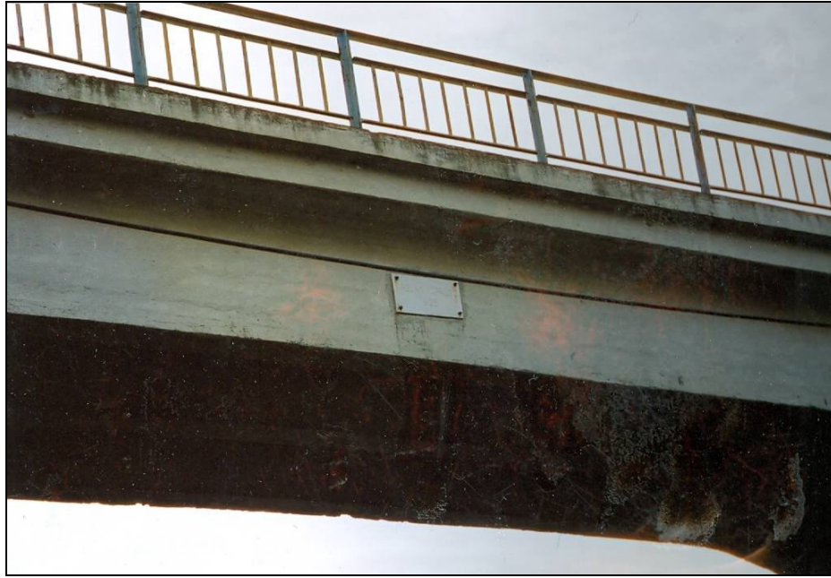
Foto.85: Asilhan Bey Köprüsü Üst Yapı Görünüşü.
