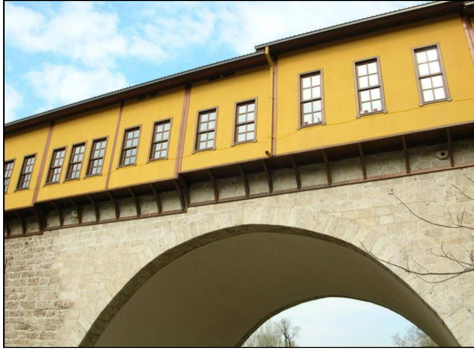
Foto.152: Irgandı Köprüsü tempan duvarı
