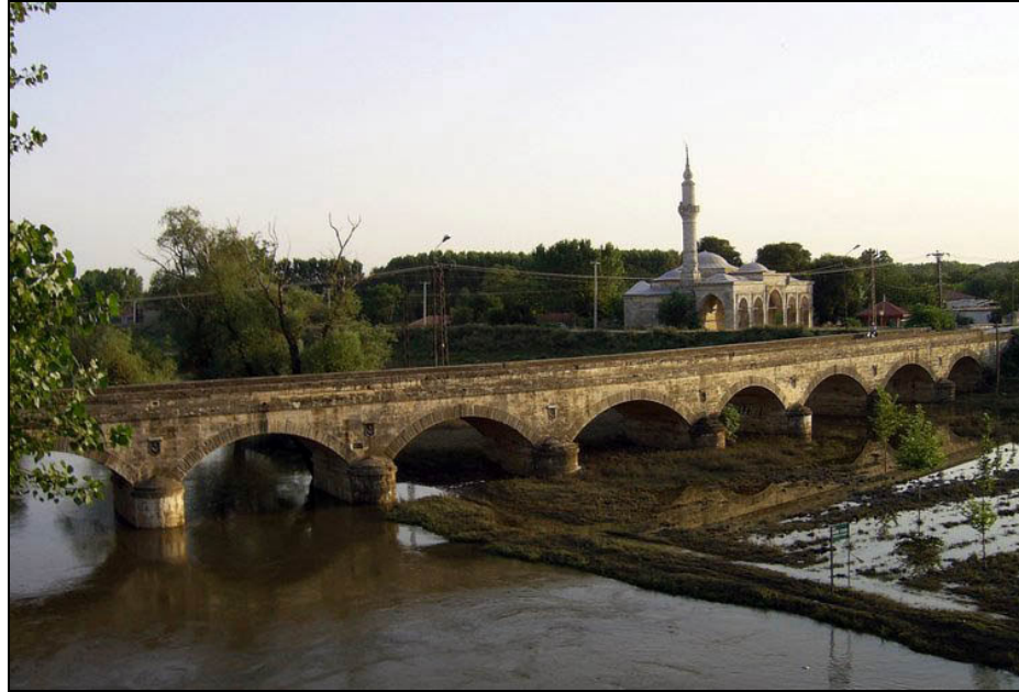
Foto.14 : Gazi Mihal Köprüsü I.Kısım Genel Görünüş.
