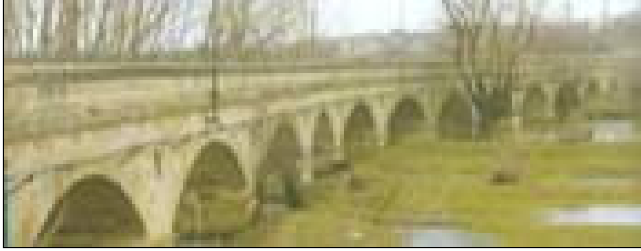
Foto.63: Gazi Mihal Köprüsü 3. Kısım Genel Görünüş.
