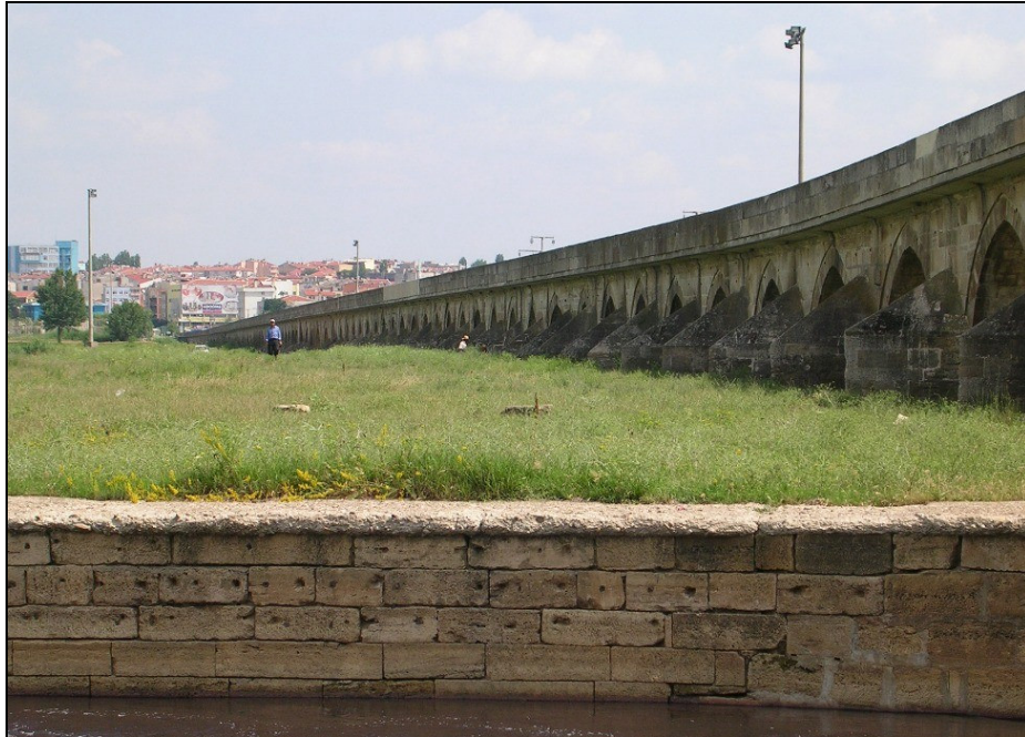
Foto.90: Uzunköprü Sıralanan Kemerler ve Selyaranlar.
