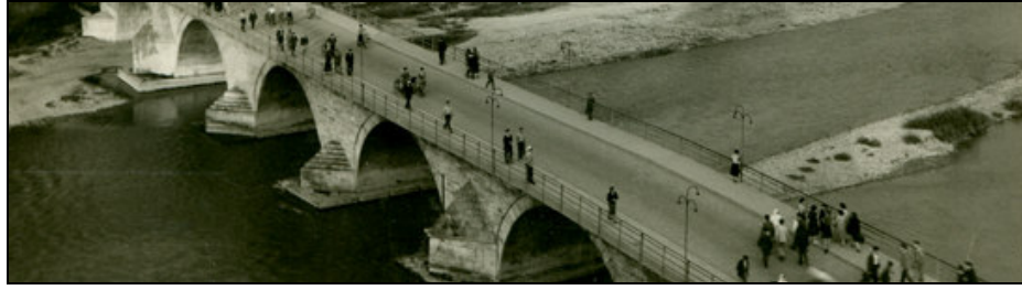
Foto.201: Vardar Fatih Sultan Mehmet Köprüsü ayaklar üzerindeki selyaranlar.
