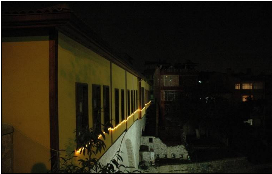
Foto.161: Irgandı Köprüsü üzerinde yer alan arasta gece görünüşü.
