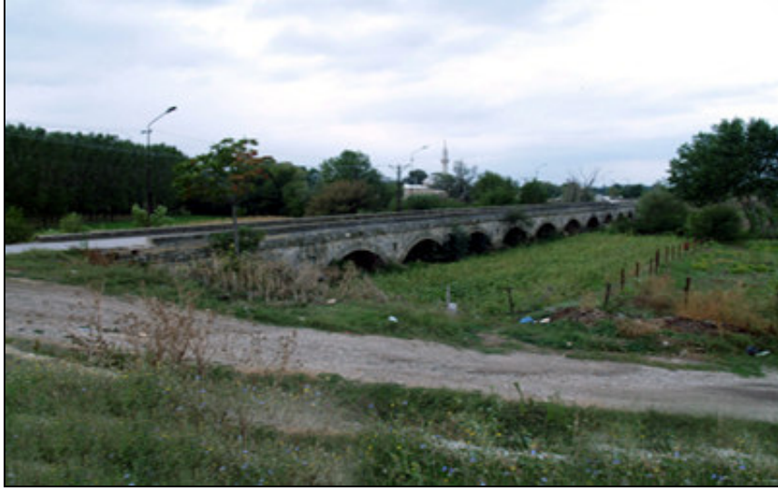
Foto.55: Gazi Mihal Köprüsü Genel Görünüş.
