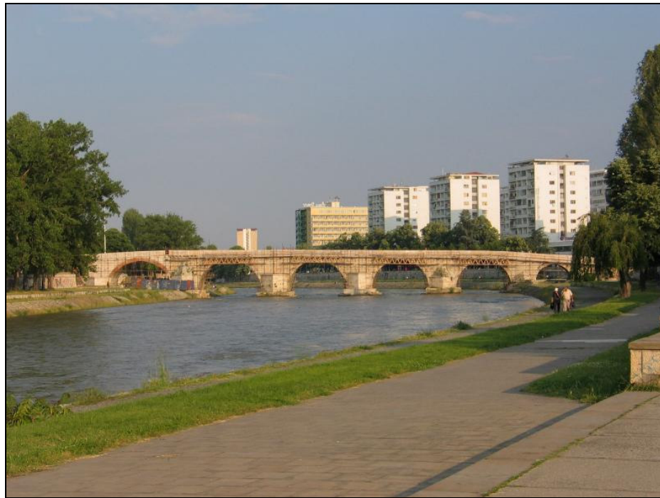
Foto.198: Vardar Fatih Sultan Mehmet Köprüsü Restorasyon.
