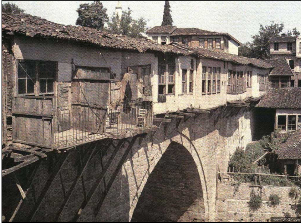
Foto.147: Irgandı Köprüsü 1855 depreminden sonra köprü üstüne yapılmış olan ahşap binalar (Dostoğlu'dan).
