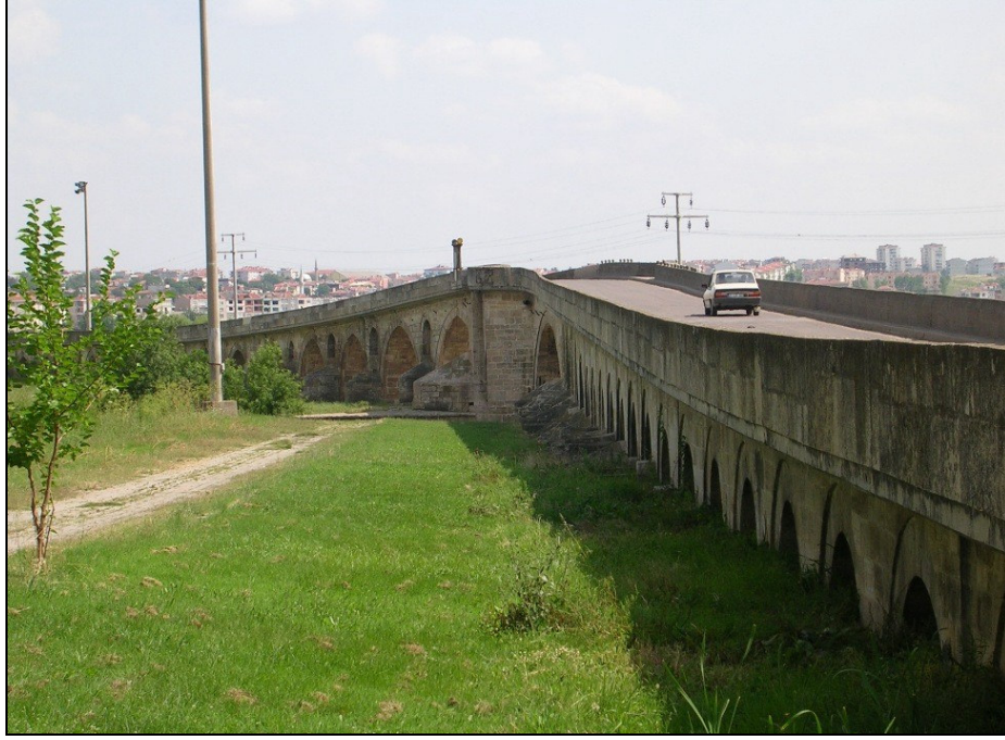
Foto.91: Uzunköprü Dolmuş Gözler.
