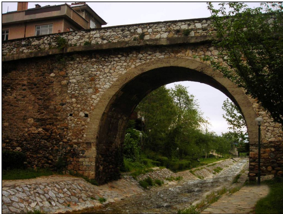
Foto.169: Boyacıkuşu Köprüsü tempan duvarı.
