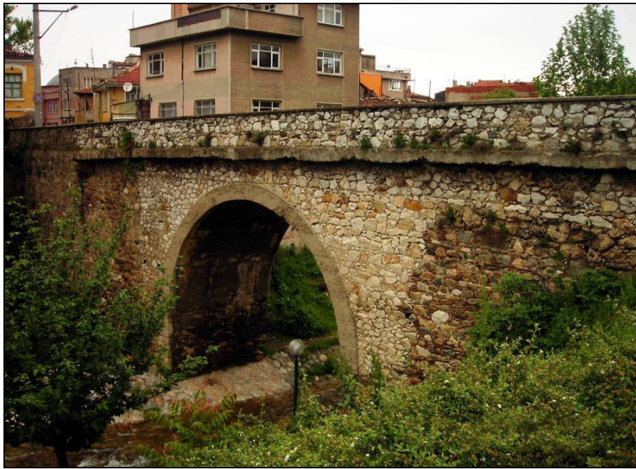
Foto.172: Boyacıkkulluğu Köprüsü korkuluklar.
