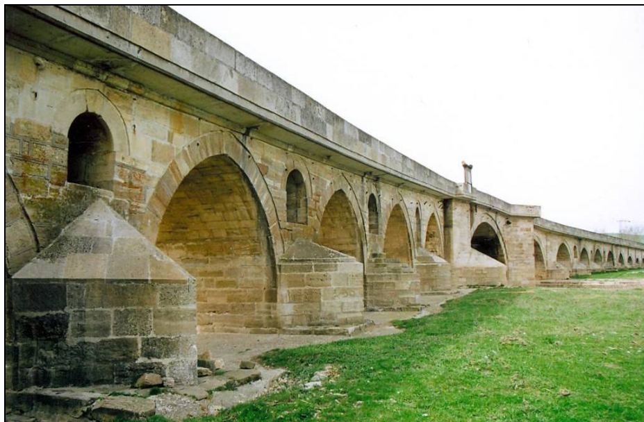
Foto.104: Selyaranların üzerinde yer alan boşaltma (tahliye) gözleri.
