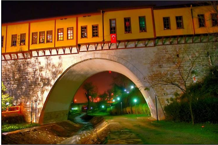
Foto.160: Irgandı Köprüsü gece görünüşü.
