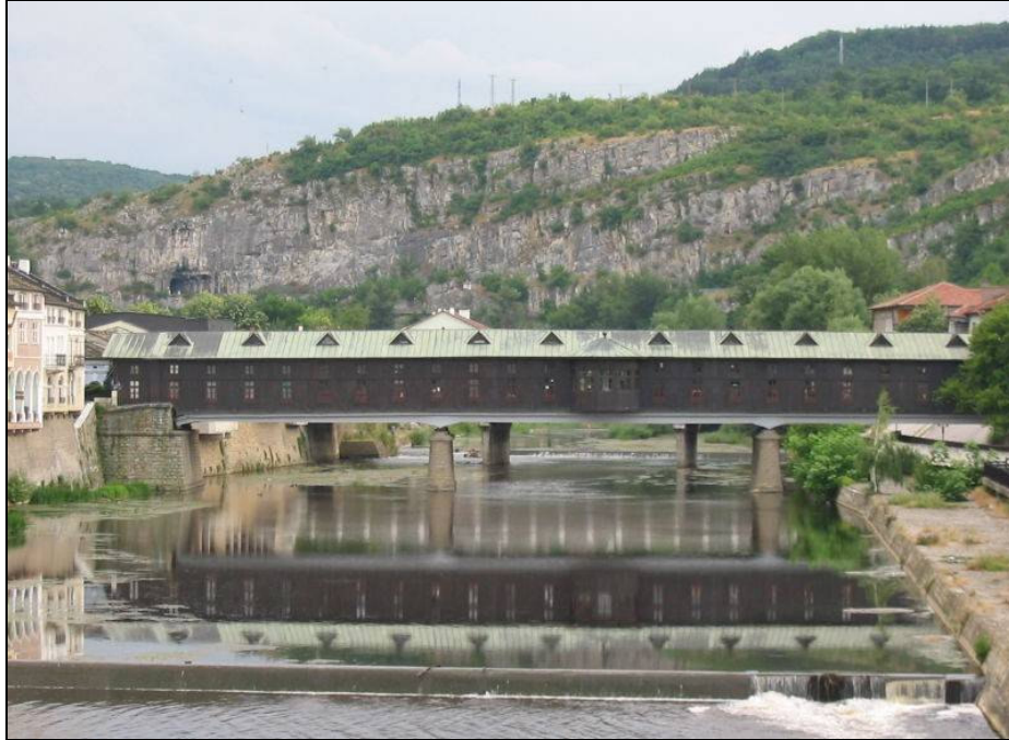
Foto.164: Bulgaristan Lofça Lovech Köprüsü
