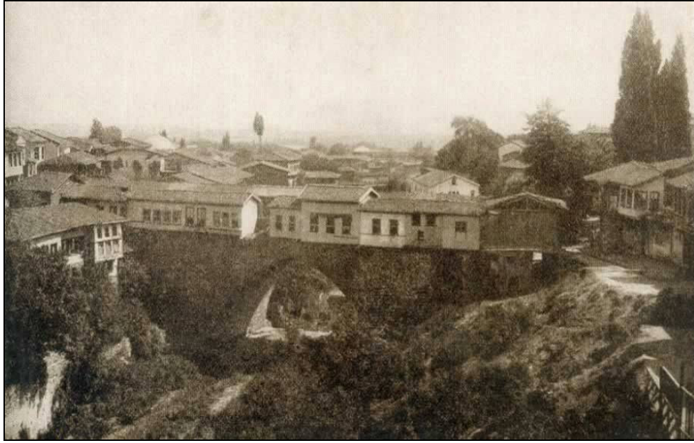
Foto.146: Irgandı Köprüsü eski durumu. ( www.wowturkey.com.tr 'den).
