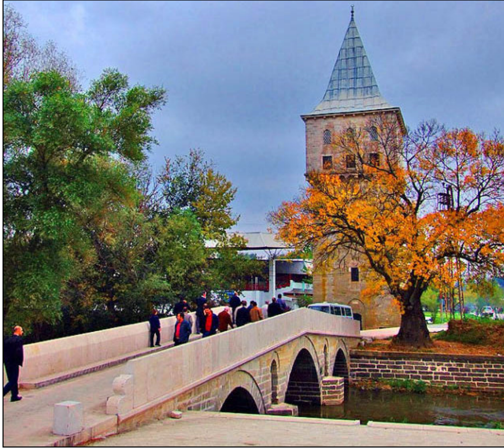
Foto.39: Fatih Sultan Mehmet Köprüsü
