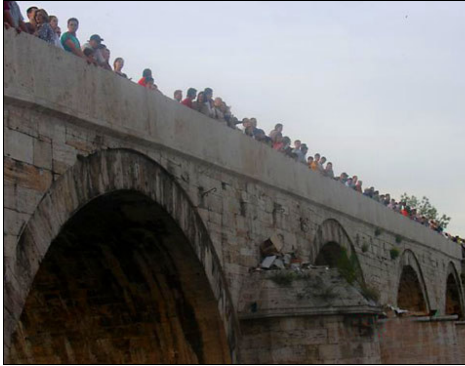
Foto.203: Vardar Fatih Sultan Mehmet Köprüsü tempan duvarı.
