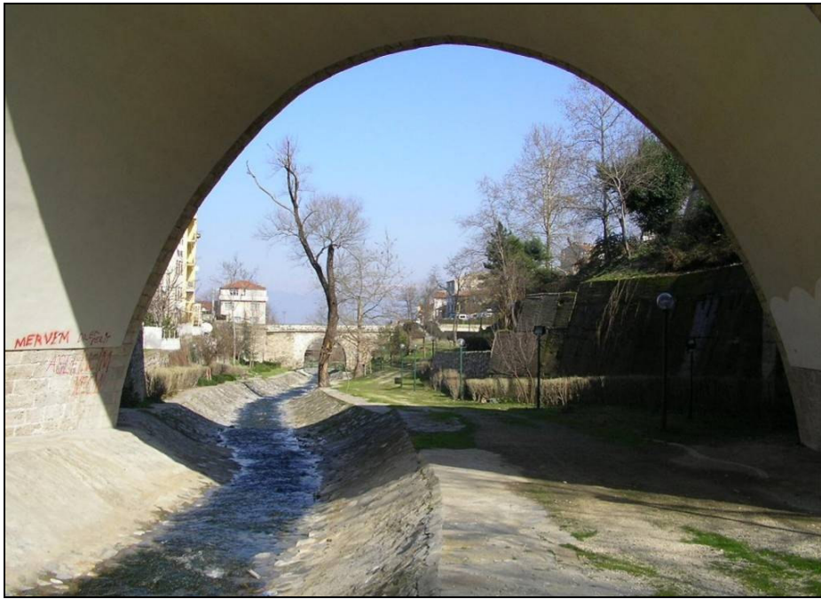
Foto.155: Irgandı Köprüsü göz detayı.
