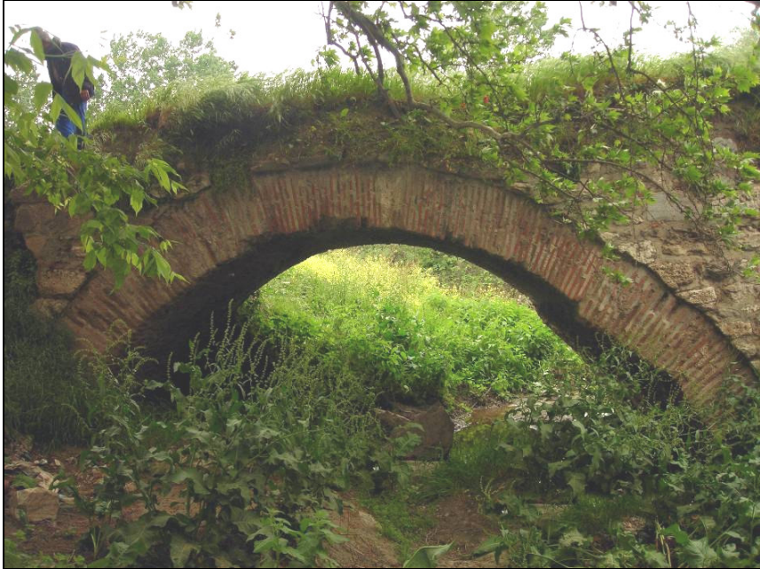
Foto.50: Nilüfer Hatun Köprüsü Sonradan Toprak Dolmuş Göz.
