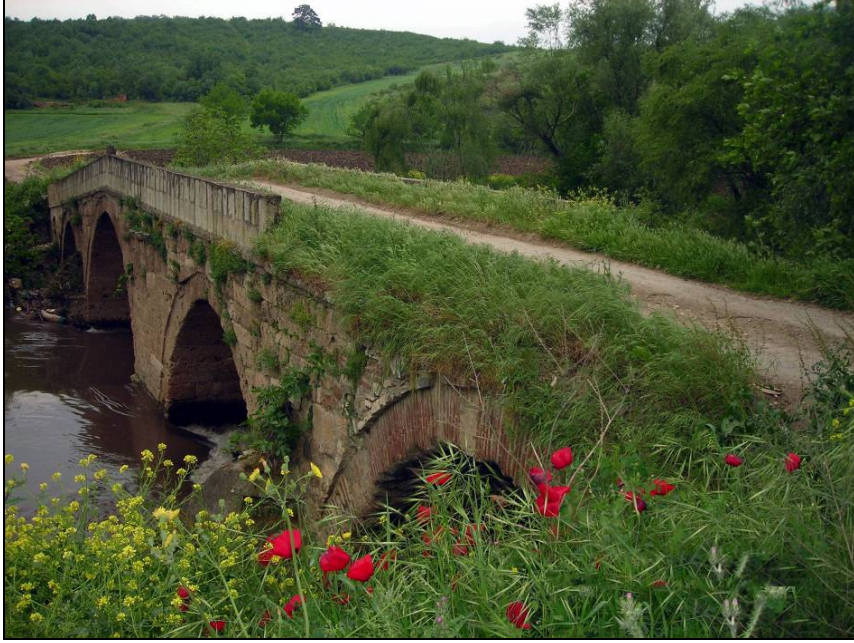
Foto..51: Nilüfer Hatun Köprüsü Gözler ve Tabliye.
