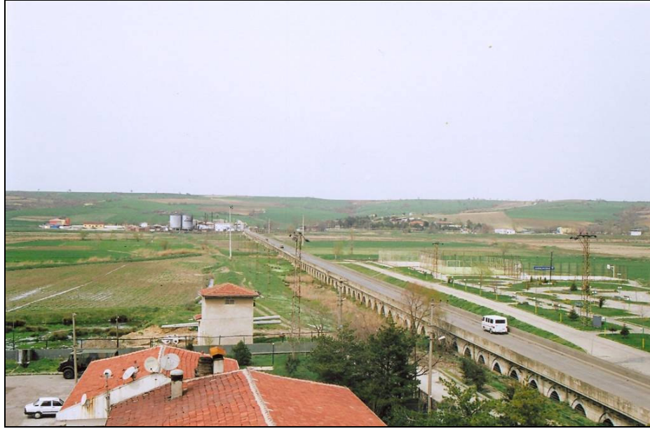
Foto.107: Köprünün genel görünüşü.
