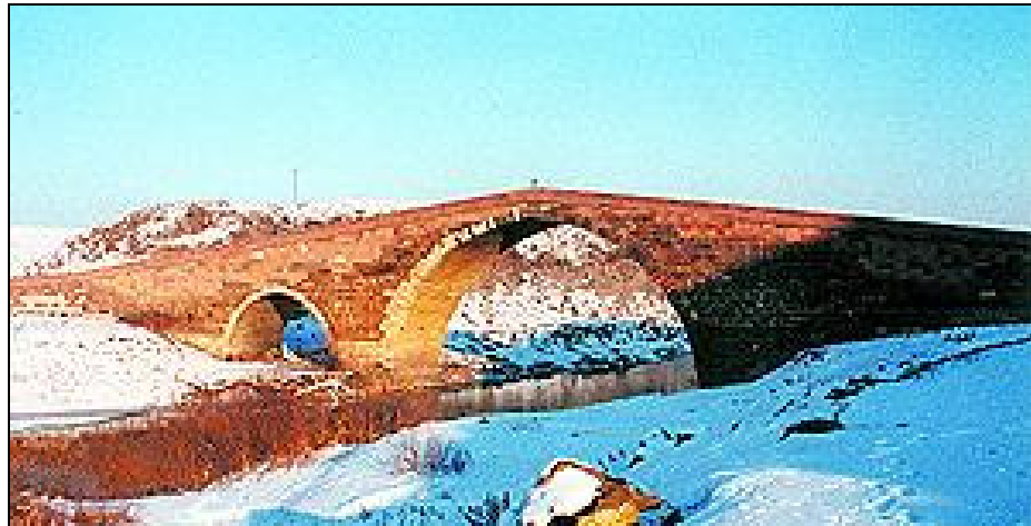
Foto.10: Tekgöz Köprüsü (www.kgm.gov.tr'den)
