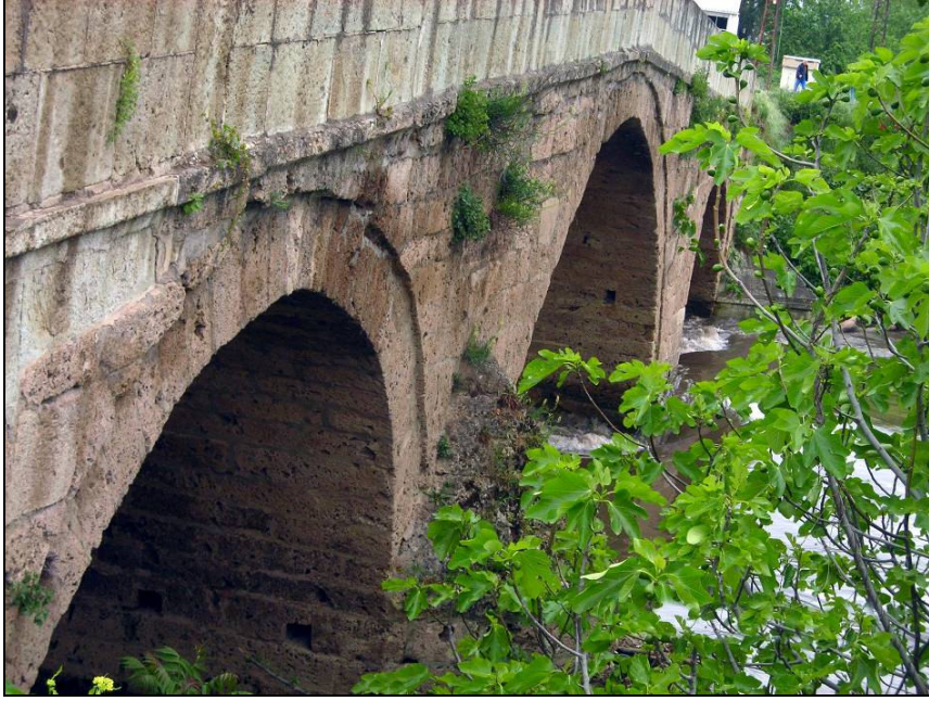
Foto..47: Nilüfer Hatun Köprüsü Mansap Taraf.
