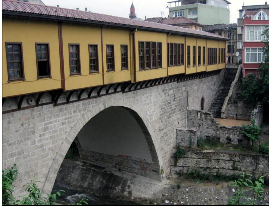
Foto.35: Restorasyondan sonra köprü üzerinde yer alan çarşının görünümü.
