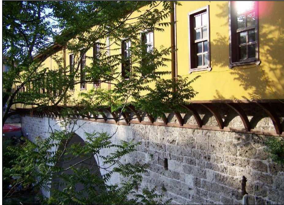
Foto.153: Köprü üzerinde yer alan arasta detayı.
