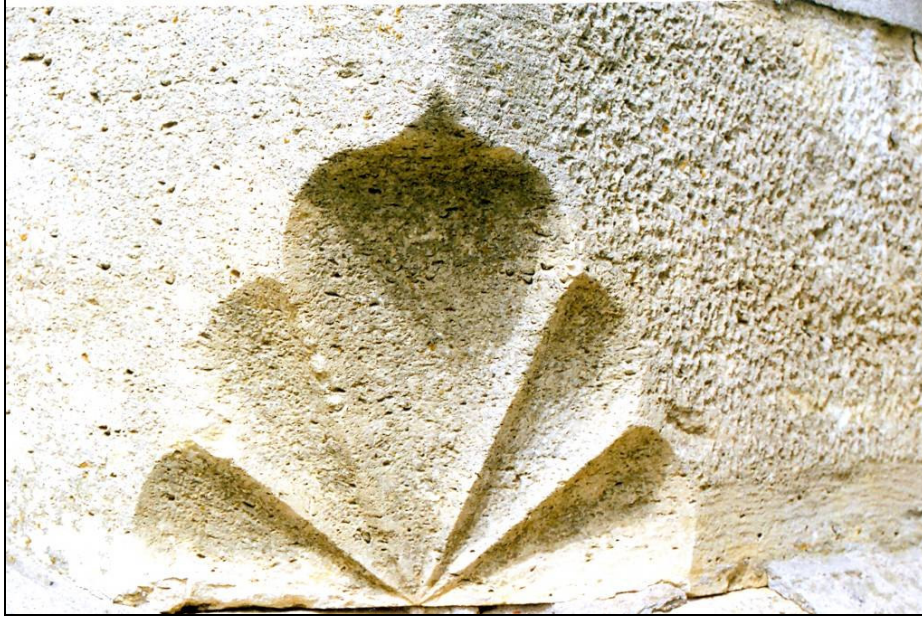
Foto.115: Köprüdeki balkon köşesinden pah detayı.
