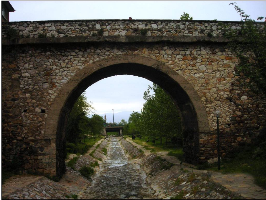
Foto.167: Boyacılluğu Köprüsü memba taraf.
