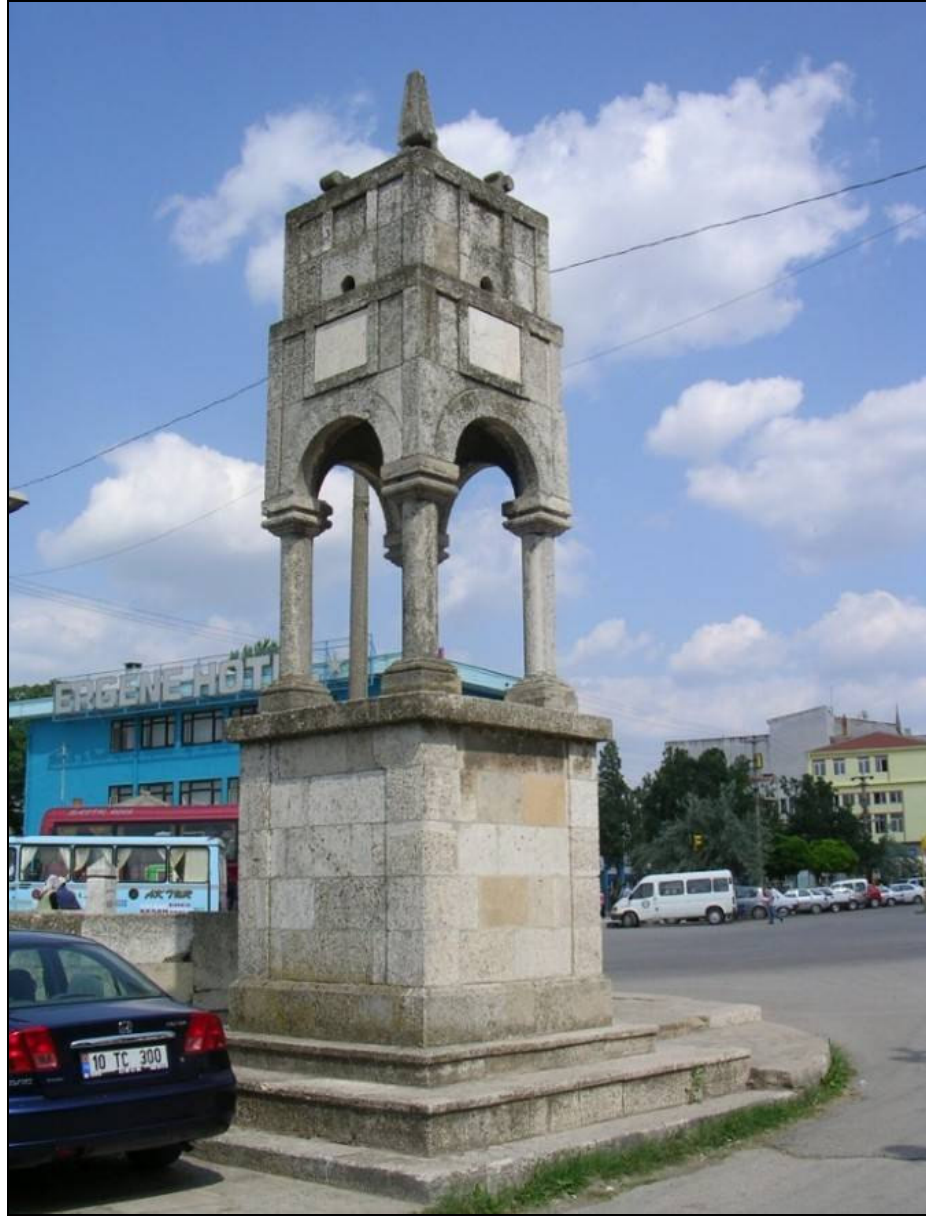
Foto.128: Köprüniin onarımından sonra şehir merkezinde yapılan Meşrutiyet Kulesi.
