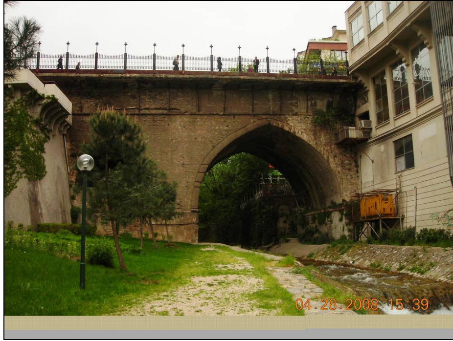
Foto.131: Setbaşı Köprüsü genel görünüş.
