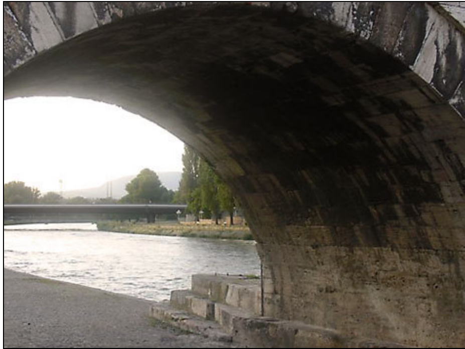
Foto.204: Vardar Fatih Sultan Mehmet Köprüsü ana göz açıklığı.
