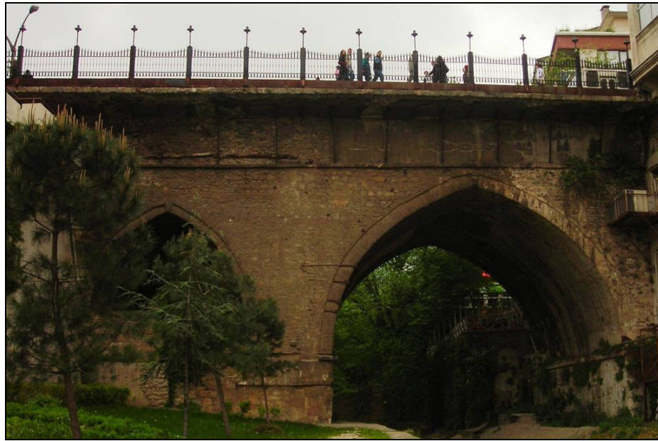
Foto.132: Setbaşı Köprüsü gözler.
