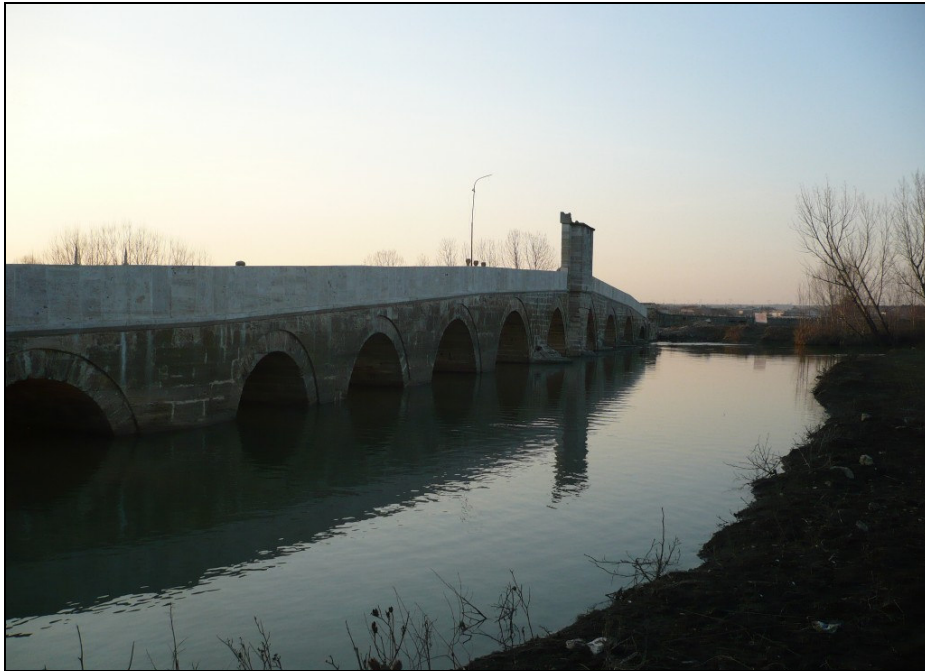
Foto.178: Saraçhane Köprüsü genel görünüşü.
