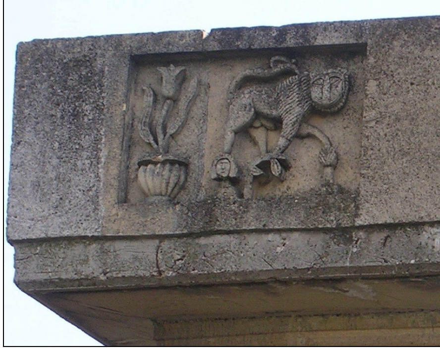
Foto.23 : Üç köşe cumbada yer alan arslan kabartma
