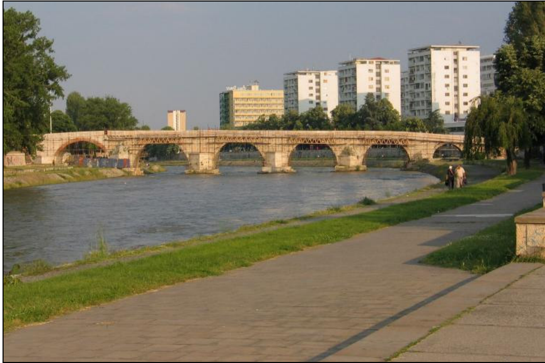
Foto.41: Üsküp Fatih Sultan Mehmet Köprüsü (Restorasyon aşaması)
