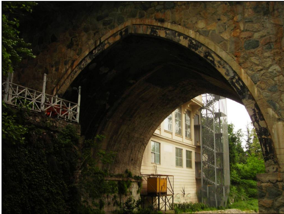
Foto.138: Setbaşı Köprüsü ana göz mansap tarafı.
