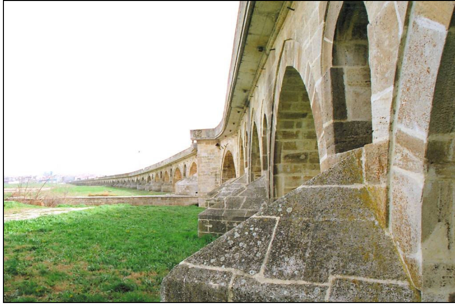
Foto.109: Köprü, ana gözün bulunduğu yerde kıvrım yapar.
