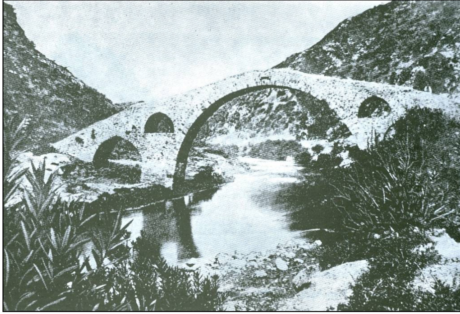
Foto.212: Yenişehir (Teselya-Yunanistan) Tempe Vadisi Köprüsü (Çulpan'dan).
