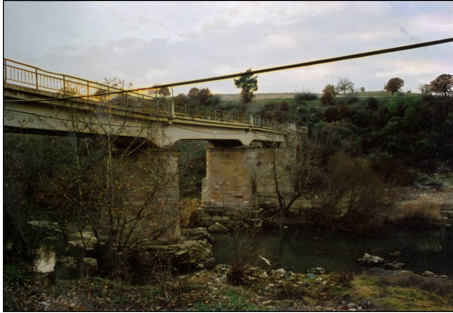
Foto.81: Asilhan Bey Köprüsü Taşıyıcı Ayaklar.
