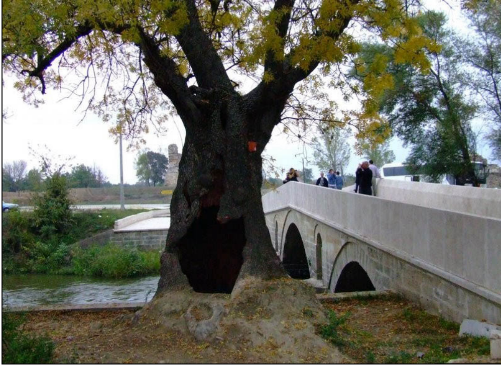
Foto.40 : Fatih Sultan Mehmet Han Köprüsü Adalet Kasrı tarafından bakış.
