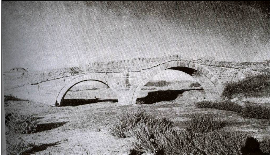
Foto.71: Bergama Koyun Köprüsü (Çulpan'dan).
