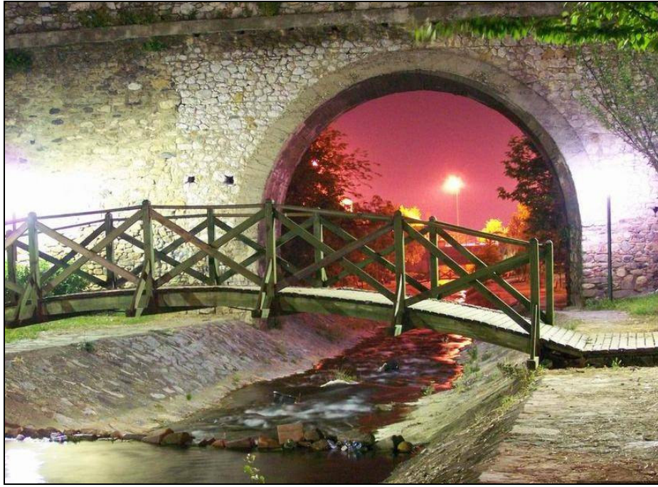
Foto.177: Boyacıkulluğu Köprüsü gece görünüşü.
