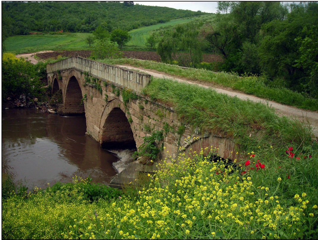
Foto.13 : Nilüfer Hatun Köprüsü Genel Görünüř.
