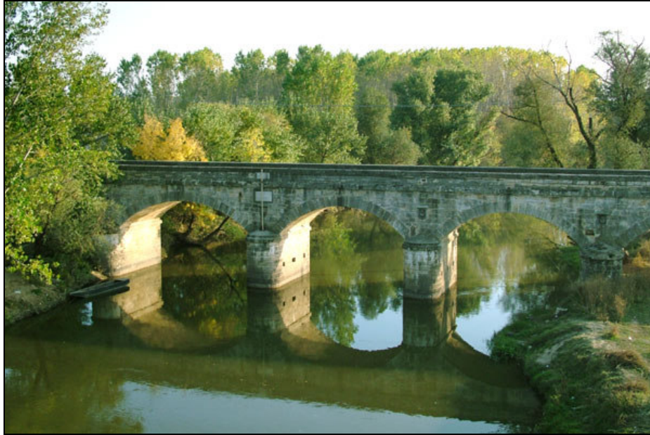
Foto.58: Gazi Mihal Köprüsü Esas Su Yatağı Üzerindeki Gözler
