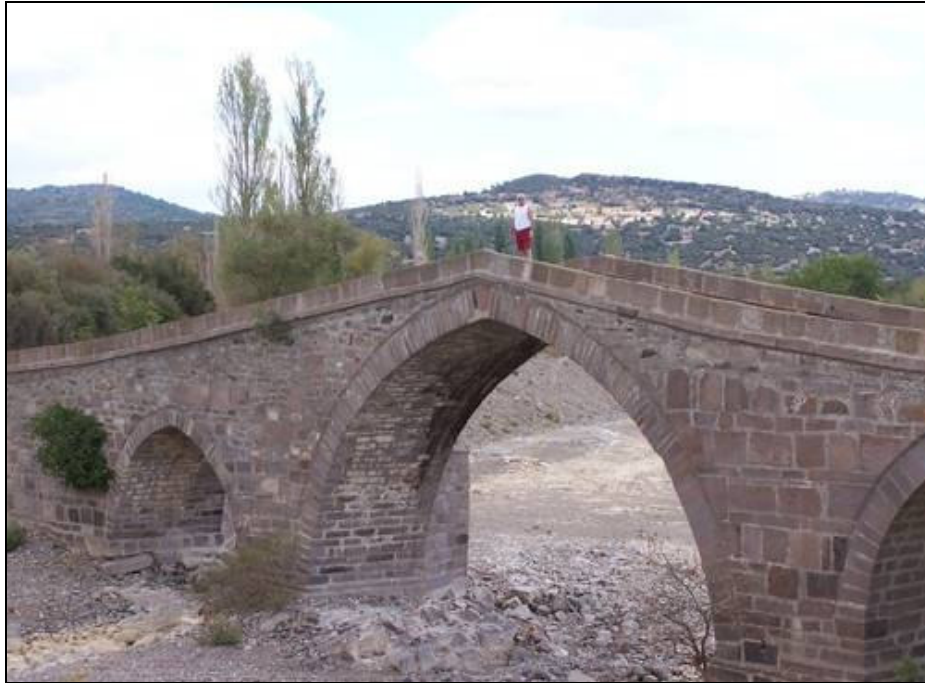
Foto.76: Behramkale Köprüsü Ana Göz.
