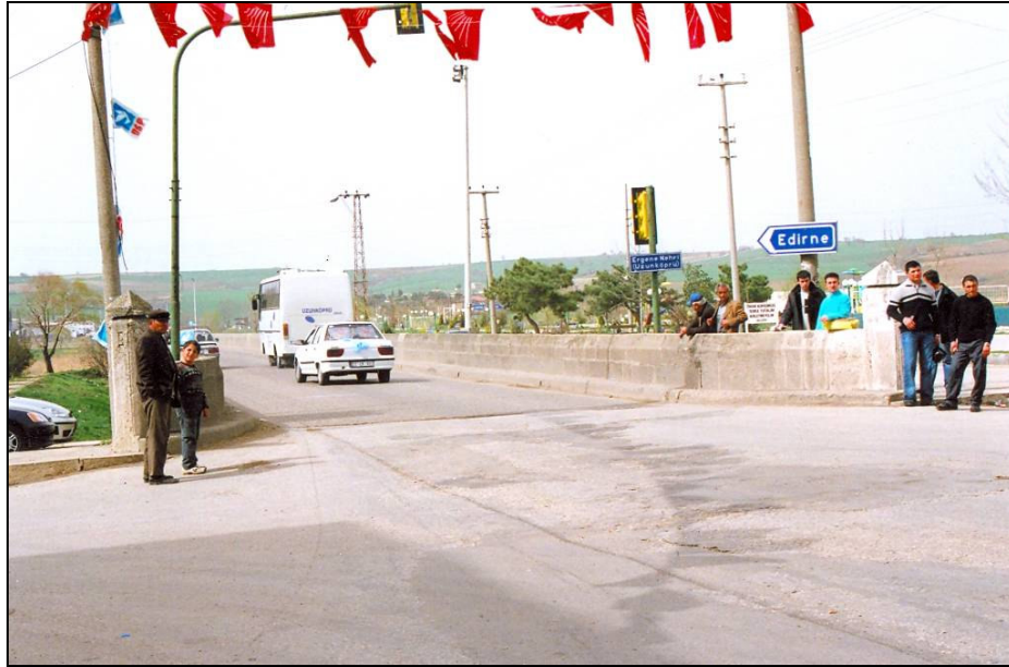
Foto.105: Kent tarafından köprüünün girişi.
