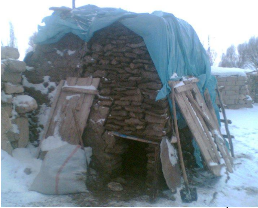
Resim 70: Bu Tezekler Bırakılan Küçük Bir Kapıdan Kelağın İçi Boşalınca Kadar Kullanılır Sonra Dış Duvarlar İçeride Doğru Yıkılır ve Üstü Naylonla Örtülerek veya İçeri Taşınarak Kullanılır
