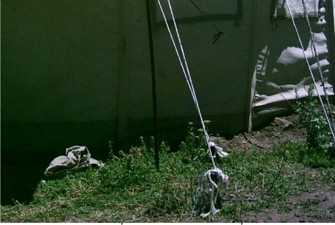
Resim 48: Yağmur sularının İçeri Girmesini Engellemek İçin Çadırın Eteklerine Toprak Dökülür
