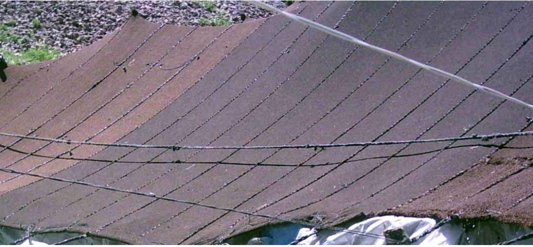
Resim 38: Paralar Halinde Dokunan Kara adır (Kon), Bu Paraları Birbirine Dikilmesiyle Meydana Gelir
