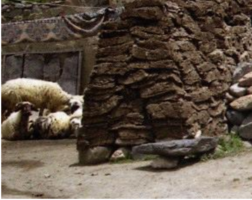
Resim 68: Bu Tezeklerini Altına Tek Sıra Taş Döşendikten Sonra, Çift Yüzlü Duvar Şeklinde Örülür
