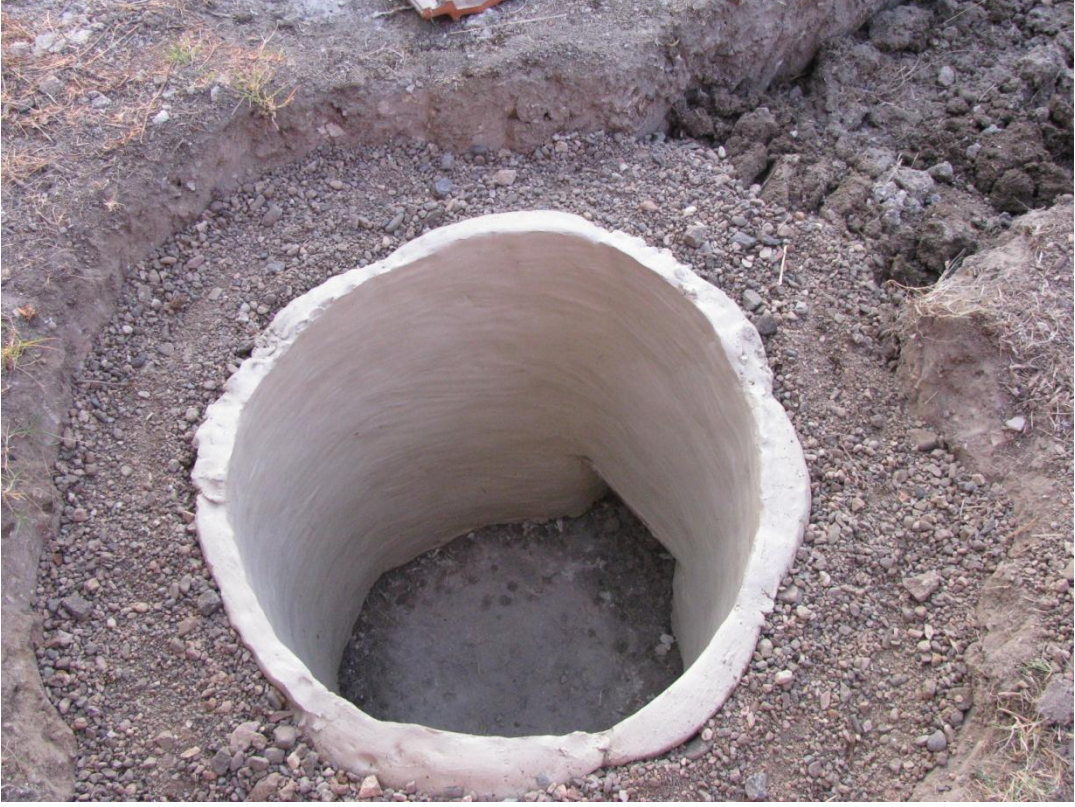
Resim 106: Tandırın Toprak Arasına Çakıl Doldurulur.
