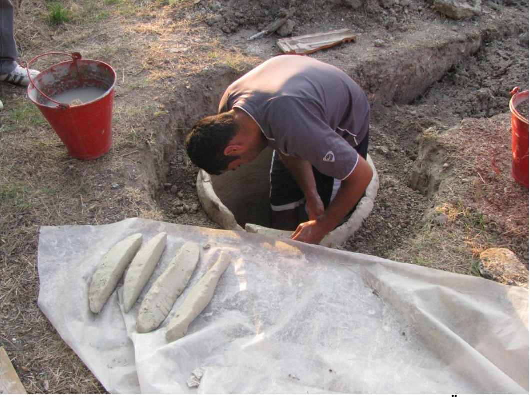
Resim 104: Şekillendirilen Kil Kalıplar Yuvarlak Bir Şekilde Örülür.
