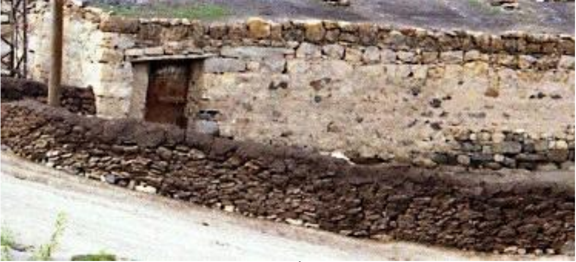
Resim 66: Hayvan Gübresi İle Yapılan Duvar Çeşidi
