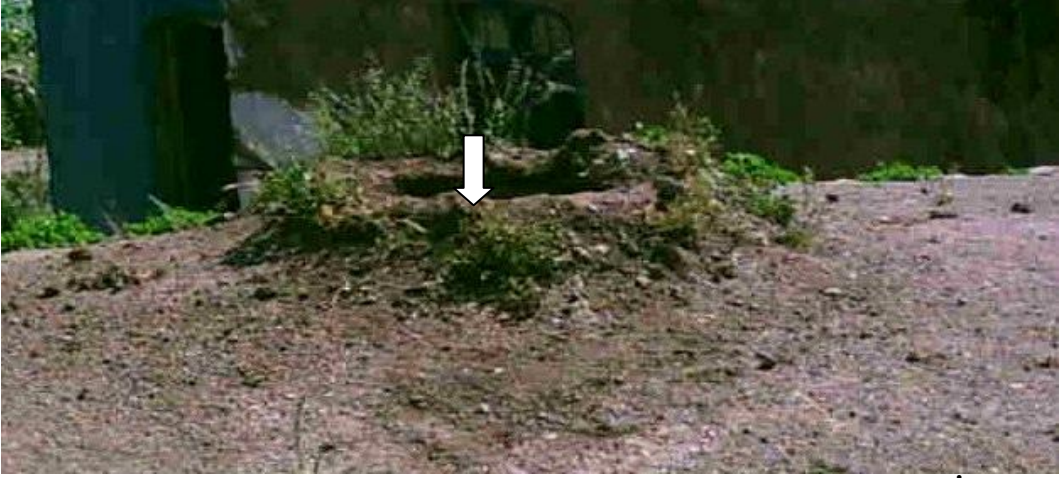
Resim 65: Çimlerle Ahırlardaki Havalandırma Deliklerinin Etrafı da İçeri Su Girmesini Önlemek İçin Tek Sıra Duvar Örülmektedir
