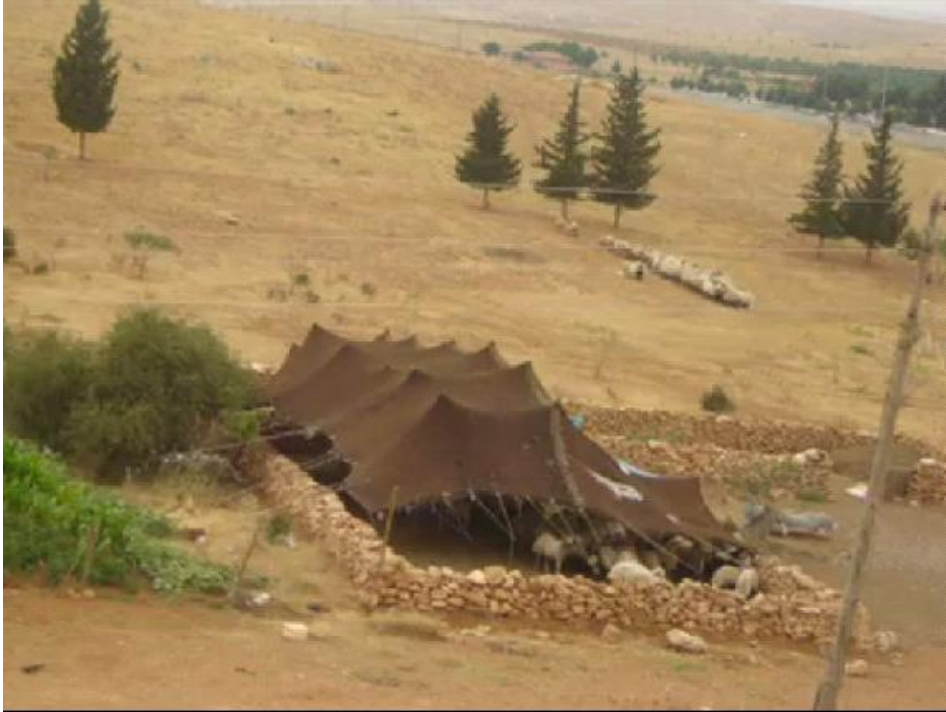
Resim 57: Asıl Yaylada Kara Çadırların Etrafına Genelde Çift Sıra Taşla Harçsız Duvar Örüldür
