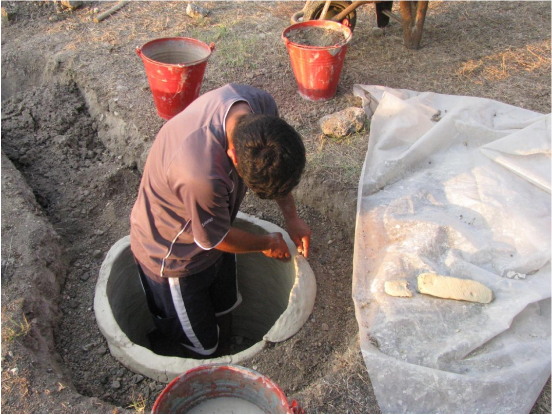
Resim 105: Kil Kalıplar Sıvazlanarak Aralarındaki Ekler Yok Edilir.
