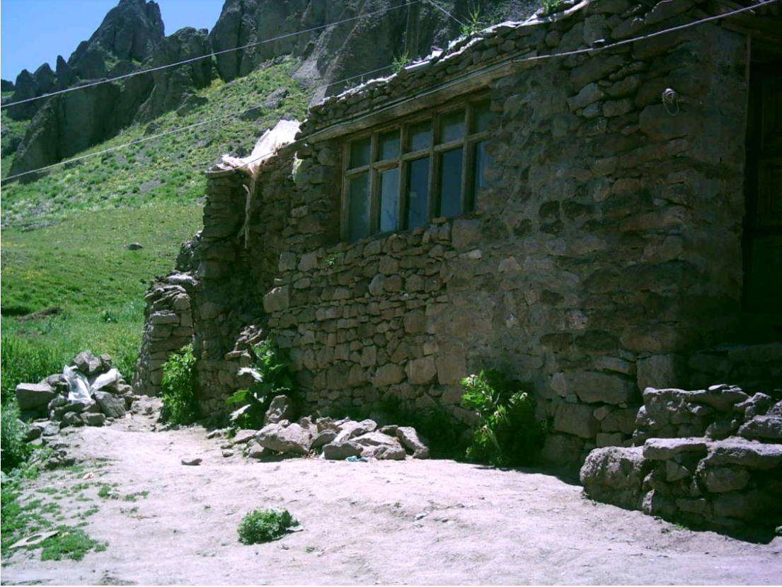
Resim 73: Komlarda Yapılan Evlerin Duvarları Köydekilerle Aynıdır
