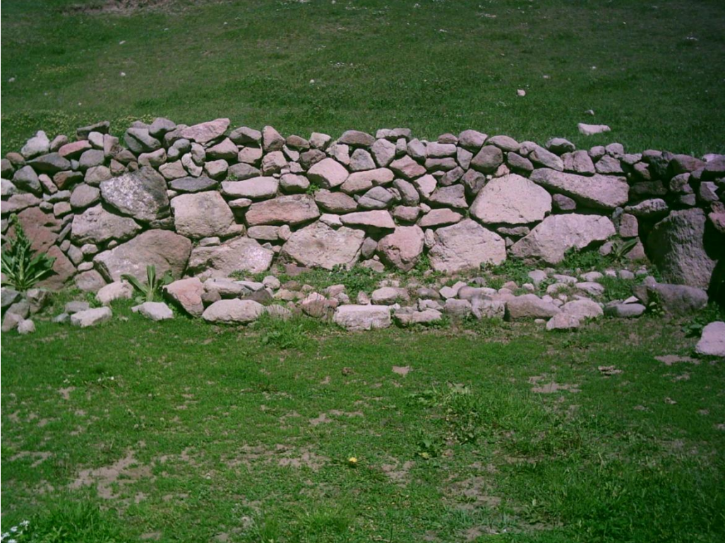
Resim 59: Kara adırın Etrafına Örülen Duvarlarda Taşlar Genelde Harsız ve Yatay Konulur ve İ İe Geçer
