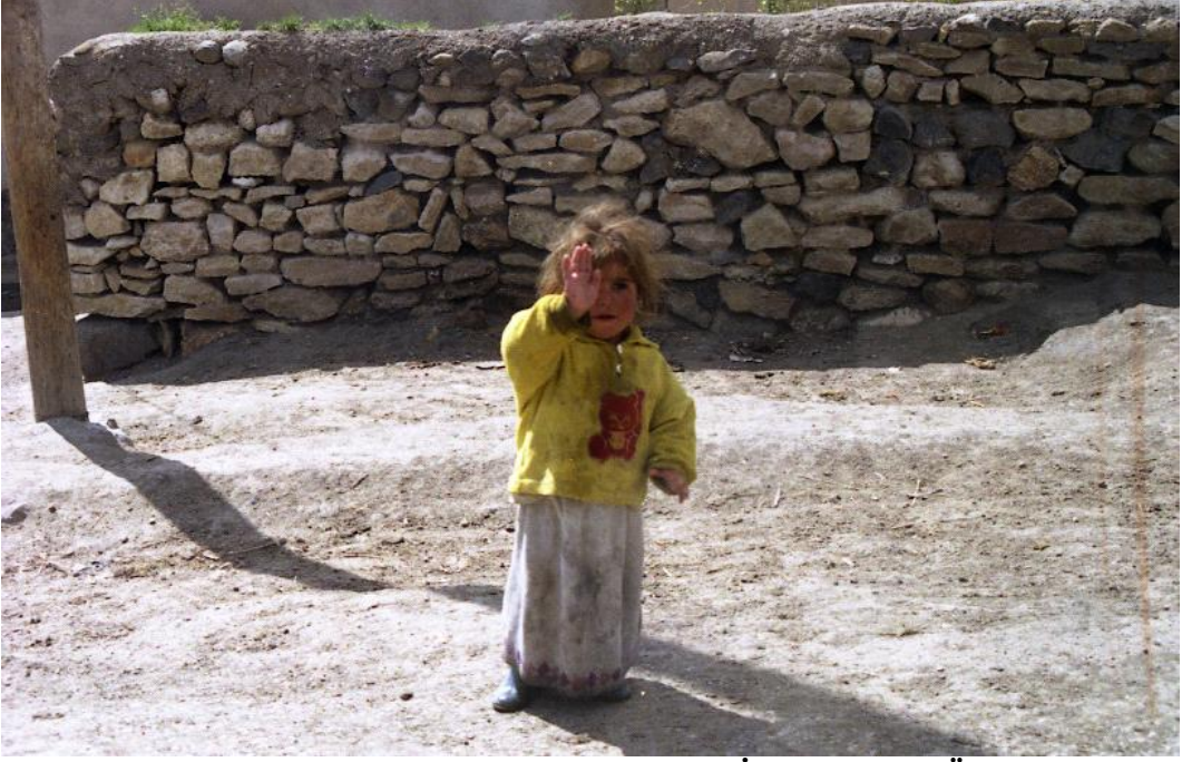
Resim 64: Taş Duvarların Yıkılmasını Geciktirmek İçin Taşlarla Örülen Duvarların Üstüne de Bir veya İki Sıra Çim Konulabilir
