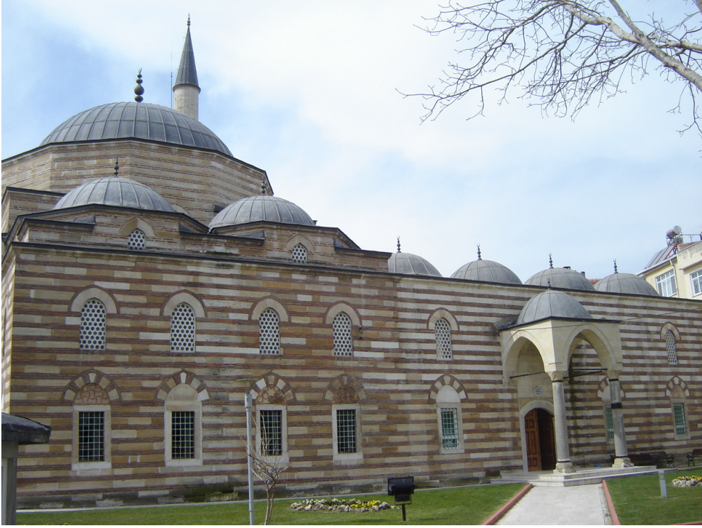
Resim 255 : Güzelce Hasan Bey Camii Doğu Cephe.
