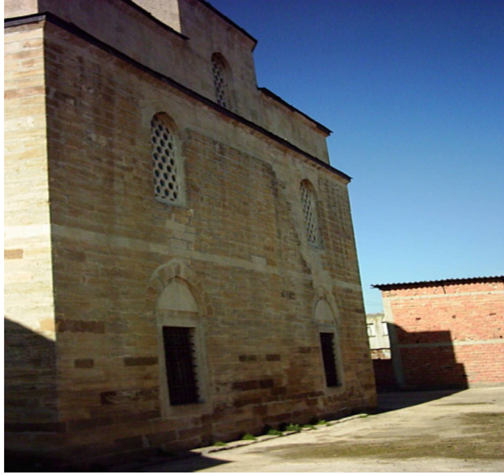
Resim 163: Hüseyin Bey Camii Güney Cephesi.
