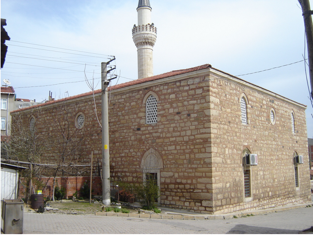
Resim 235 : Çelebi Sultan Mehmet Camii Batı ve Güney Cephesi.
