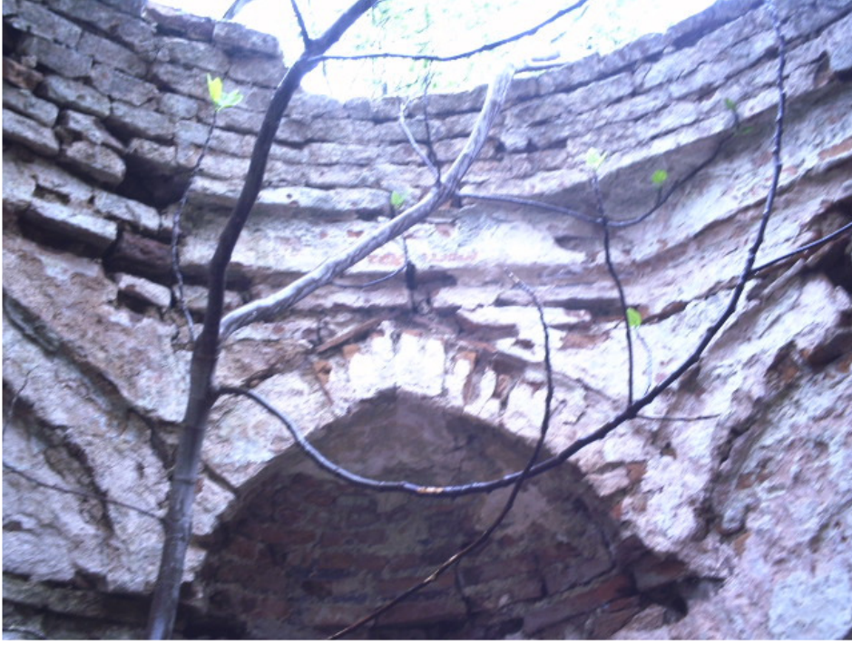
Resim 313: Güzelköy Konak Hamamı Sıcaklık Kısmı Üst Örtü.
