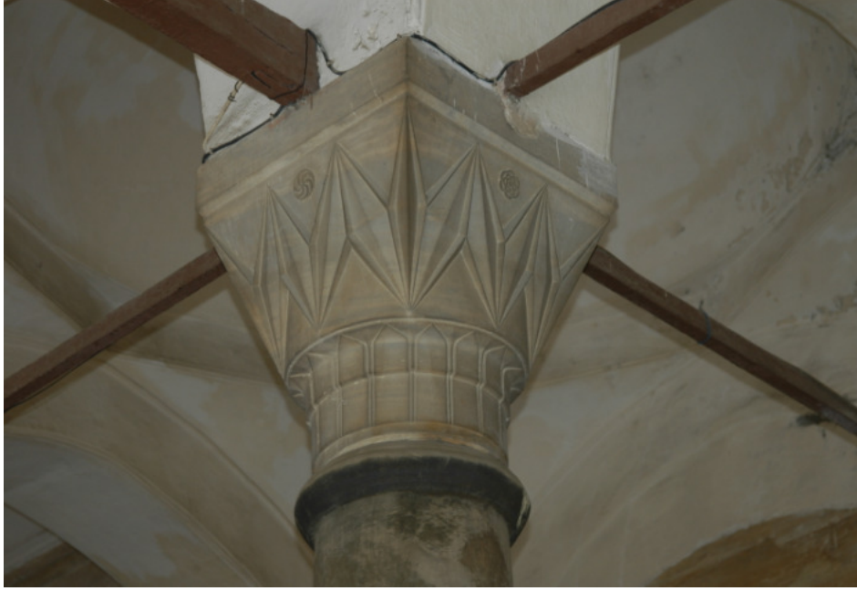
Resim 72: Rüstem Paşa Camii İç Revaklardaki Sütun Başlığı
