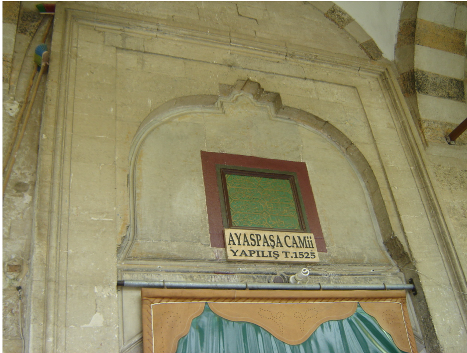
Resim 36: Ayas Paşa Camii Taç Kapı Kemer
