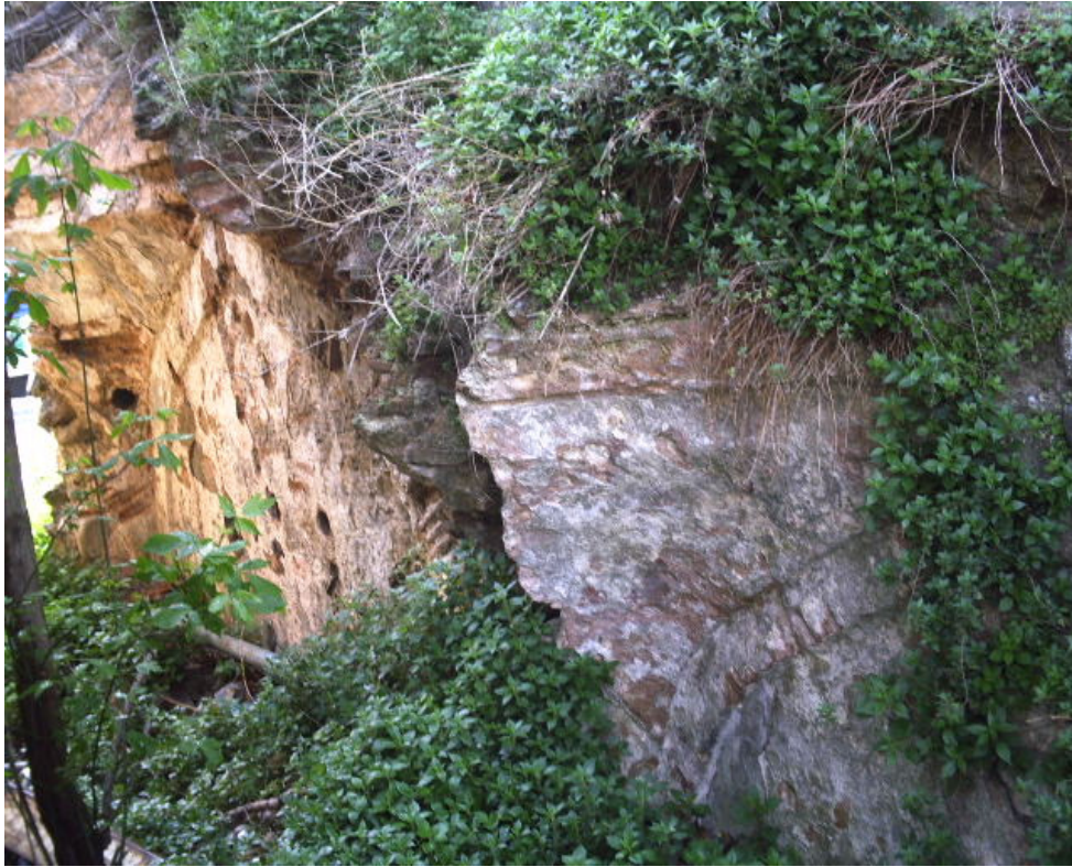
Resim 334 : Mürefte Konak Hamamı Güney Duvarı.
