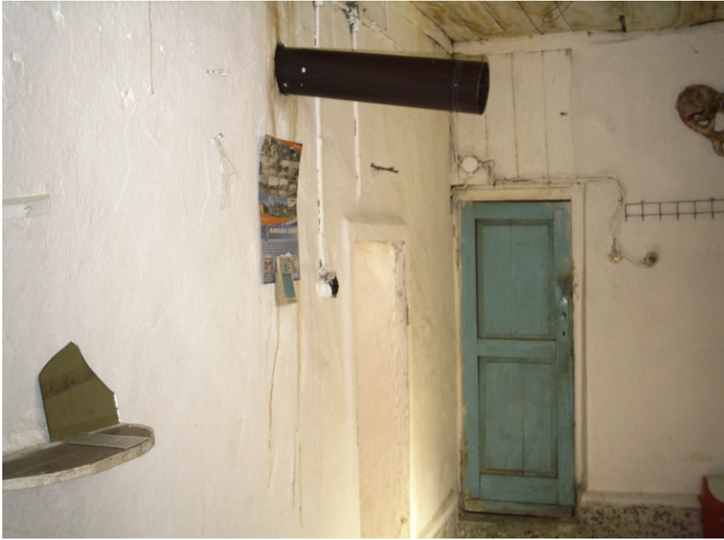
Resim 194 : Umur Bey Hamamı Soyunmalık Kısmı İçten Görünüş.
