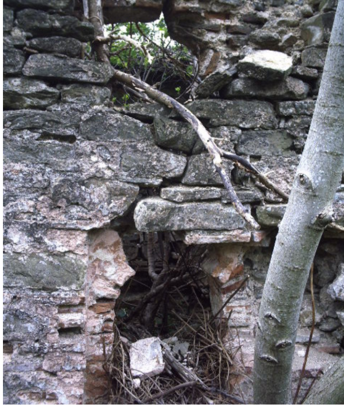
Resim 294 : Güzelköy Konak Hamamı Kuzey Cephe Girişi.
