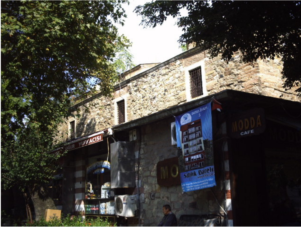
Resim 97: Rüstem Paşa Bedesteni Batı Cephesi.
