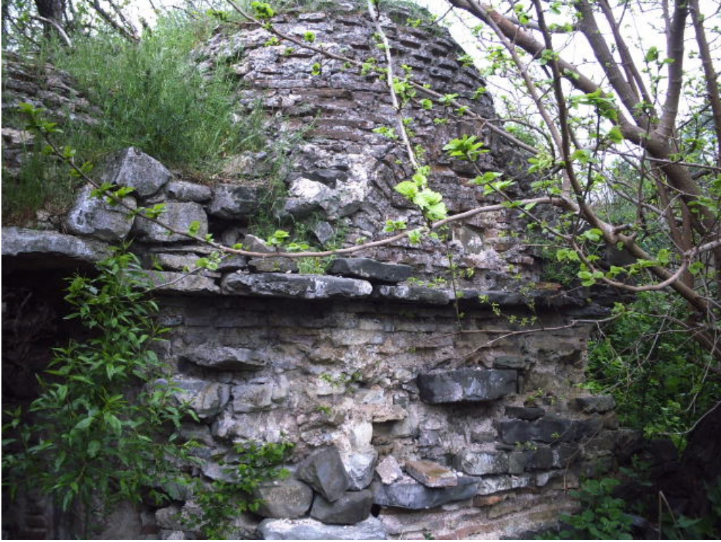
Resim 293 : Güzelköy Konak Hamamı Kuzey Cephe Görünüşü.
