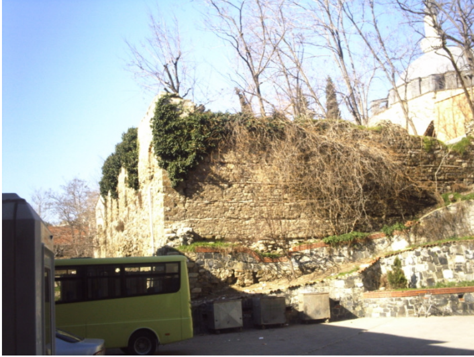
Resim 108 : Rüstem Paşa Medresesi Güney Duvarı.
