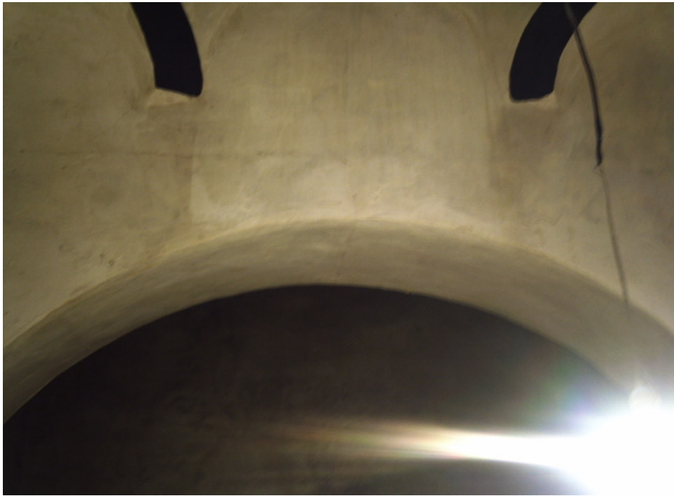
Resim 354: Şarköy Hamamı Ilıklık Mekanı Eyvanı .
