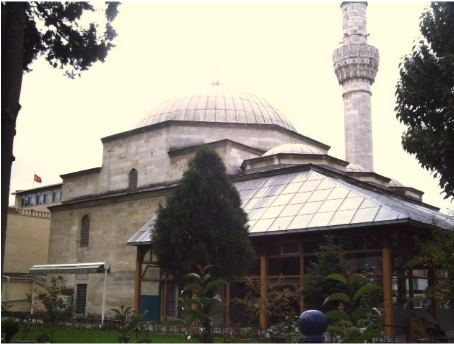
Resim 119: Süleymaniye Camii Kuzey ve Doğu Cephe.
