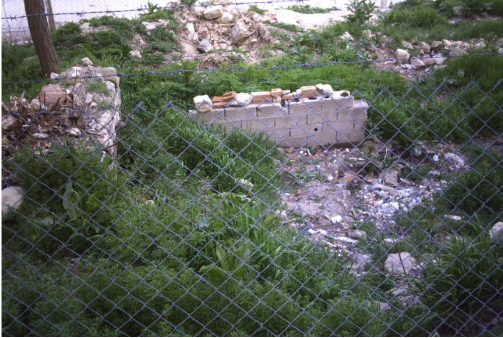
Resim 318 : Malkara Hamamı Soyunmalık Kısmı Kuzey doğudaki Kare Mekan ve Giriş.
