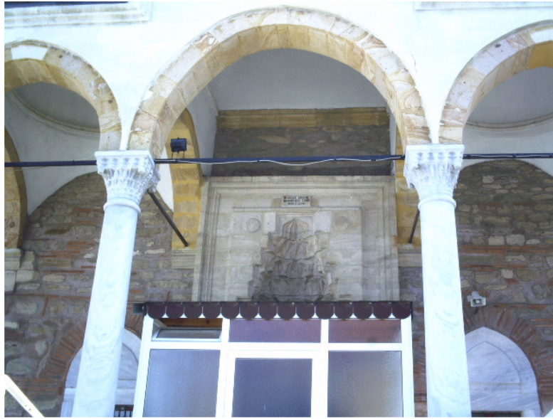
Resim 278 : Hacerzade İbrahim Bey Camii Kuzey Cephesi.
