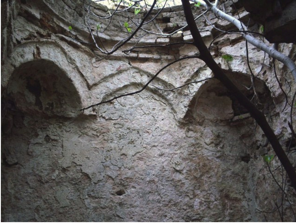
Resim 314 : Güzelköy Konak Hamamı Sıcaklık Kısmı Üst Örtü.
