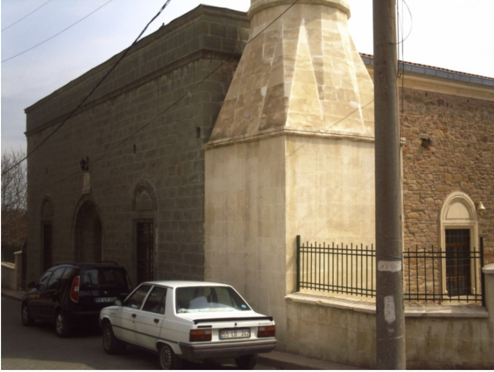
Resim 11: Gazi Süleyman Paşa Camii Kuzey ve Batı Cephe
