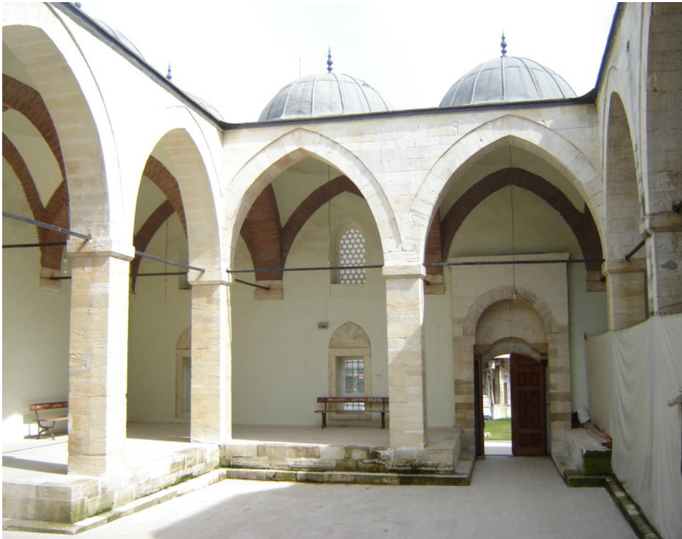
Resim 250 : Güzelce Hasan Bey Camii Avlu.
