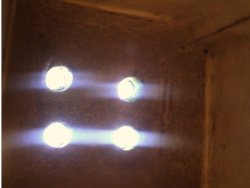
Resim 348: Şarköy Hamamı Wc Üst Örtüsü.
