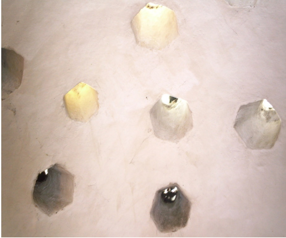
Resim 199 : Umur Bey Hamamı Sıcaklık Mekanı Kubbesi.
