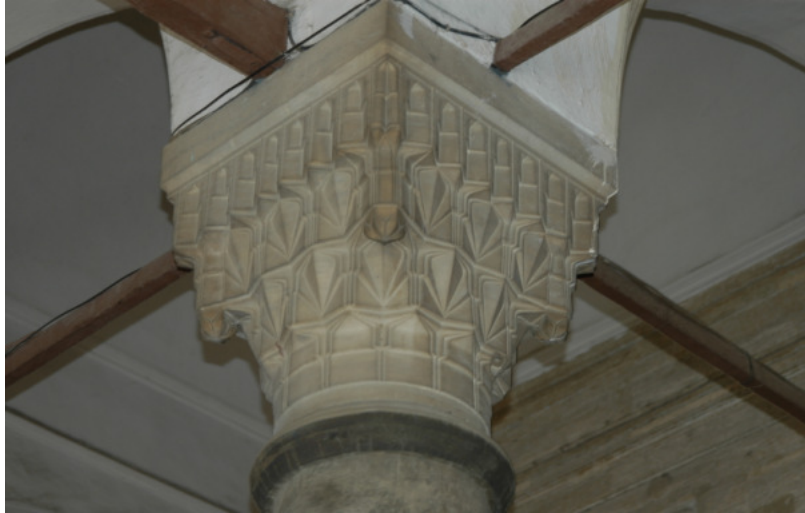
Resim 71: Rüstem Paşa Camii İç Revaklardaki Sütun Başlığı
