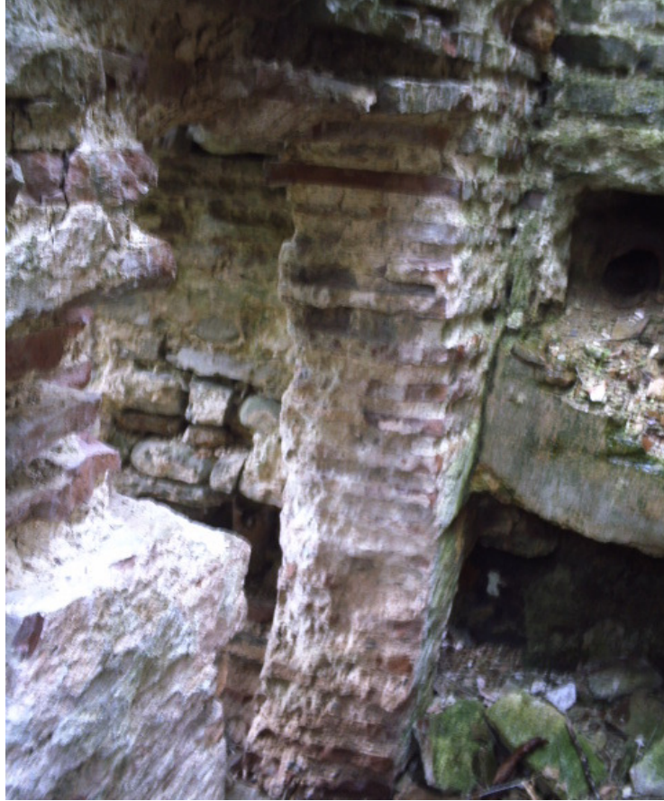
Resim 302 : Güzelköy Konak Hamamı Usturalık Girişi (Koridorun Sağ Tarafı).
