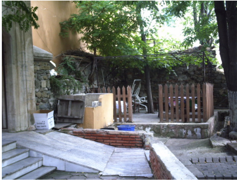
Resim 113: Rüstem Paşa Medresesi Güney ve Batı Duvarı.
