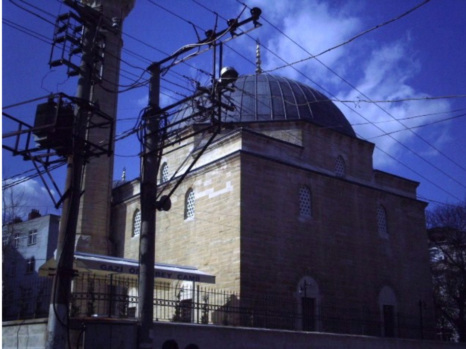
Resim 208 : Gazi Ömer Bey Camii Batı ve Güney Cephesi.
