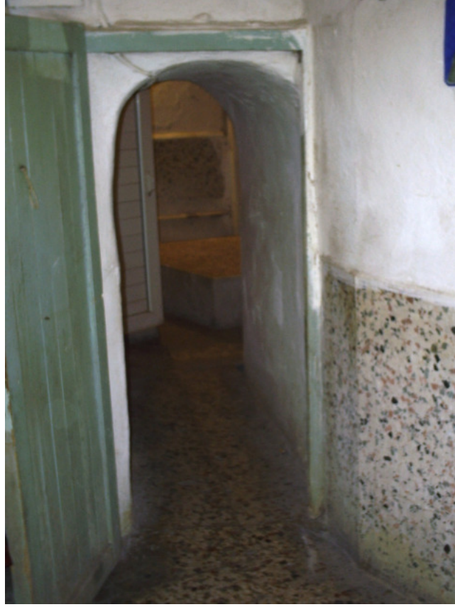
Resim 197 : Umur Bey Hamamı Sıcaklık Mekanı Girişi.
