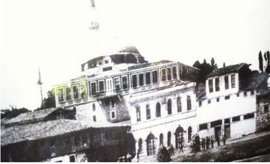
Resim 106 : Rüstem Paşa Medresesi (1883).
