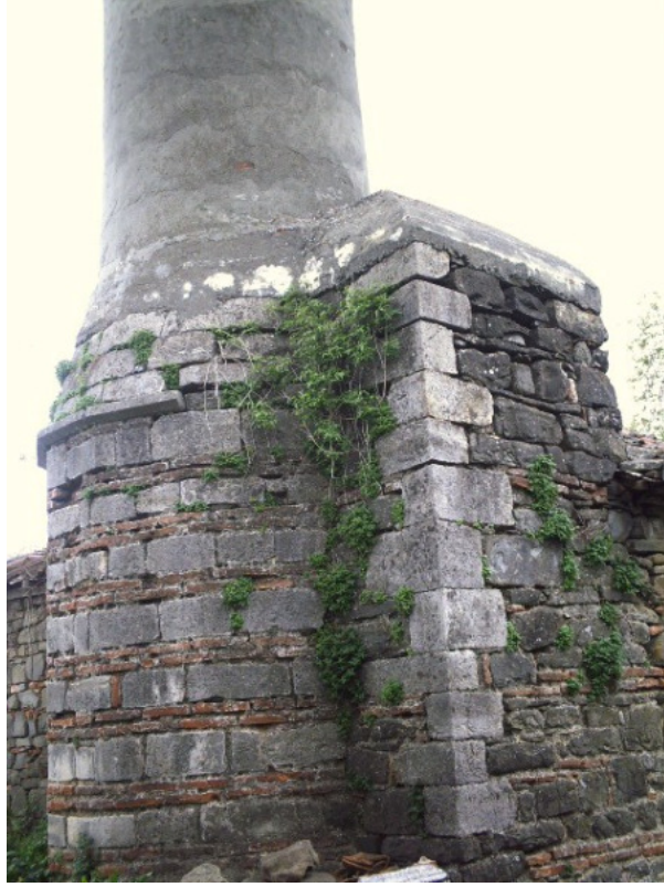
Resim 17: Güzelköy Eski Camii Minare Kaidesi
