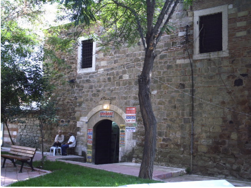
Resim 96 : Rüstem Paşa Bedesteni Kuzey Cephe.
