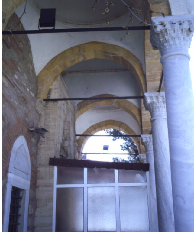
Resim 279 : Hacerzade İbrahim Bey Camii Kuzey Cephesi.
