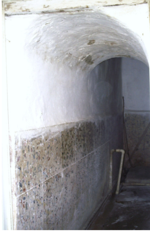
Resim 201 : Umur Bey Hamamı Wc Girişi.
