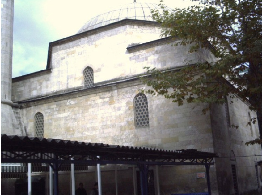
Resim 120: Süleymaniye Camii Batı ve Güney Cephe.
