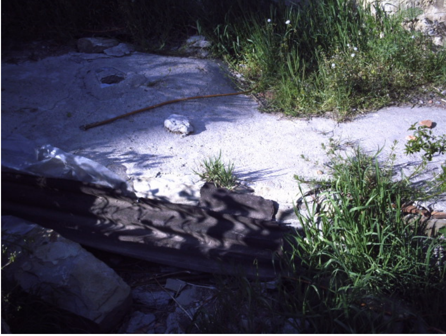
Resim 327: Malkara Hamamı WC kısmı üst örtüsü.
