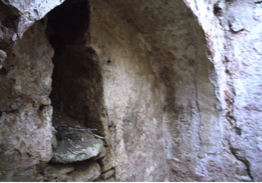
Resim 311: Güzelköy Konak Hamamı Sıcaklık Eyvanı Su Kontrol Penceresi.
