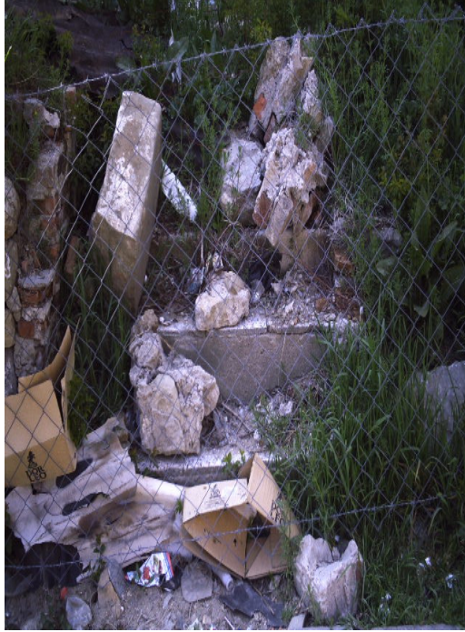
Resim 319 : Malkara Hamamı Soyunmalık Kısım1 Güney Giriş Kapısı.
