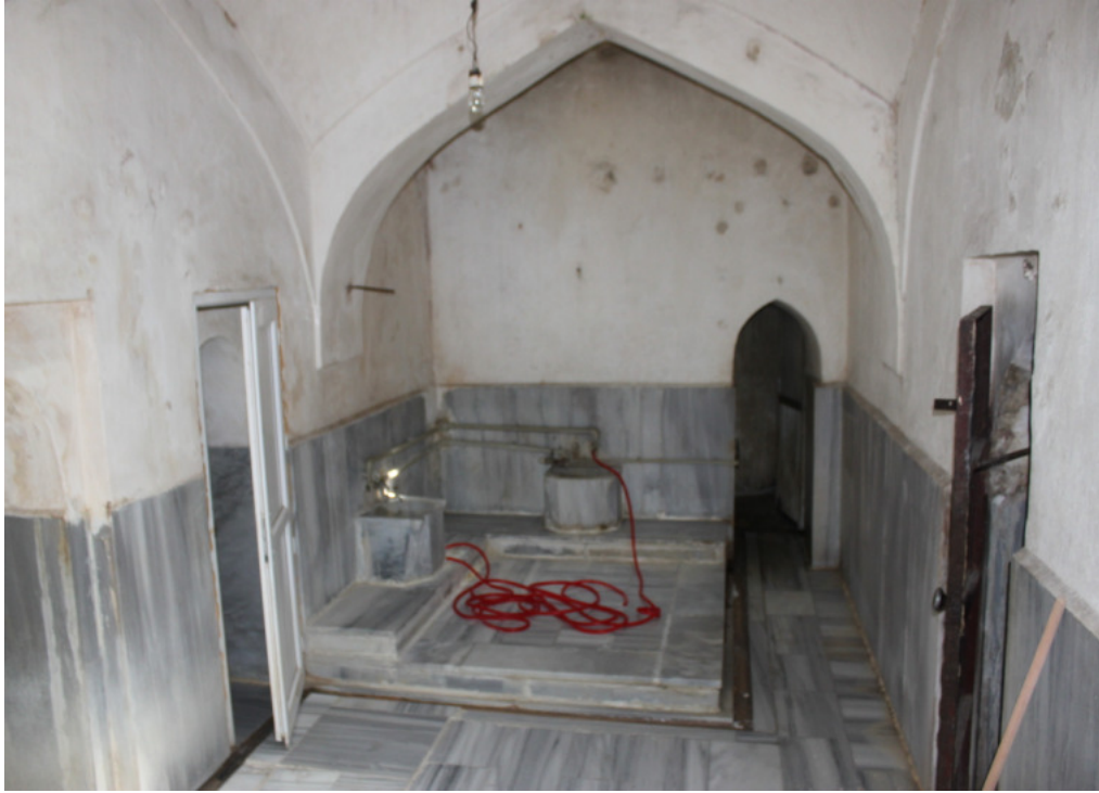
Resim 54: Ayas Paşa Hamamı Ilıklık Mekanı Güney Taraf
