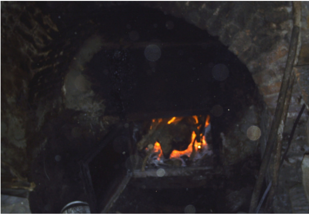
Resim 206 : Umur Bey Hamamı Külhan.
