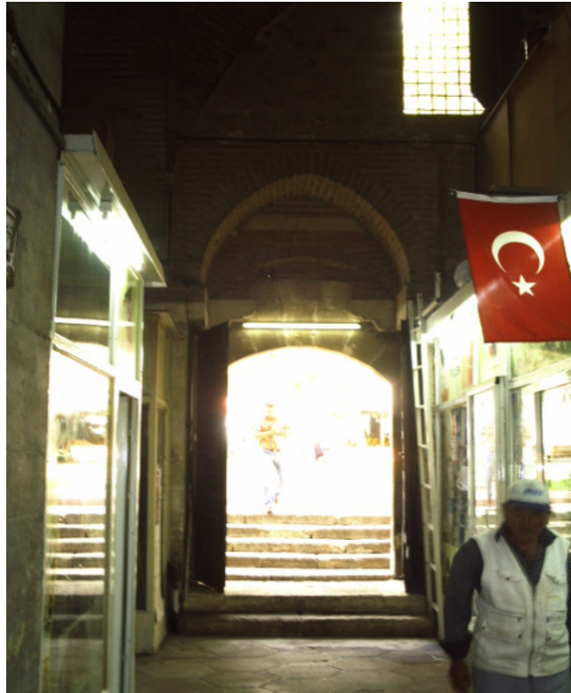
Resim 99 : Rüstem Paşa Bedesteni İçten Kuzey Girişi .
