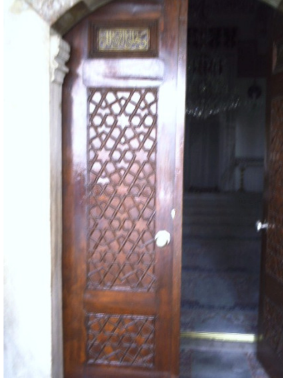
Resim 128: Süleymaniye Camii Harim Giriş Kapısı.
