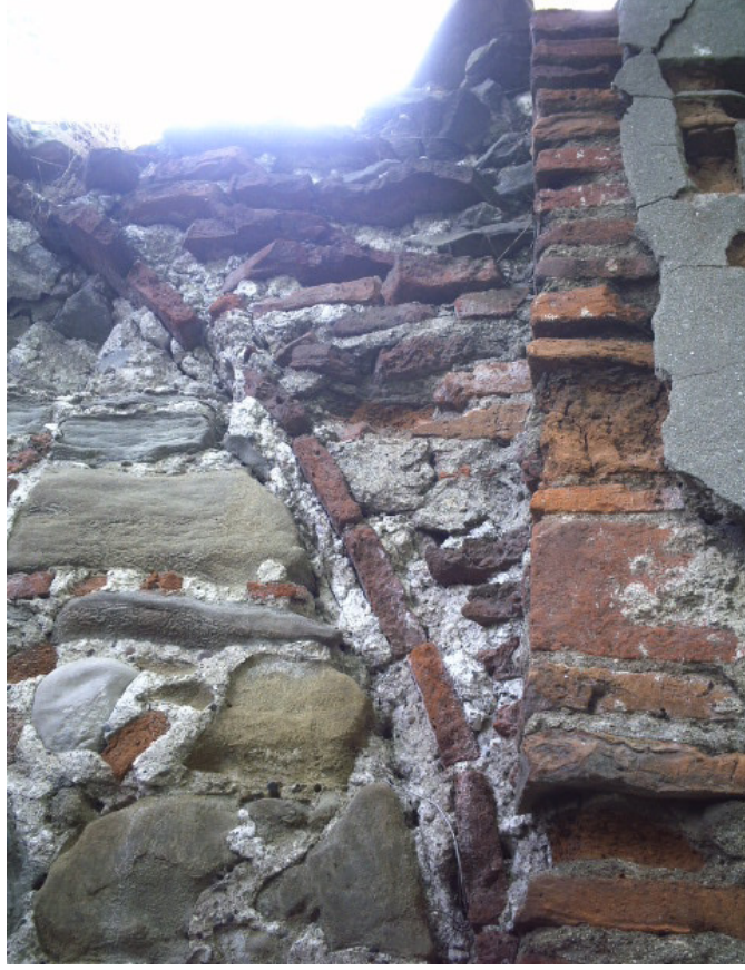
Resim 112: Rüstem Paşa Medresesi Kubbeye Geçiş.
