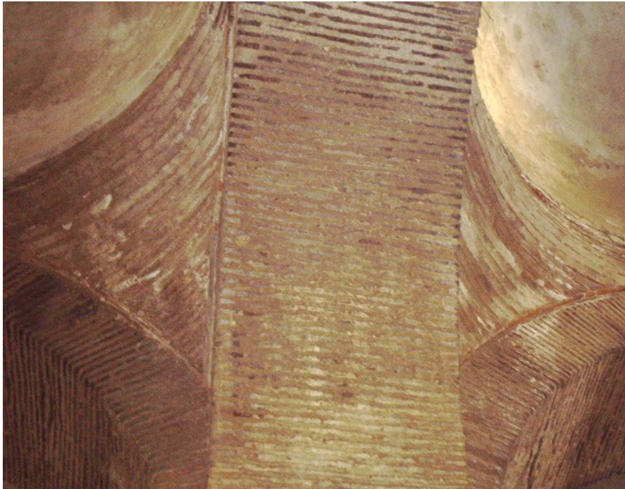
Resim 103 : Rüstem Paşa Bedesteni Kubbeye Geçiş.
