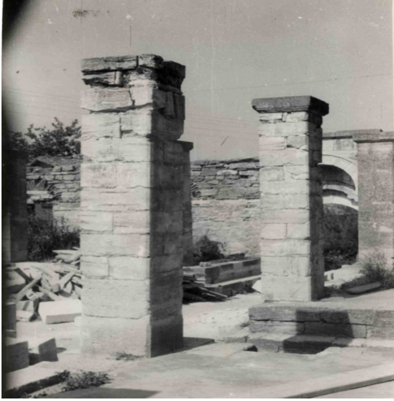
Resim 247 : Güzelce Hasan Bey Camii Onarım Öncesi Avlu (VGMA'dan).
