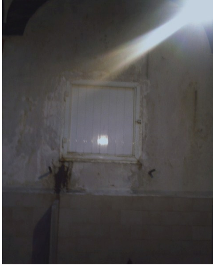
Resim 359 : Şarköy Hamamı Sıcaklık Mekanı Su Kontrol Penceresi.
