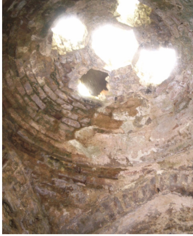
Resim 299 : Güzelköy Konak Hamamı Wc Kubbesi.
