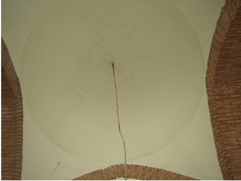
Resim 253: Güzelce Hasan Bey Camii Avlu Kubbeye Geçiş.
