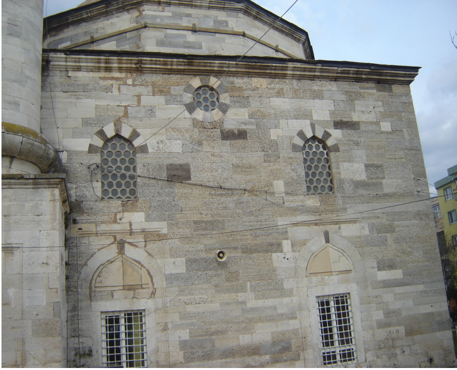
Resim 31: Ayas Paşa Camii Batı Cephesi
