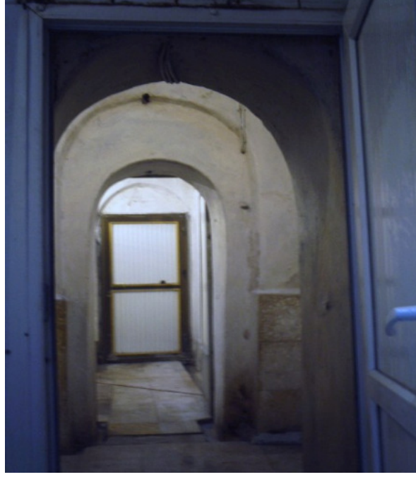
Resim 345 : Şarköy Hamamı Aralık kısmı.
