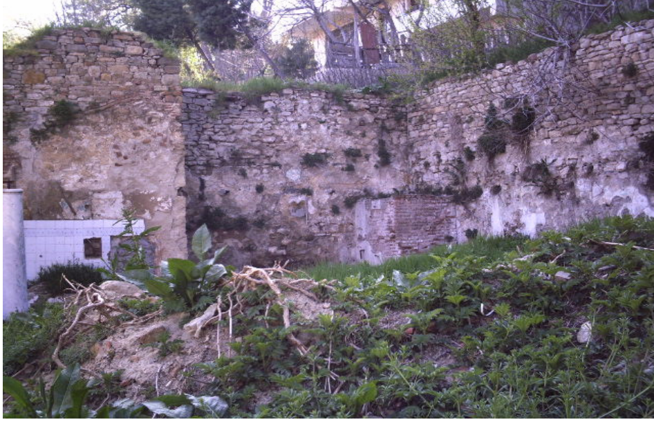
Resim 317 : Malkara Hamamı Soyunmalık Kısmı Kuzey Duvarı .
