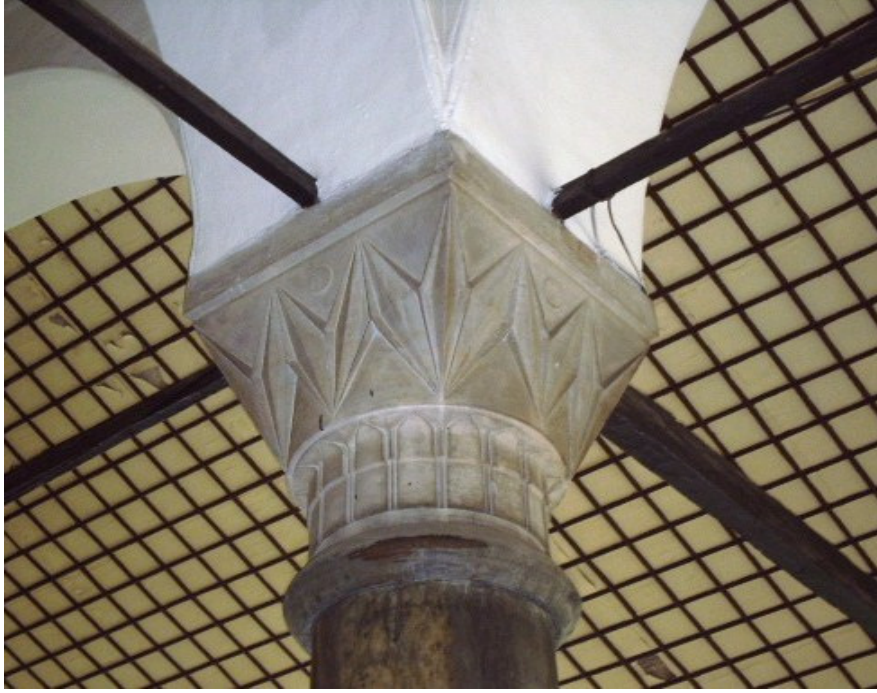
Resim 74: Rüstem Paşa Camii İç Revaklardaki Rozetleri İşlenmemiş Sütun Başlığı
