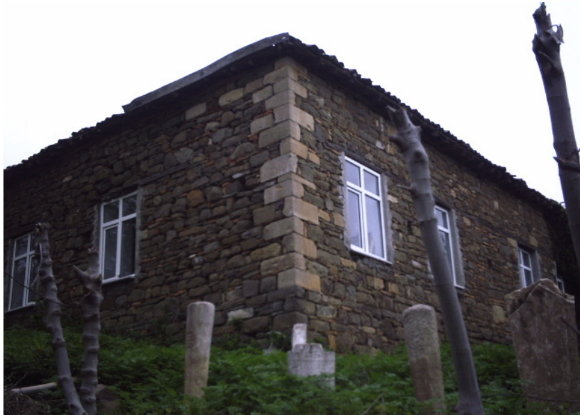
Resim 16: Güzelköy Eski Camii Güney ve Doğu Cephesi
