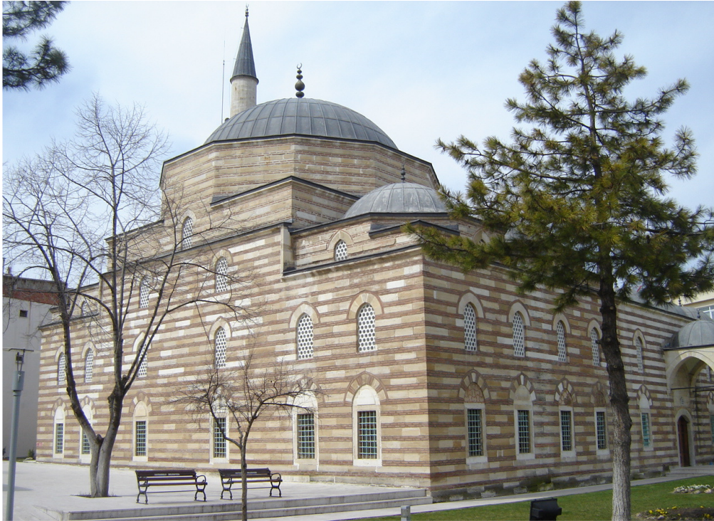
Resim 254 : Güzelce Hasan Bey Camii Güney ve Doğu Cepheler.
