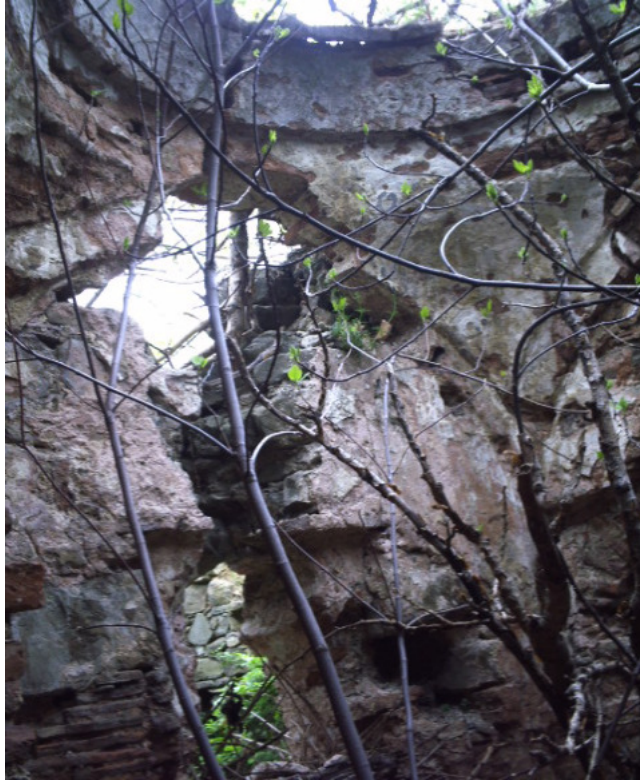
Resim 304 : Güzelköy Konak Hamamı Ilıklık Kısmı İç Mekan.
