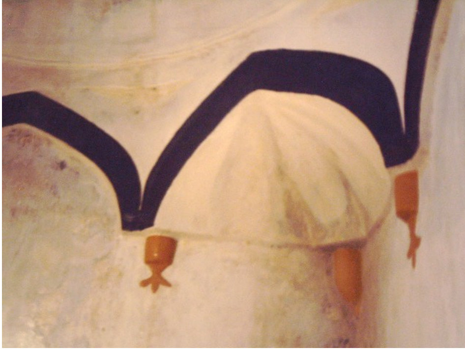
Resim 357: Şarköy Hamamı Sıcaklık Mekanı Kubbeye Geçişler.
