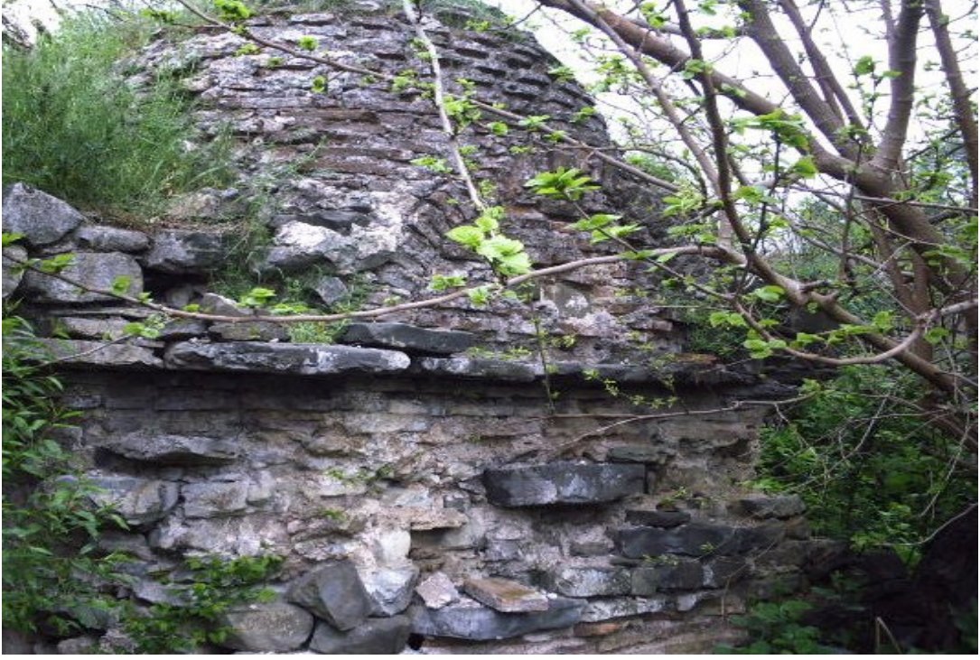
Resim 301 : Güzelköy Konak Hamamı Wc Kubbesi.
