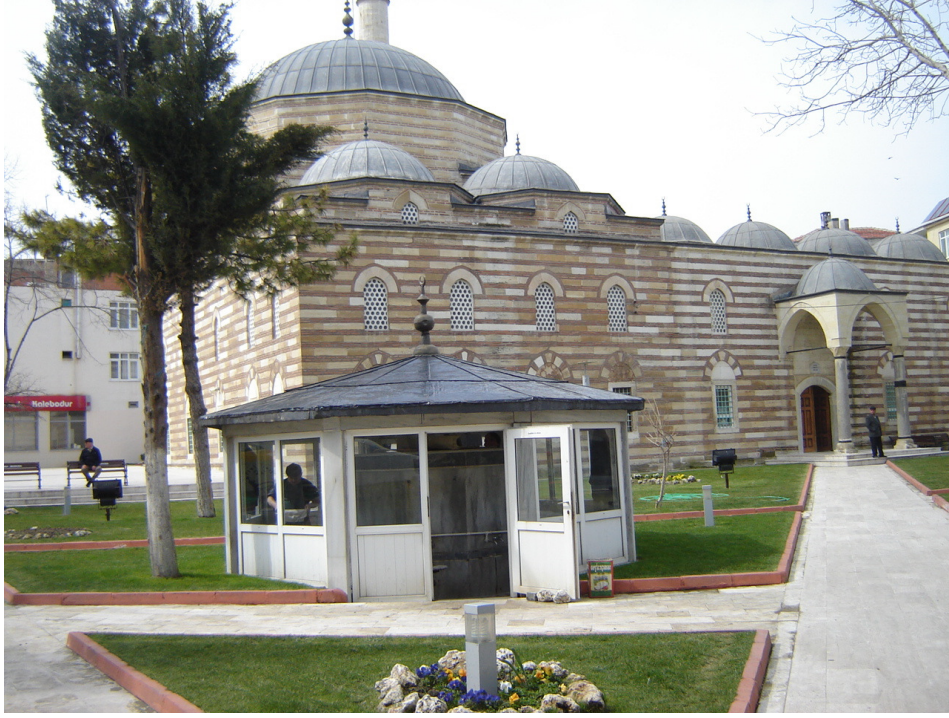
Resim 249 : Güzelce Hasan Bey Camii Doğu Cephe.
