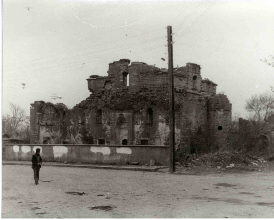
Resim 159 : Hüseyin Bey Camii Onarımdan Önceki Hali(VGMA'dan.).
