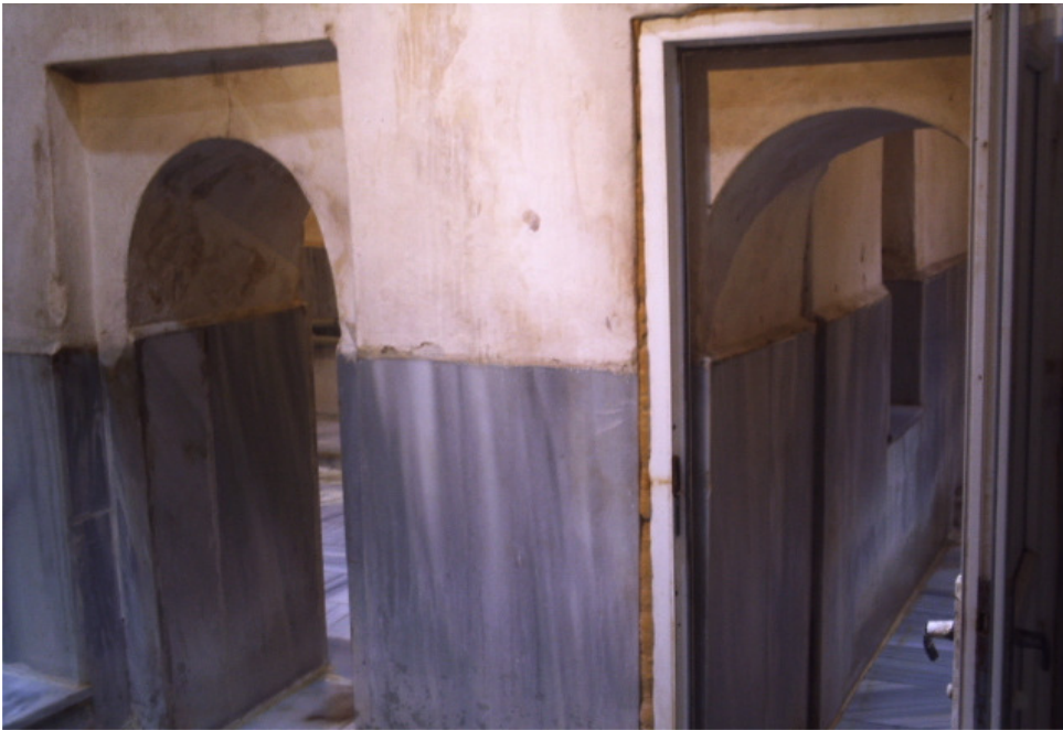
Resim 56: Ayas Paşa Hamamı Sıcaklık Odaları
