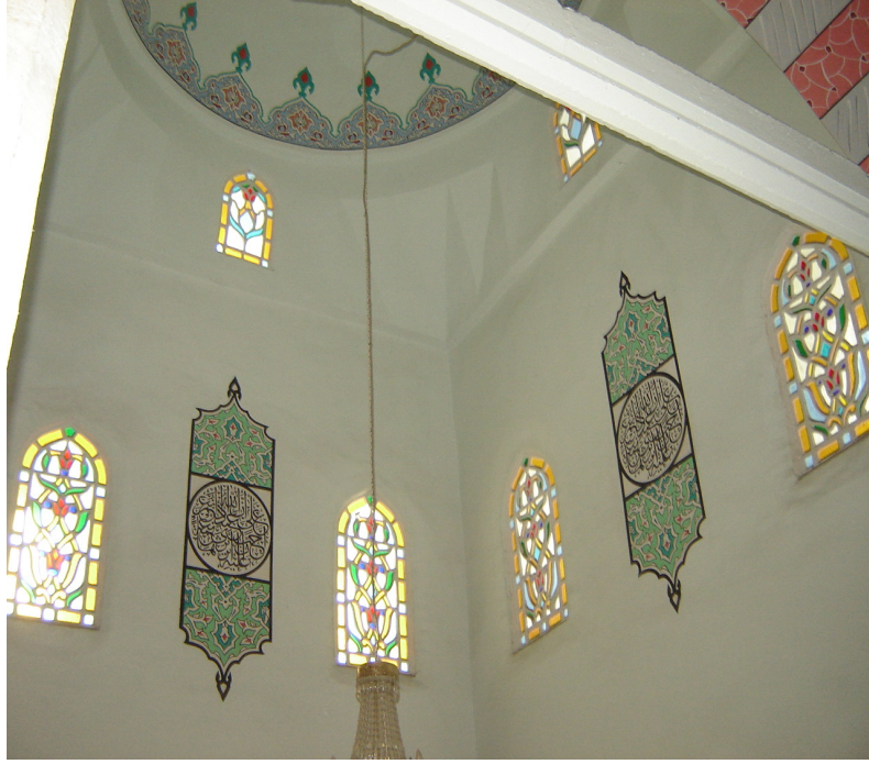
Resim 265 : Güzelce Hasan Bey Camii Yan Kubbe Geçiş Sistemi.
