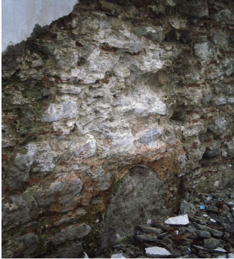
Resim 339 : Şarköy Hamamı Do ğu Duvarı Kapatılan Niş.
