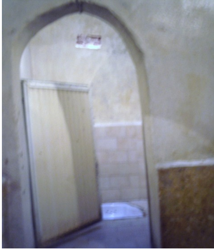
Resim 347 : Şarköy Hamamı Wc .
