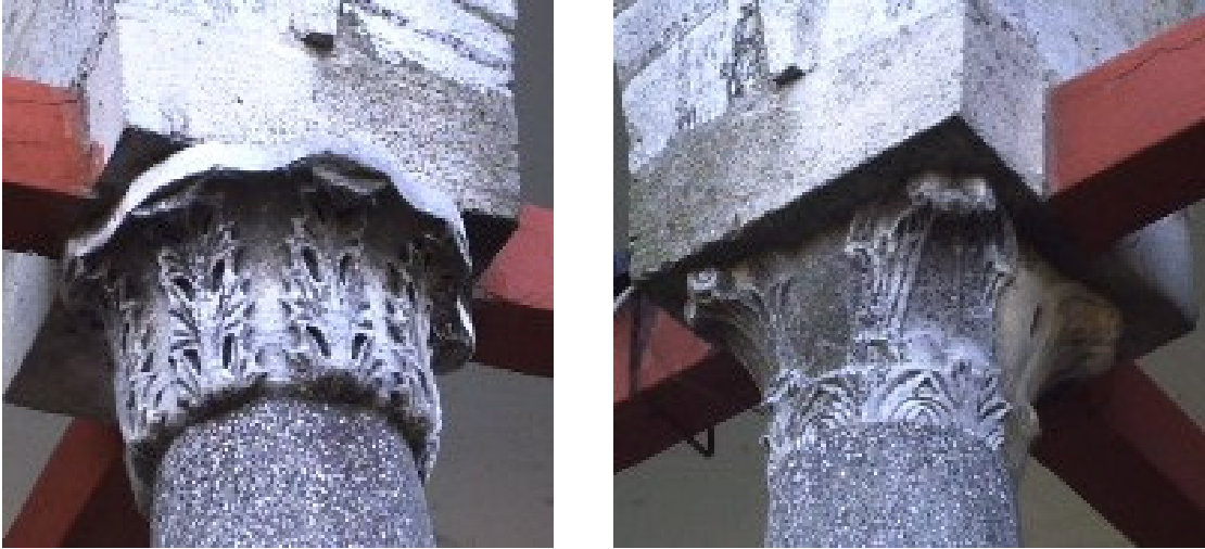
Resim 165,166 : Hüseyin Bey Camii Sütun Başlıkları (Sağdaki İmpost, Soldaki İon Biçimli).
