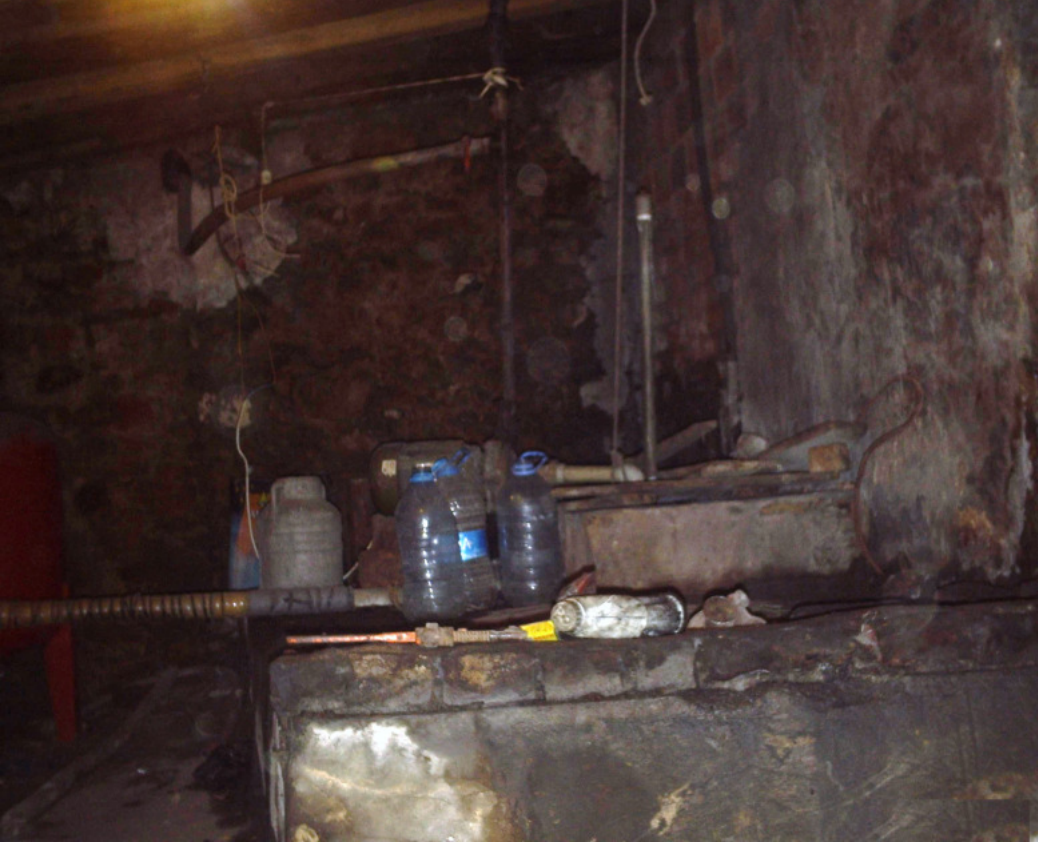
Resim 205 : Umur Bey Hamamı Külhan.
