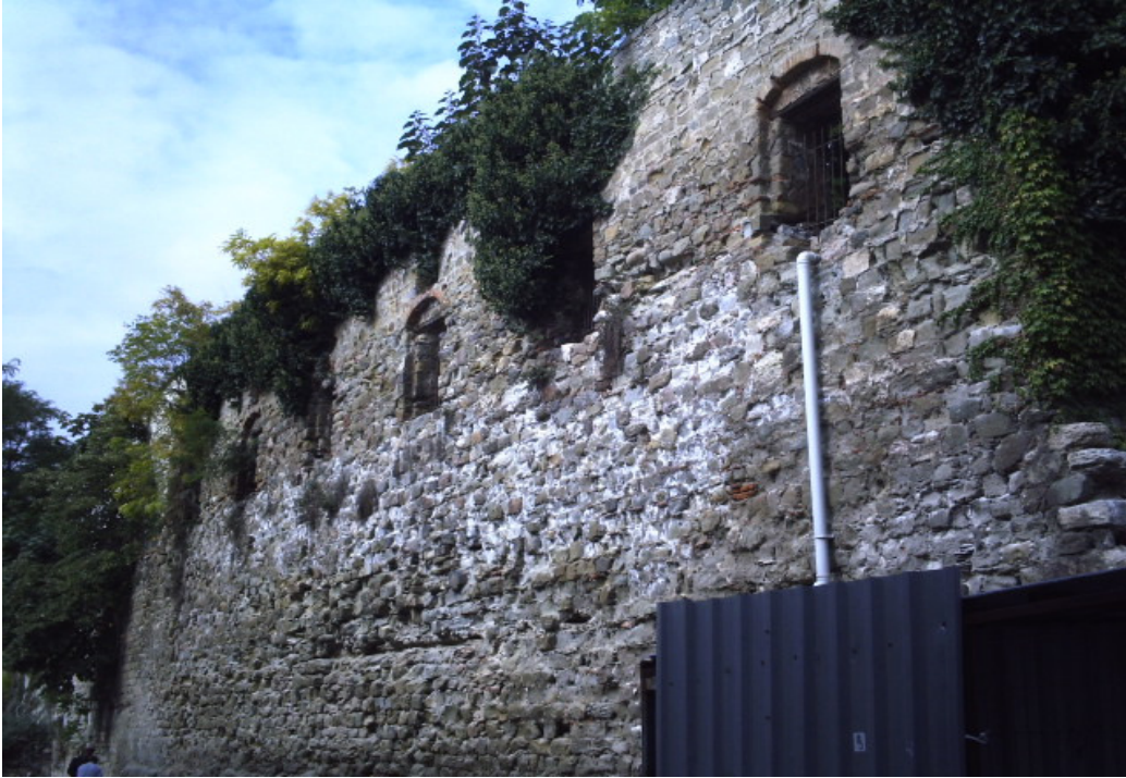
Resim 107 : Rüstem Paşa Medresesi Doğu Duvarı .
