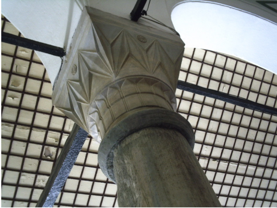
Resim 73: Rüstem Paşa Camii İç Revaklardaki Sütun Başlığı
