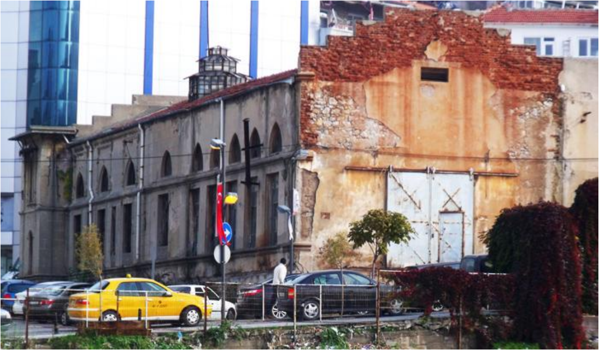
Yapıya sonradan ilave edilen ek kısımlar.
