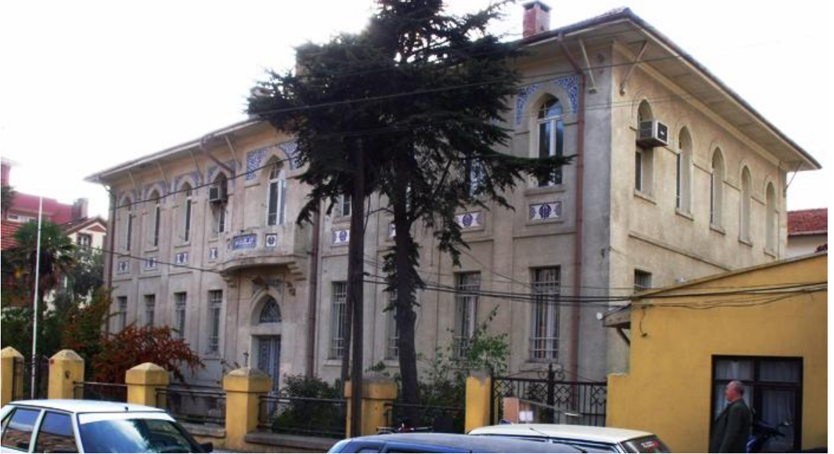
Yapının doğu ve kuzey cephesi.
