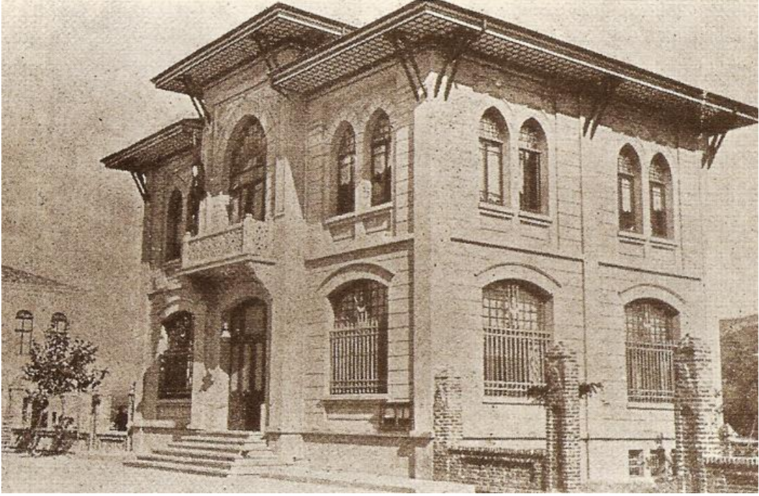
Yapının 1930 başlarındaki görünümü (Belediyeler 1933; Bozdoğan 2002: 55).
