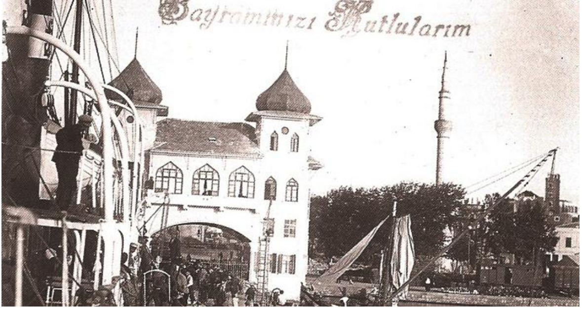
1926 yılına tarihlendirilen fotoğrafta Haydar Çavuş Camii henüz inşa edilmemiştir. İskele binası ise hali hazırda kullanılmaktadır (Vehçi Ersun).
