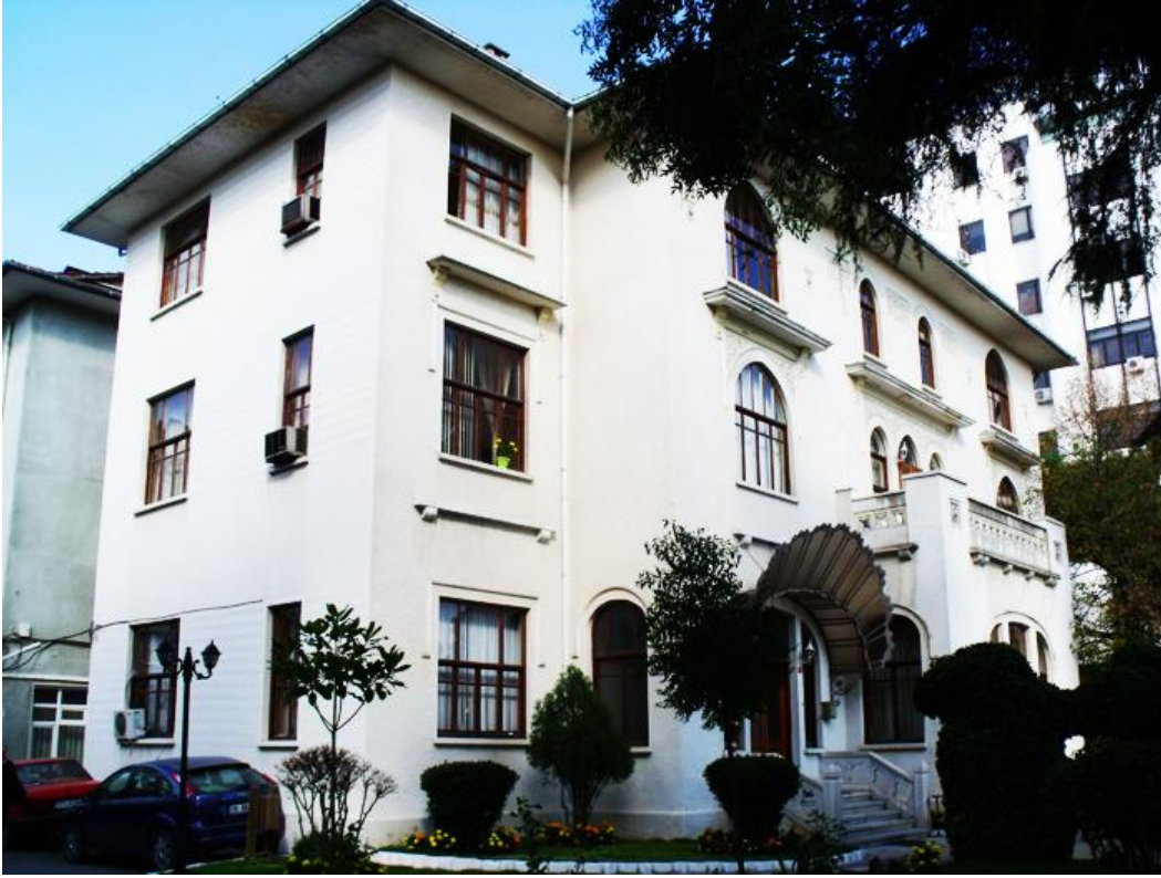
Yapının günümüzdeki görünümü, ön ve yan cephe, 2011.
