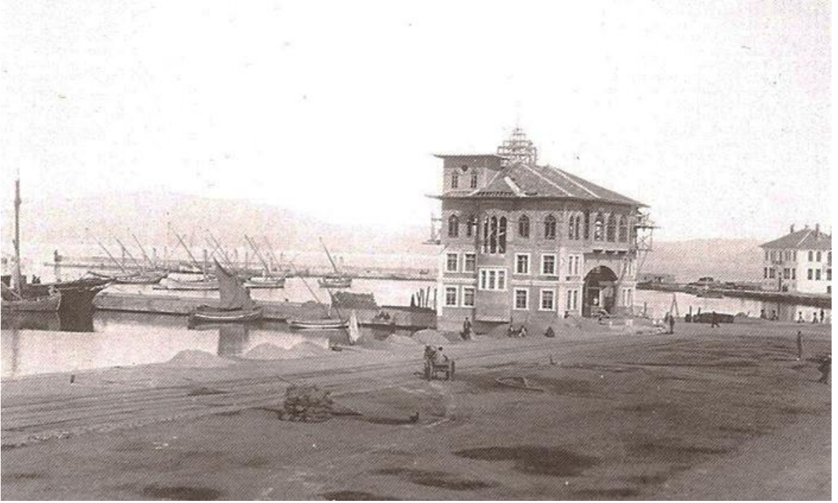
1926'ya tarihlendirilen fotoğrafta yapının son kat ve çatısı inşa edilirken (Vehçi Ersun).
