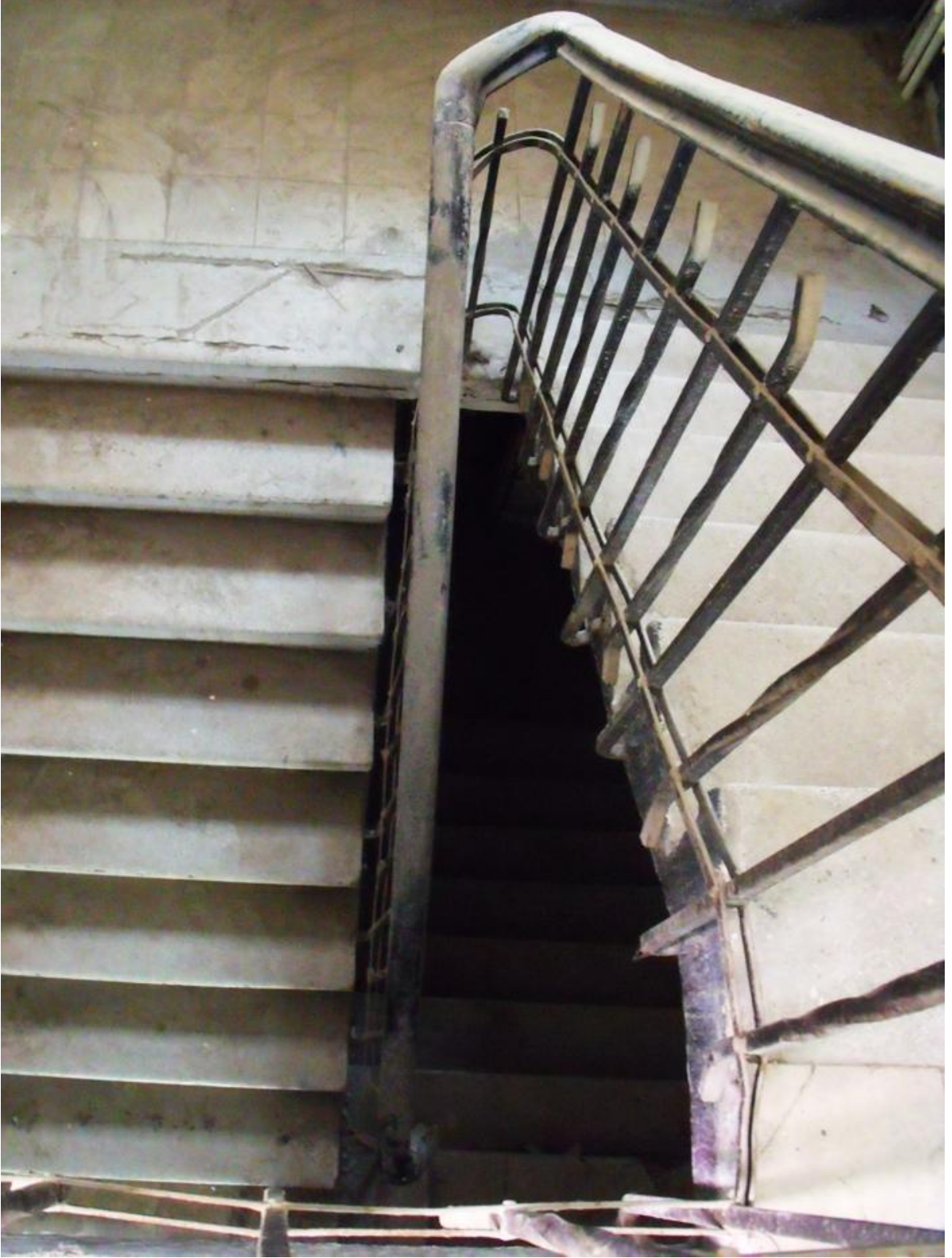
Yapının bodruma inen ve üst kata çıkan merdivenleri.
