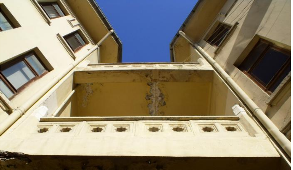
İç avluya bakan arka cephe ve süslemeli balkonları.
