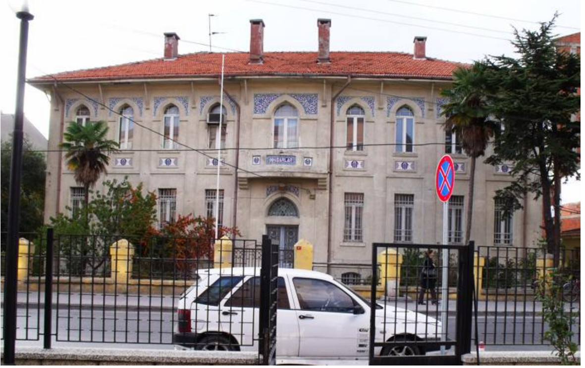
Tekel Başmüdürlük binasının ön cepheden günümüzdeki görünümü, 2011.
