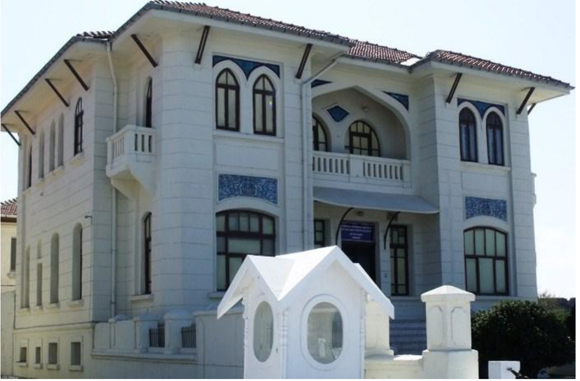
Yapının yaklaşık kuzeybatıya bakan ön cephesi ve kuzeydoğu yan cephesi, 2011.
