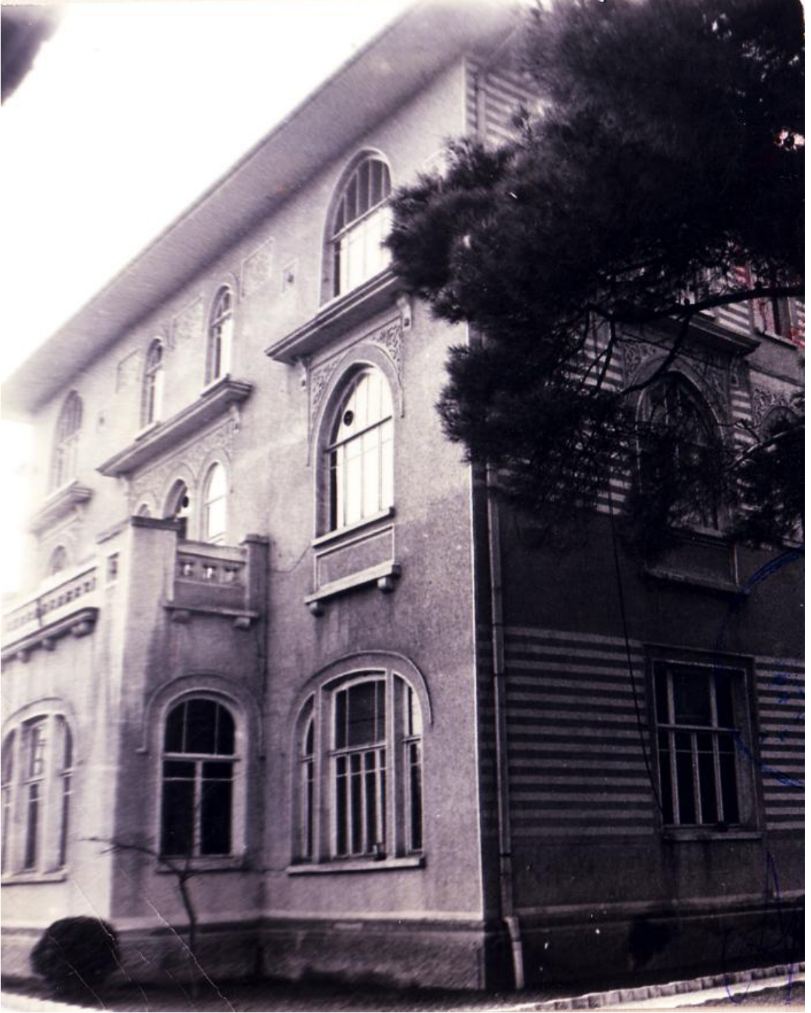
Yapının 1987'deki ön ve yan cephe görünümü (BİOM).
