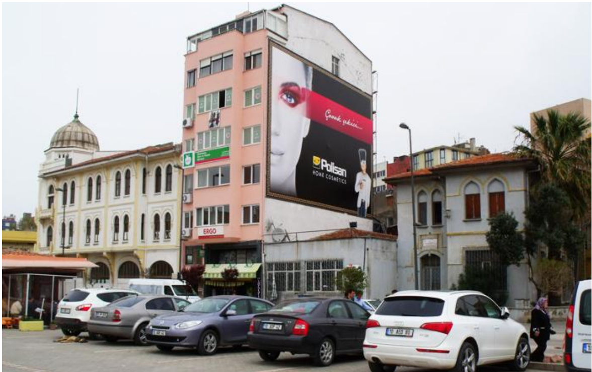
Posta ve Telgraf Merkezi ve hemen ilerisindeki kubbeli Maarif Oteli.
