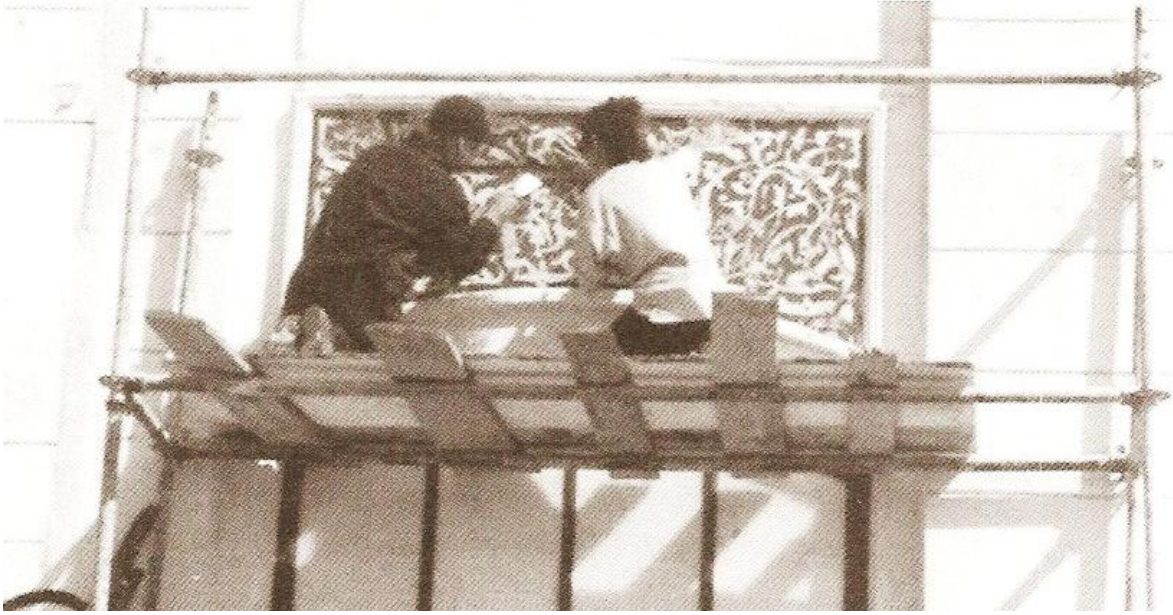
2000-2002 onarımlarında özgün çini panoların sökülmesi aşaması (Aktan 2008).
