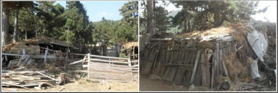
Fotoğraf 2.29. Solda yayla/mera alanında yer alan yarı kapalı küçükbaş hayvan barınağı, saya/ağıl, sağda kuru dallar ve naylon ile örtülü saya/ağıl çatısı. Kapaklı Yaylası/Keles, 2011.
