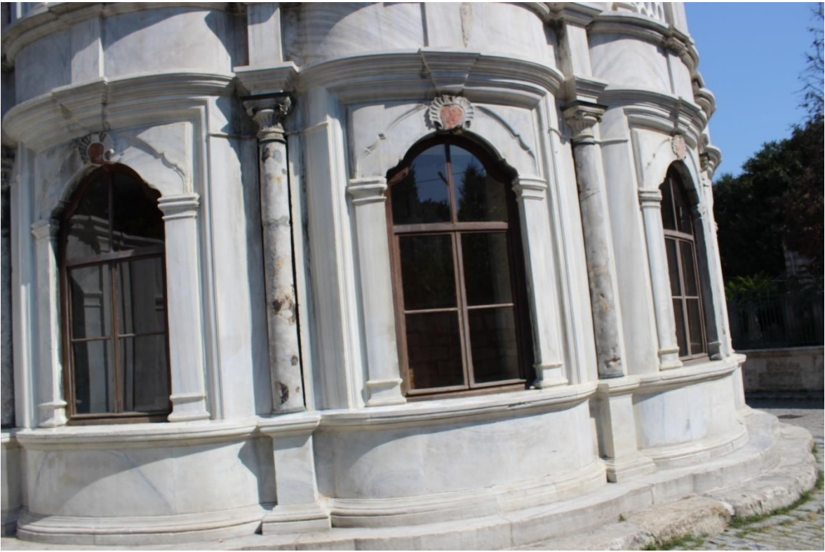
Resim 191: Mihrişah Valide Sultan Türbesi, demir şebekesi olmayan pencereler.
