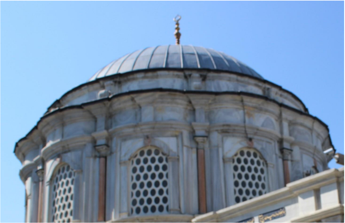
Resim 193: Mihrişah Valide Sultan Türbesi, üst örtü.
