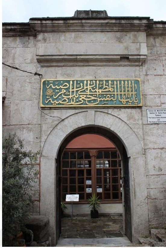
Resim 98: III. Mustafa Türbesi, avlu giriş kapısı.
