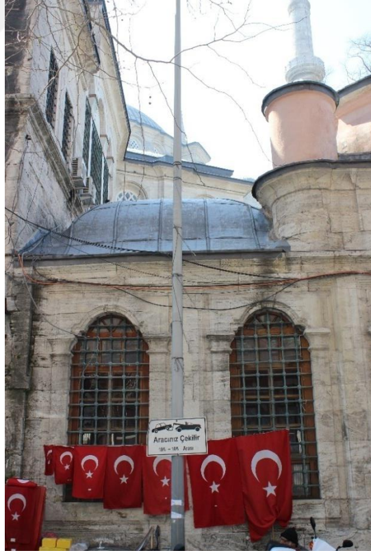
Resim 82: Nuruosmaniye Türbesi, ek türbe yapısı doğu cephe.
