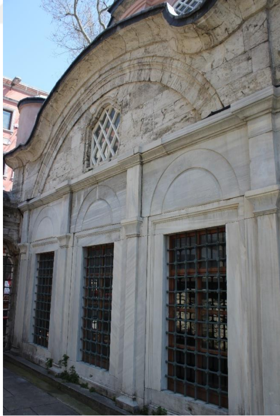
Resim 66: Nuruosmaniye Türbesi, kuzey cephe.
