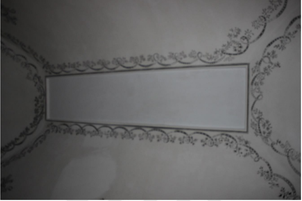
Resim 83: Nuruosmaniye Türbesi, ek türbe yapısı üst örtü.
