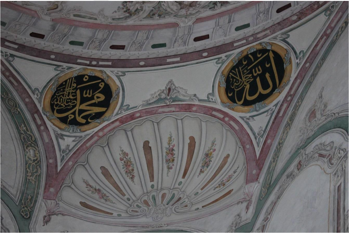
Resim 185: Sultan I. Abdülhamid Türbesi, kubbeye geçiş ögesi.
