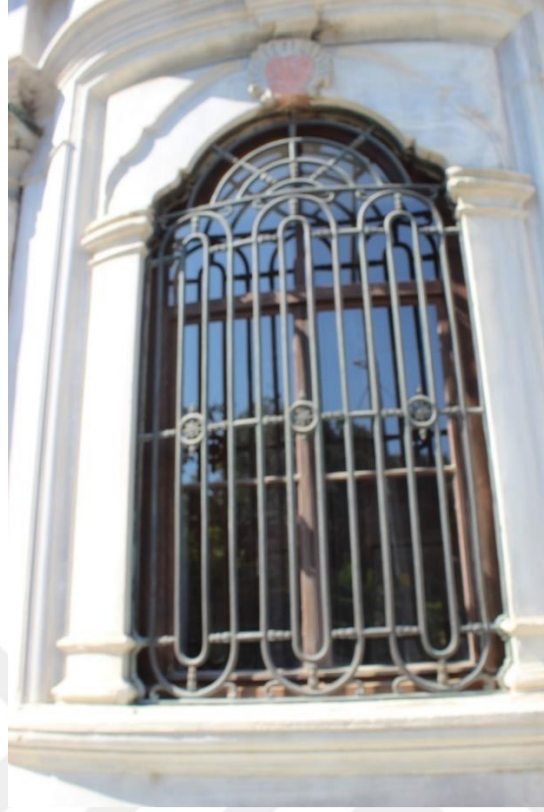
Resim 190: Mihrişah Valide Sultan Türbesi, alt sıra pencere.
