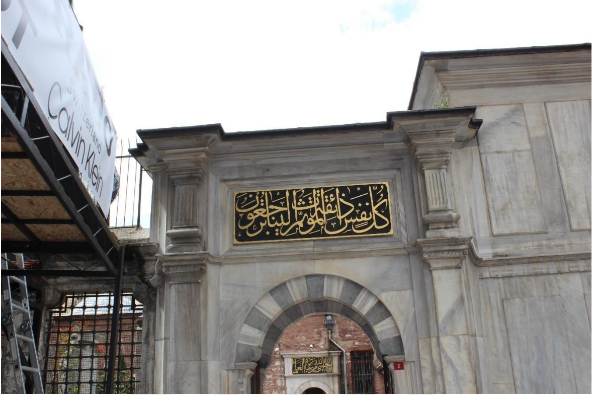
Resim 168: Sultan I. Abdülhamid Türbesi, avlu giriş kapısı üzerindeki kitabe.
