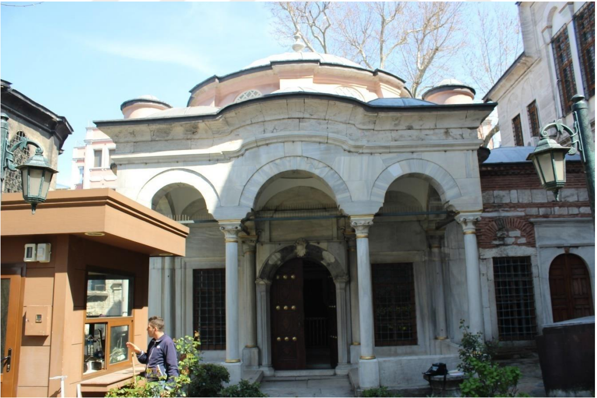
Resim 68: Nuruosmaniye Türbesi, revak bölümü.
