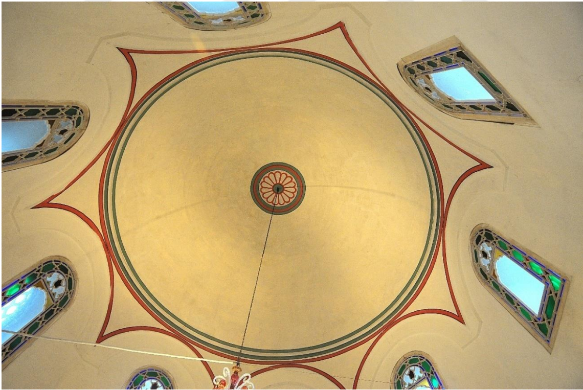
Resim 151: Gülbahar Hatun Türbesi, restorasyon öncesi kalemşileri (İstanbul Türbeler Müze Müdürlüğü arşivinden).
