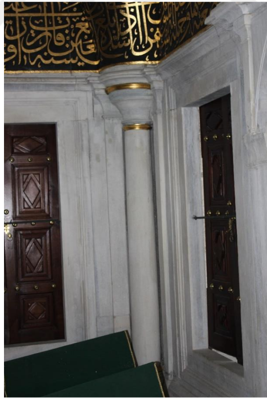
Resim 72: Nuruosmaniye Türbesi, köşelere yerleştirilen sütunlar.
